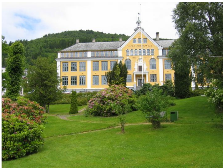
Hagen med hovedbygningen i bakgrunnen. Opphavsrett: Statsbygg.
