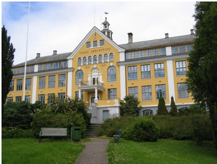
Høgskolens fasade mot syd med deler av parken i forgrunnen. Opphavsrett: Statsbygg.
