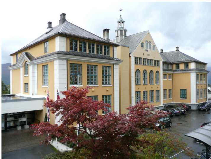
Fasade mot nord. Opphavsrett: Statsbygg.
