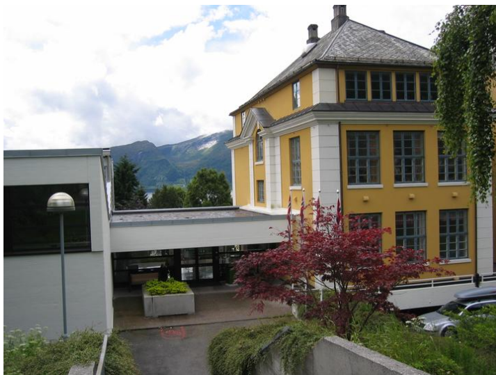
Østre fasade hvor nybygget (1982) er knyttet sammen med inngang i to plan. Opphavsrett: Statsbygg.
