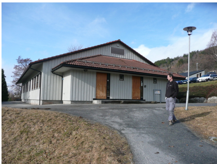
Nedretun. Opphavsrett: Statsbygg.
