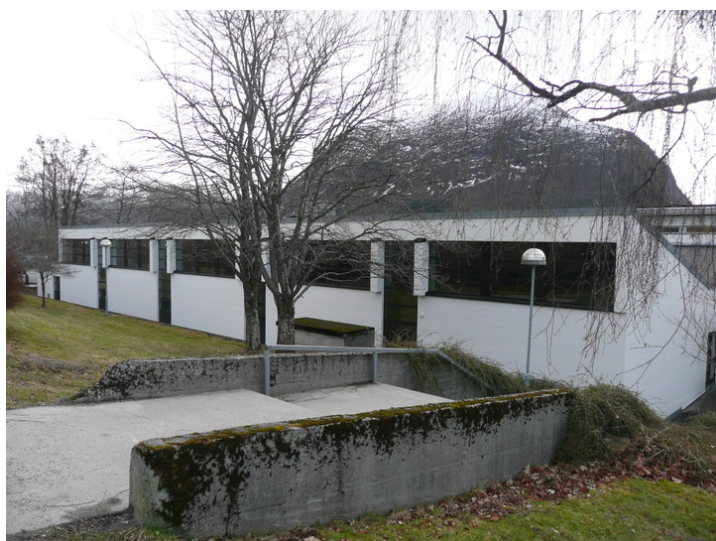
Fasade nord lærerskoletilbygg fra 1982 Opphavsrett: Statsbygg.
