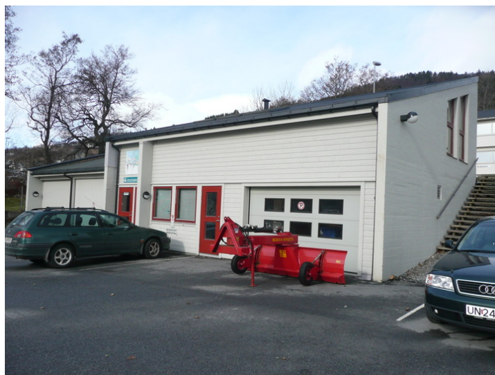
Driftsentralen. Opphavsrett: Statsbygg.
