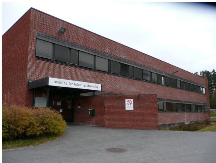
Sykepleierskolen - tilbygg fra 1975-76. Opphavsrett: Statsbygg.
