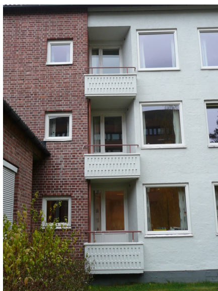
Balkonger til personaleleiligheter i internatfløyen. Opphavsrett: Statsbygg.
