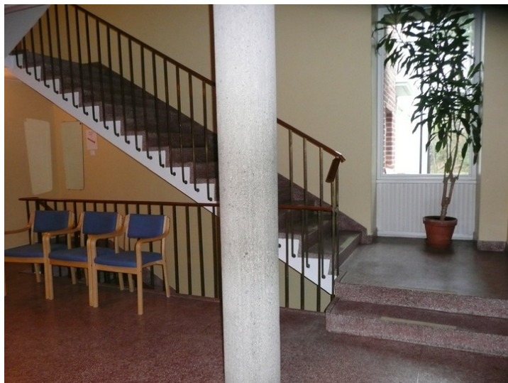
Trapp fra hallen i 1 etg som forbinder mellombygg og internattfløy. Opphavsrett: Statsbygg.
