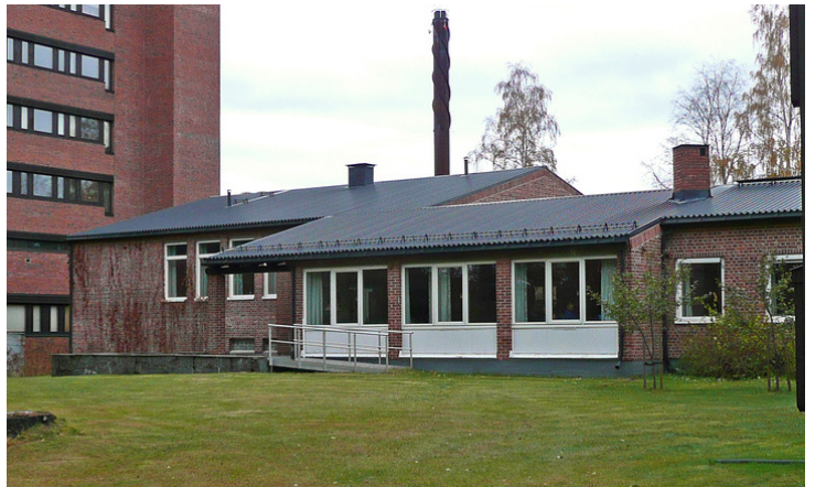
Undervisningsfløy fra 1957. Opphavsrett: Statsbygg.
