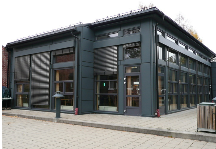
Kantine fra 1999, forbundet med 1957-bygningen som ses t v. Opphavsrett: Statsbygg.
