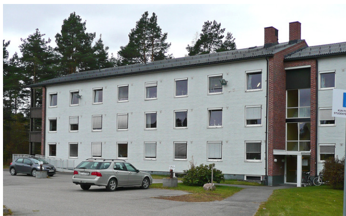
Internatet, søndre del til venstre. Opphavsrett: Statsbygg.
