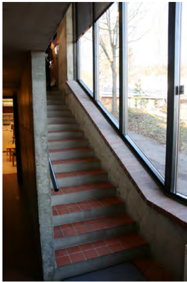
Trappetrinnene er flislagte. Opphavsrett: Statsbygg.
