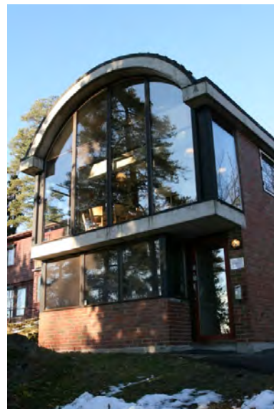
Kantineinngangen. Opphavsrett: Statsbygg.
