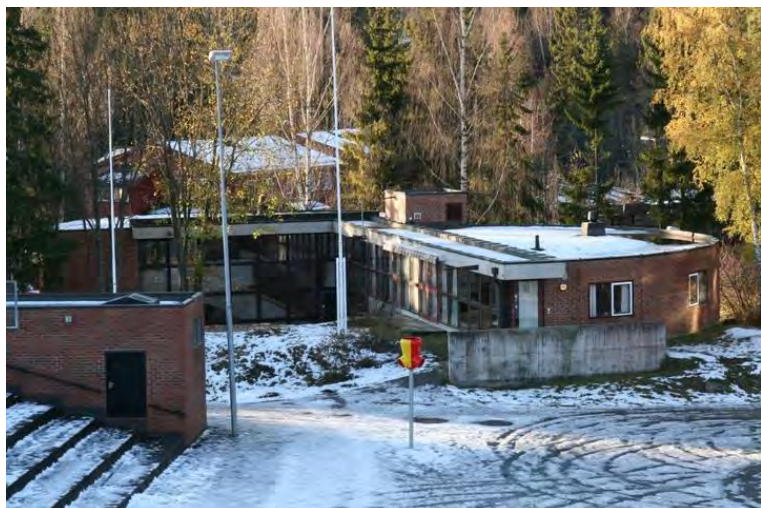
Observasjonsavdelingen sett fra tribunen på idrettsplassen. Opphavsrett: Statsbygg.
