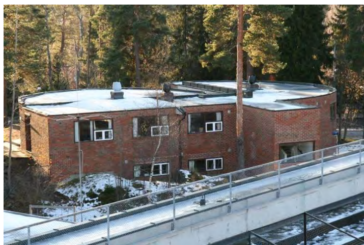
Førskolen sett fra tribunen til idrettsplassen. Opphavsrett: Statsbygg.
