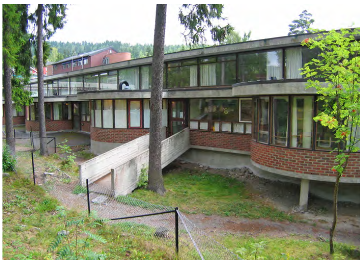
Sørfløyen mot vest. Opphavsrett: Statsbygg.
