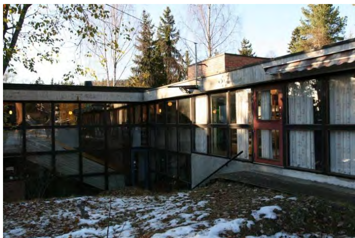
Fasader mot øst og syd. Opphavsrett: Statsbygg.
