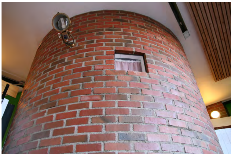
Et lite toalett er plassert i trappeoppgangen. Opphavsrett: Statsbygg.
