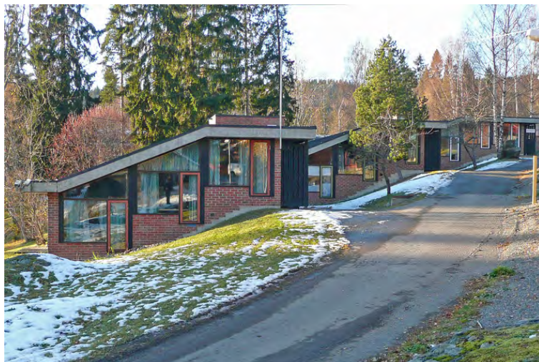
Bikuben og andre internater. Opphavsrett: Statsbygg.
