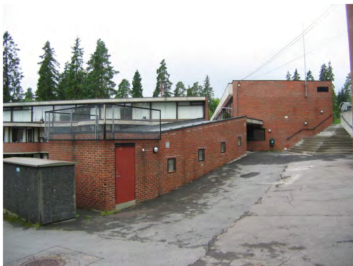
Forbindelse mellom fløyene. Opphavsrett: Statsbygg.
