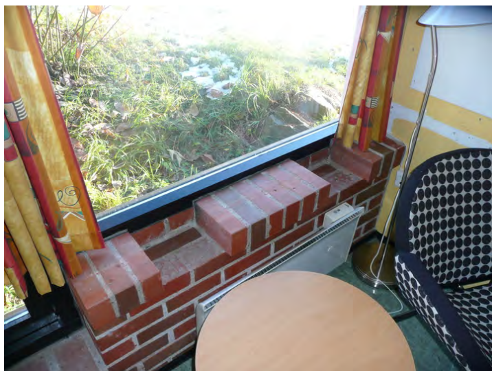
Detalj vinduskarm i Ekorntoppen. Opphavsrett: Statsbygg.
