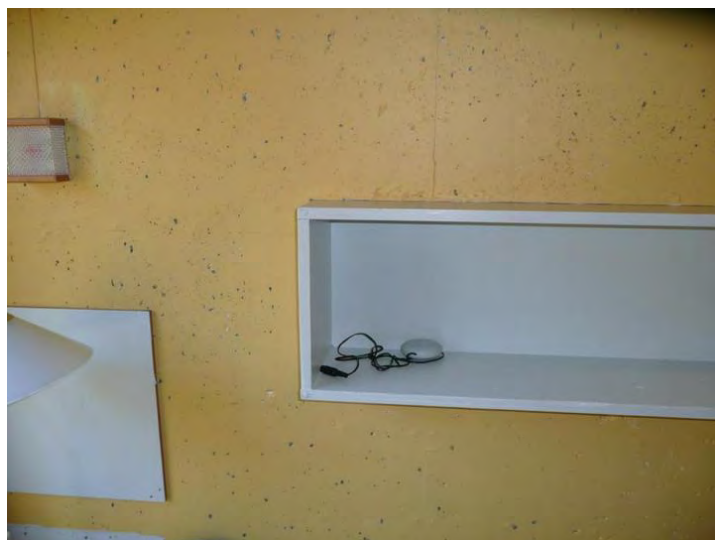
Innebygde hyller på soverom. Opphavsrett: Statsbygg.
