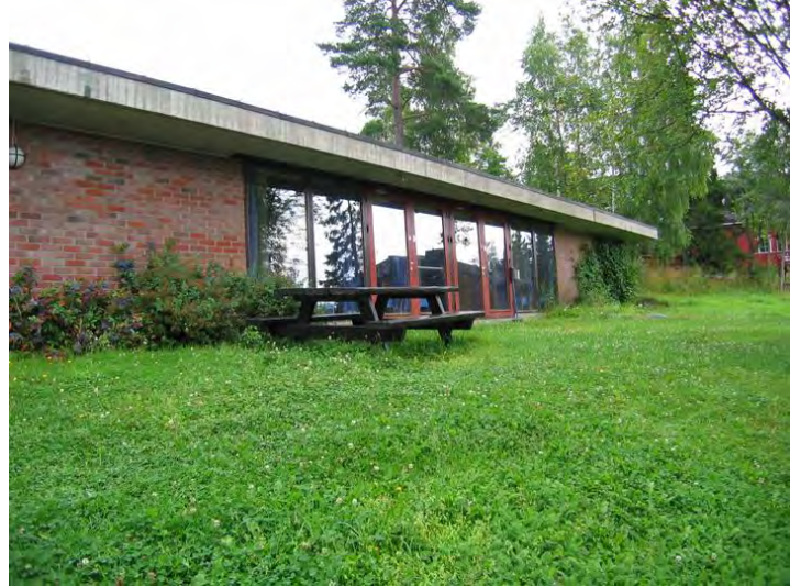
Sørfasaden med vinduer mot fellesrommet. Opphavsrett: Statsbygg.
