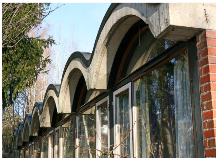
Ett internatrom for hver bue. Opphavsrett: Statsbygg.
