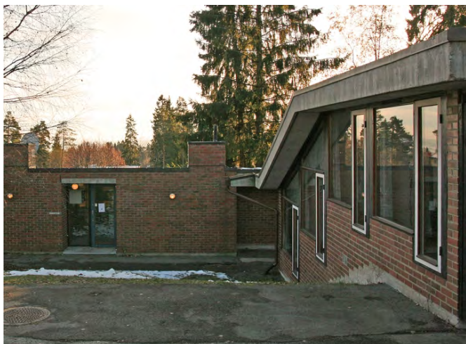
Revehiet har hvite vindusrammer. Opphavsrett: Statsbygg.
