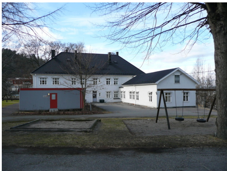
Fasade sørøst. Opphavsrett: Statsbygg.
