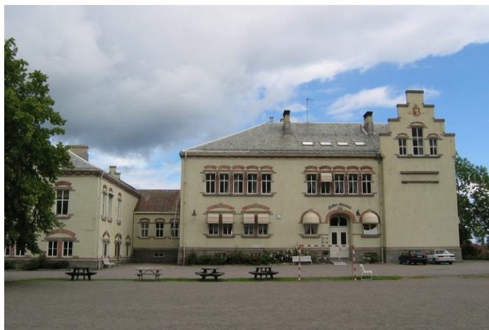
Hovedbygget fasade vest. Opphavsrett: Statsbygg.
