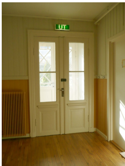
Gammel hoveddør. Opphavsrett: Statsbygg.
