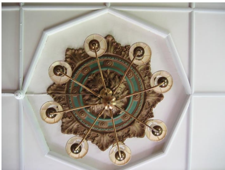
Rosetten i taket antas å være original. Her kan man også se at taket er blitt senket ca. 10 cm. Opphavsrett: Statsbygg.
