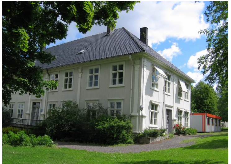
Hjørne nord/vest. Opphavsrett: Statsbygg.
