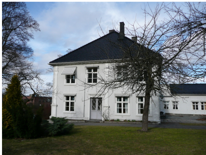
Fasade sørvest. Opphavsrett: Statsbygg.
