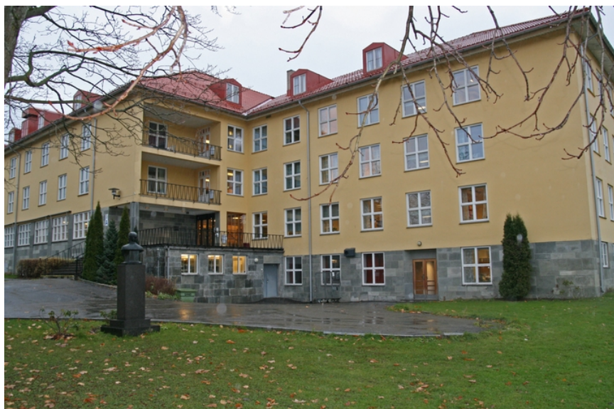
Hovedbygningen i nøktern og solid 1950-talls arkitektur. Opphavsrett: Statsbygg.
