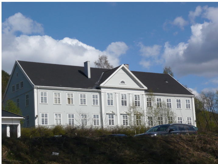
Fasade mot vest. Gavlvegg mot nord. Opphavsrett: Statsbygg.
