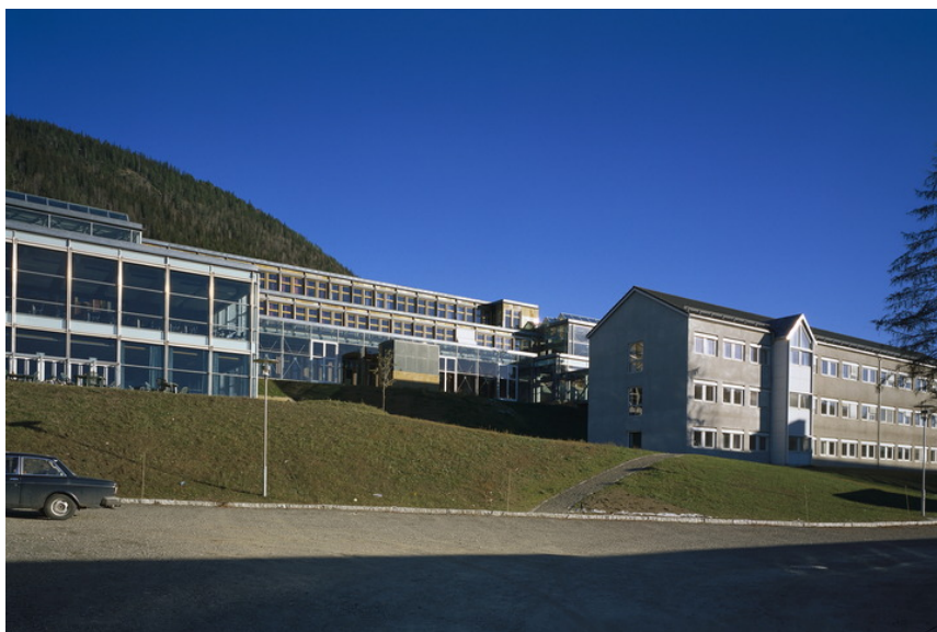
Deler av Hove. Fasade mot vest. Opphavsrett: Statsbygg.
