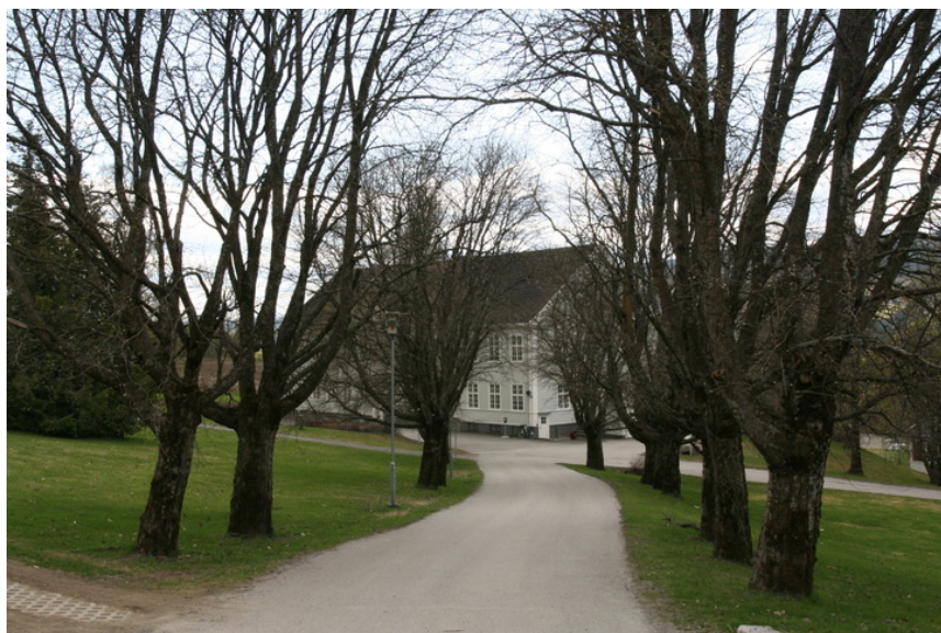
Gamlebygget sett fra nord/øst gjennom alle. Opphavsrett: Statsbygg.
