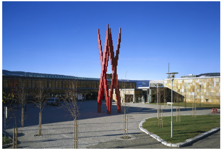
Hovedadkomsten. Opphavsrett: Statsbygg.
