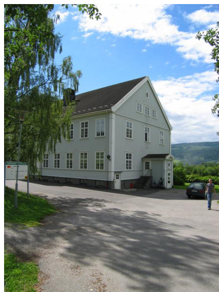
Fasade mot nord. Opphavsrett: Statsbygg.
