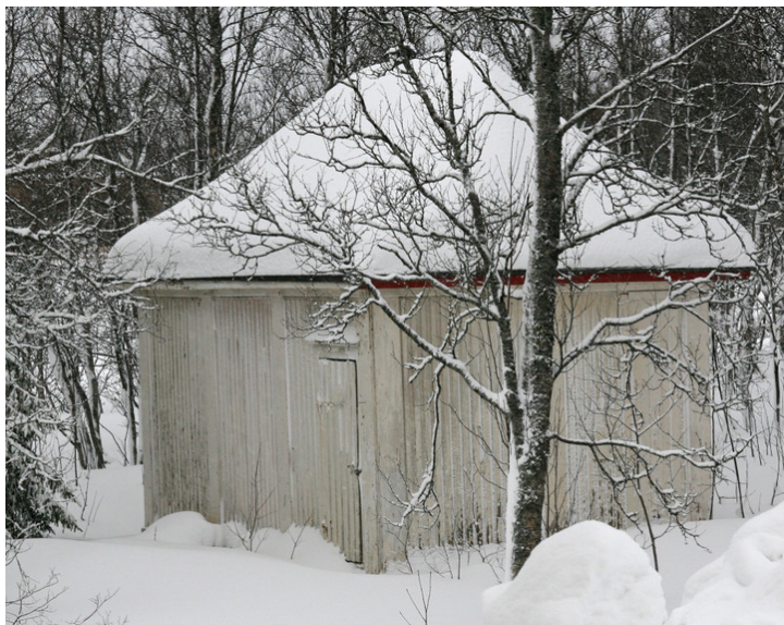
Magnethus. Opphavsrett: Statsbygg.
