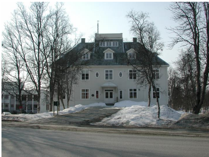
Fasade nord - sett fra Langnesveien. Opphavsrett: Statsbygg.
