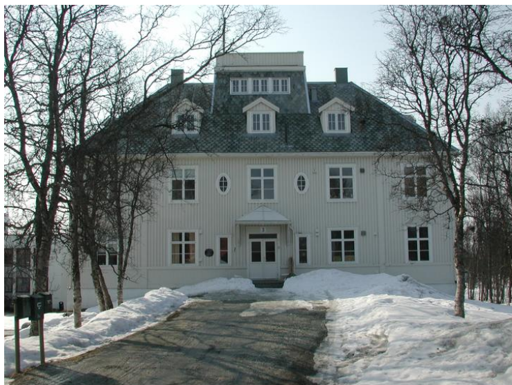
Hovedfasaden vender mot nord. Opphavsrett: Statsbygg.
