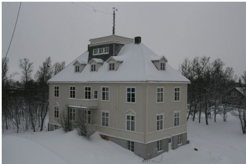
Fasader mot sør og øst. Opphavsrett: Statsbygg.
