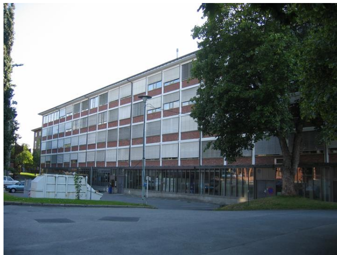
Fasade mot gårdsrommet, 1962-delen. Opphavsrett: Statsbygg.
