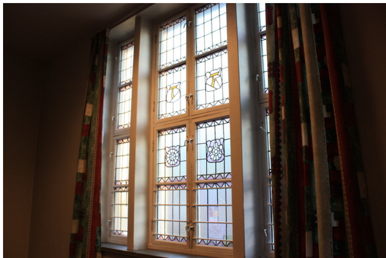
Blyglassvinduer med "T F" - skolens initialer. Opphavsrett: Statsbygg.
