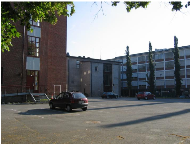
Sverresgate 10 til venstre, Retortbygningen midt i bildet og Gunnerusgt 1 til høyre. Opphavsrett: Statsbygg.
