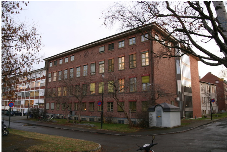
Trondhjem mellomtekniske skole fra 1930. Opphavsrett: Statsbygg.
