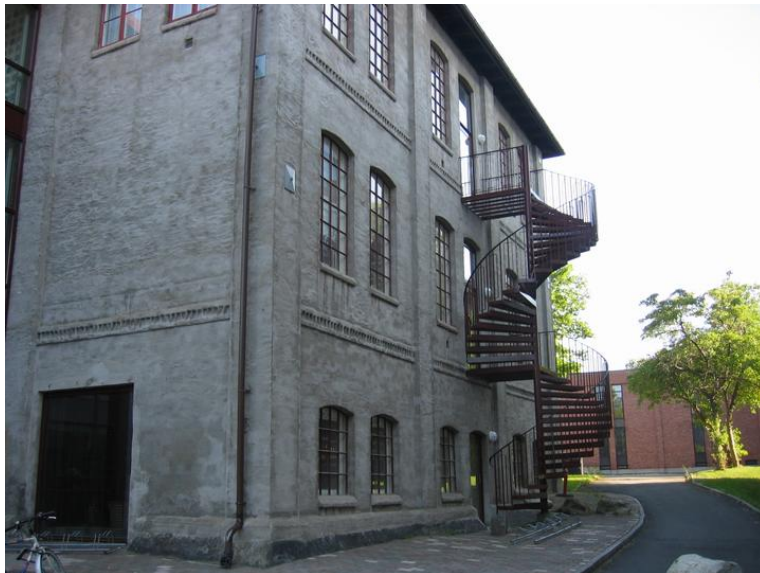
Vestre fasade med ny rømningstrapp. Opphavsrett: Statsbygg.
