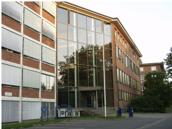
Vestre fasade med inngangspartiet fra 1992 som binder de to byggetrinnene sammen. Opphavsrett: Statsbygg.
