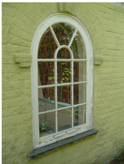
Detaljbilde av vindu. Opphavsrett: Statsbygg.
