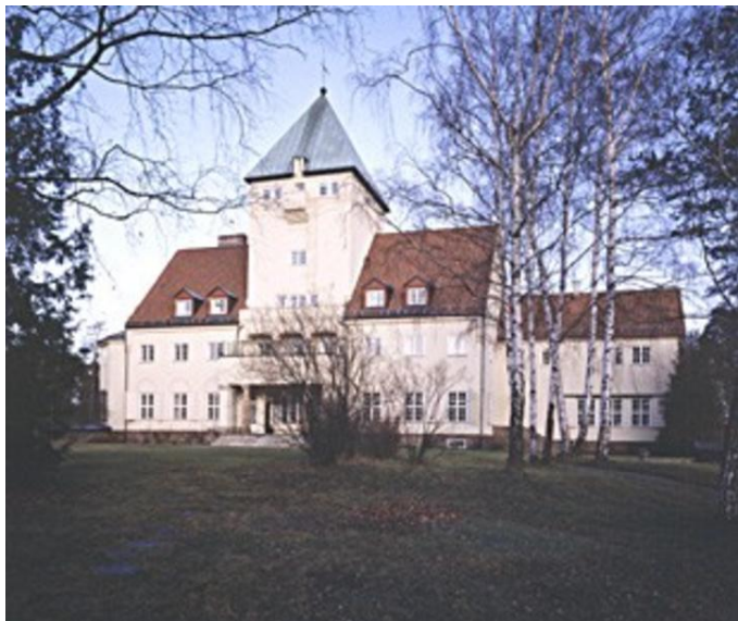
Sett fra syd Opphavsrett: Statsbygg.
