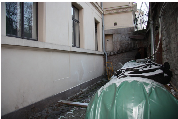
Lyssjakt foran vestfløyen. Opphavsrett: Statsbygg.
