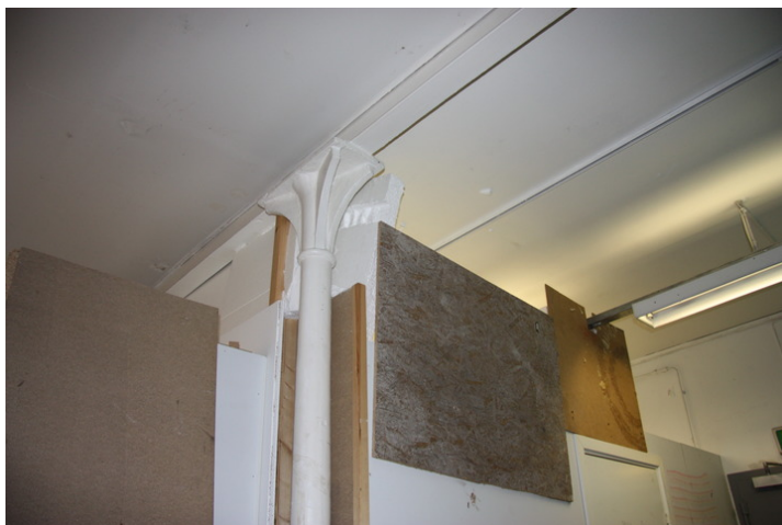
Stålbjelker i 1. etasje. Opphavsrett: Statsbygg.
