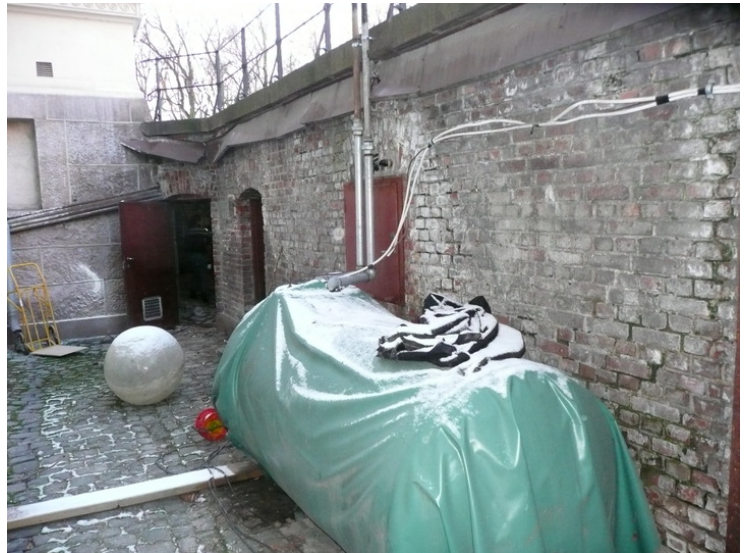
Lyssjakter langs nordvestre fløy på begge sider av hovedinngangen for å gi lys ned i underetasjen, og som adkomst til kulvertene som var rom under gateplan til oppbevaring av kull og ved. Opphavsrett: Statsbygg.
