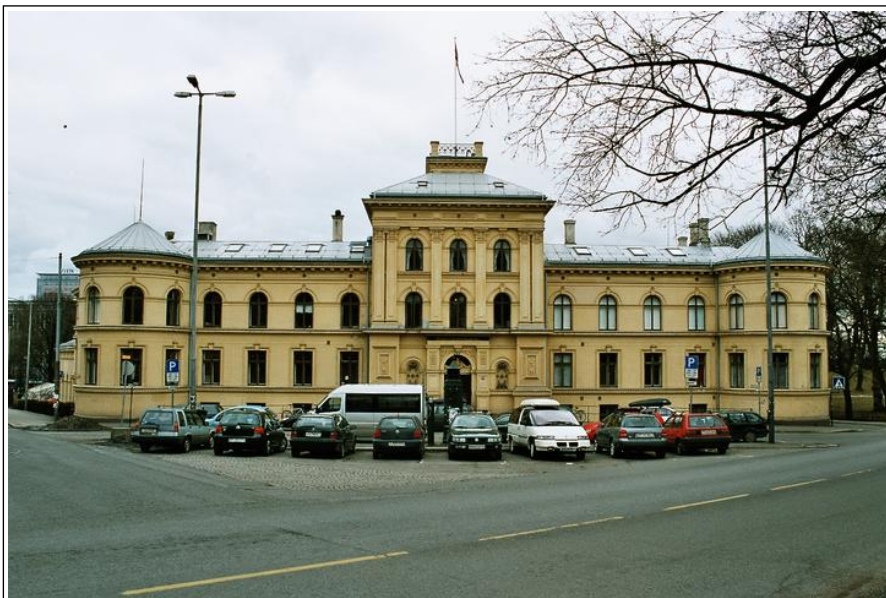
Bildet viser Statens Kunstakademis fasade mot vest og hovedinngang mot Nordraaks plass. Opphavsrett: Statsbygg.
