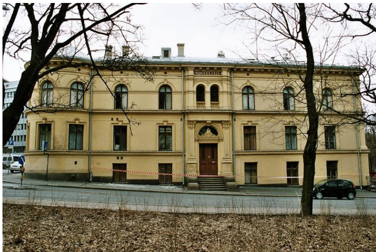
Fasade mot syd. Opphavsrett: Statsbygg.
