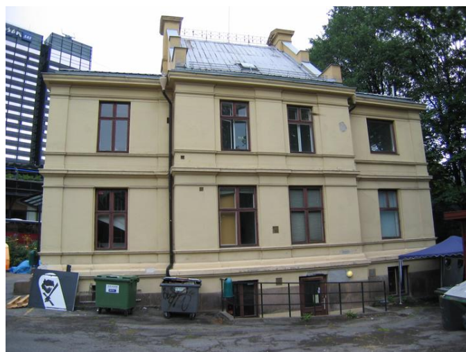
Fasade mot uteanlegg i syd. Opphavsrett: Statsbygg.
