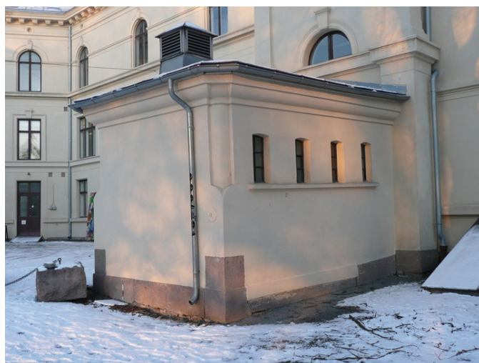
Tilbygg på nordre fløy mot bakgård var opprinnelig utedoer (priveter). WC for alle ble installert først i 1954. Opphavsrett: Statsbygg.
