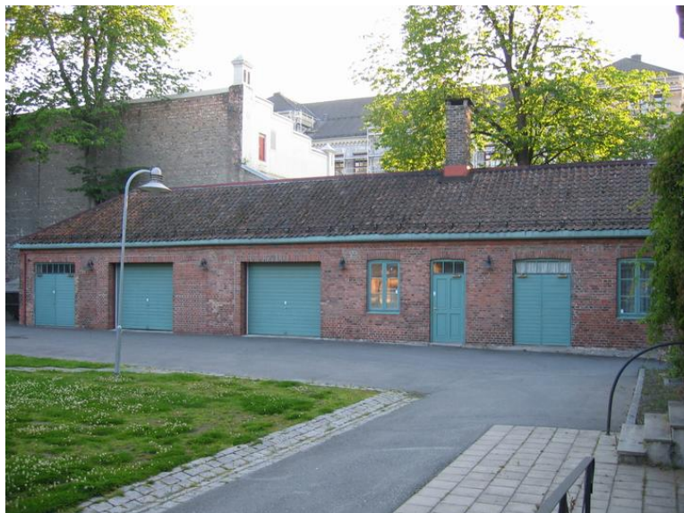
Garasjebygningens fasade mot gårdsrommet. Opphavsrett: Statsbygg.
