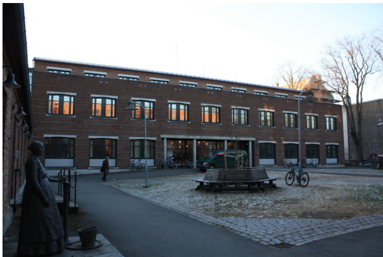
Fasade mot skolegården. Opphavsrett: Statsbygg.
