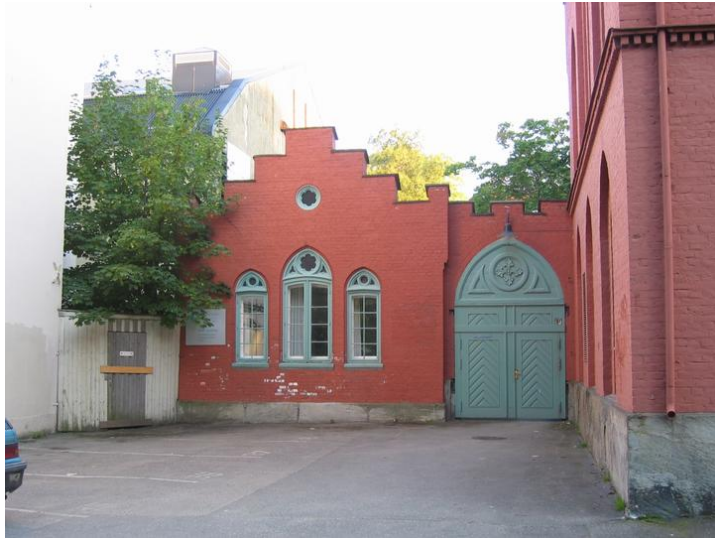
Vaskeribygningens fasade mot Bispegata. Opphavsrett: Statsbygg.
