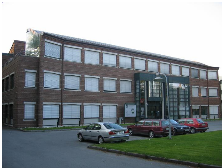
Høgskolebygningen fra 1995, fasade mot Arkitekt Christies gate. Opphavsrett: Statsbygg
