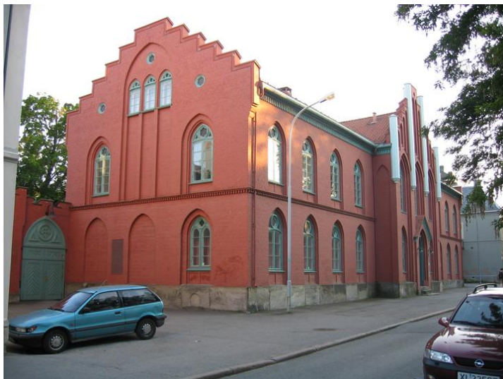
Fasade mot Bispegata med inngang til gårdsrommet ved vaskeribygningen. Opphavsrett: Statsbygg.
