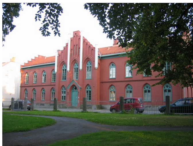
Den gamle døveskolens fasade mot Bispegata. Opphavsrett: Statsbygg.
