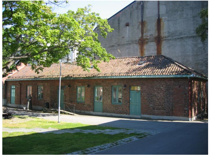
Vaskeribygningens fasade mot gårdsrommet. Opphavsrett: Statsbygg.
