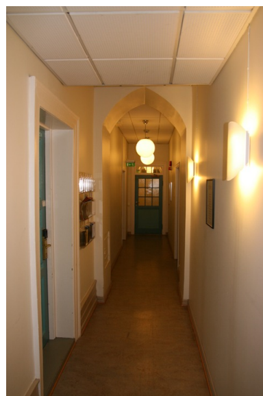
Spissbue i innvendig bærevegg. Opphavsrett: Statsbygg.
