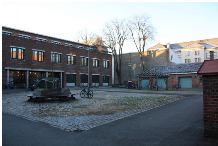
Skolegården er innrammet av fire bygninger. Opphavsrett: Statsbygg
