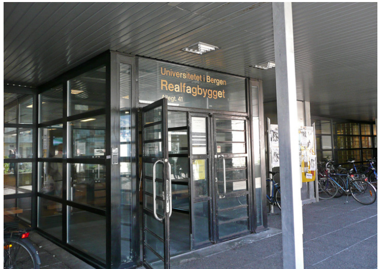
Inngangsparti (i u-etg) fra Allégt. Opphavsrett: Statsbygg.
