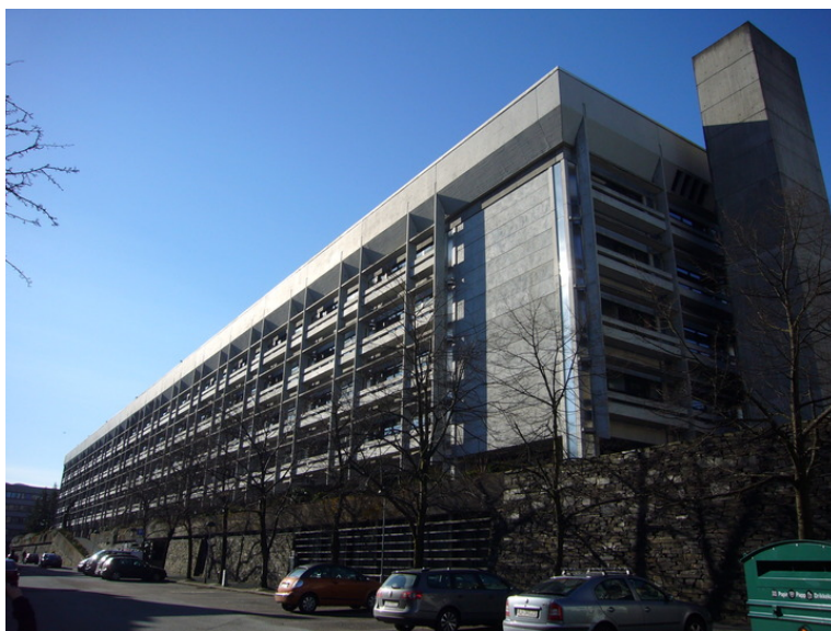
Realfagbygget sett fra nord. Opphavsrett: Statsbygg.
