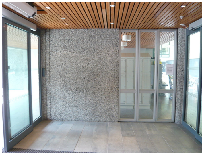
Interiøret er typisk for det tidlige 1960-tallets modernistiske arkitektur. Rommet har en enkel karakter og preges av solide slitesterke materialer valgt med tanke på rommets funksjon. Opphavsrett: Statsbygg.
