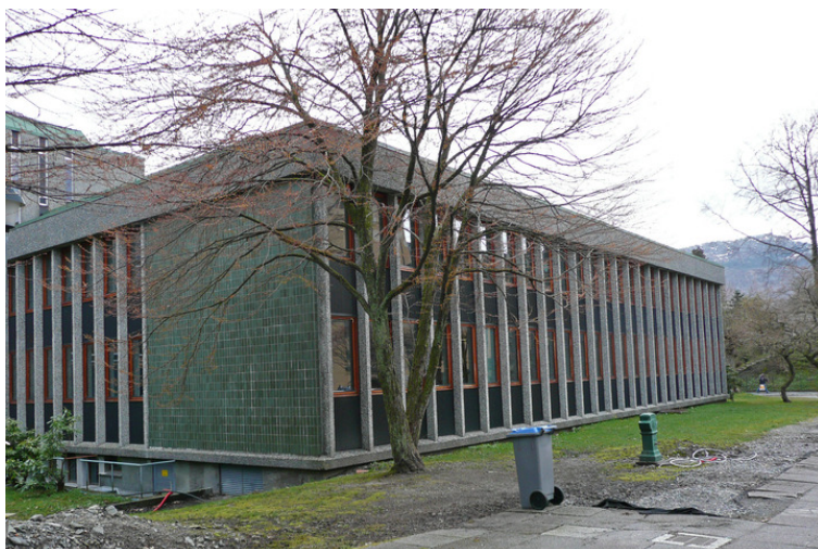
Deler av fasaden er kledt med keramiske fliser. Her sett fra øst. Opphavsrett: Statsbygg.
