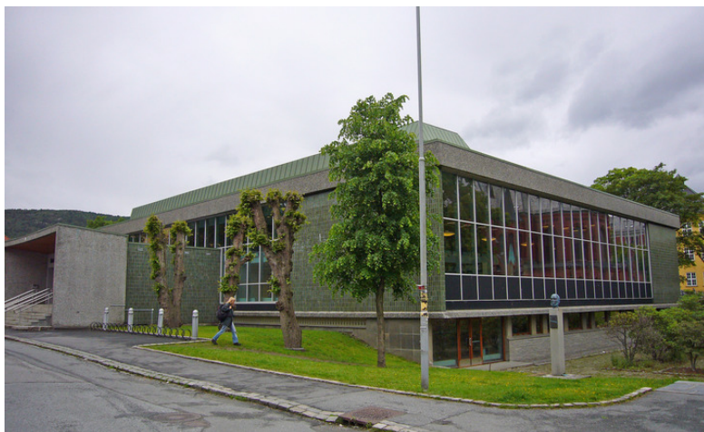
Deler av fasaden er kledd med keramiske fliser. Her sett fra øst. Opphavsrett: Statsbygg.
