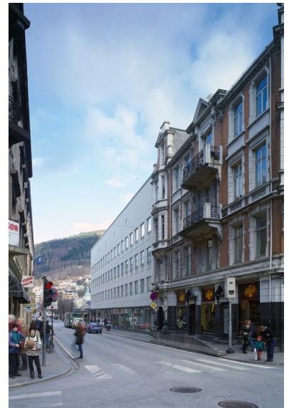
Christies gate retning nordøst. Foto: Jiri Havran. Opphavsrett: Statsbygg.
