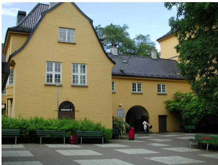
Fasade mot sør, inngang til borggården. Opphavsrett: Statsbygg.
