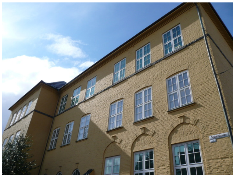
Del av fasade mot Sydneshaugen. Opphavsrett: Statsbygg.
