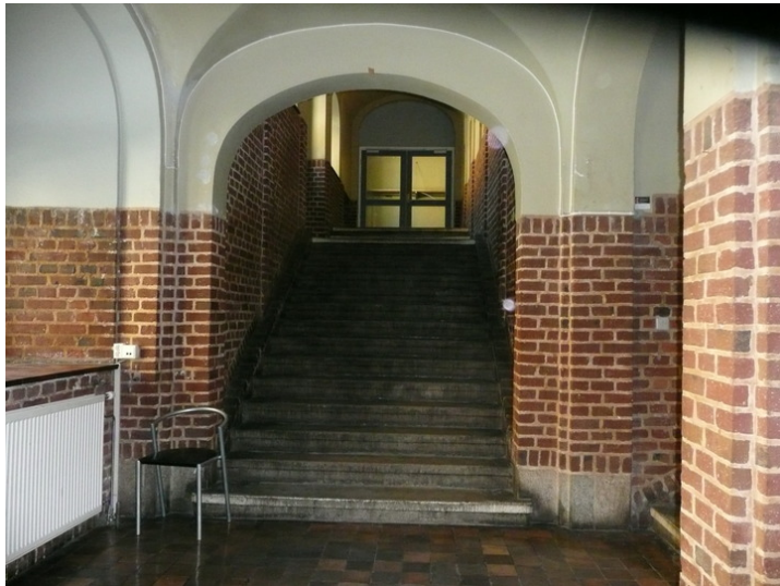
Del vestibyle, typisk materialutførelse. Opphavsrett: Statsbygg.
