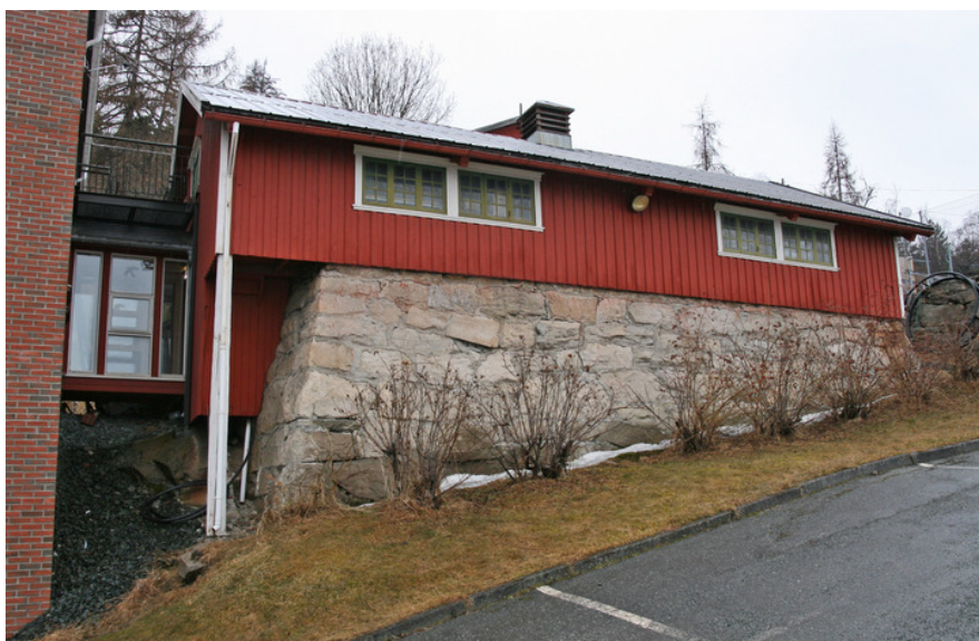
Det murete bassenget med treoverbygg og nyere tilkobling til stasjonsbygningen. Opphavsrett: Statsbygg.
