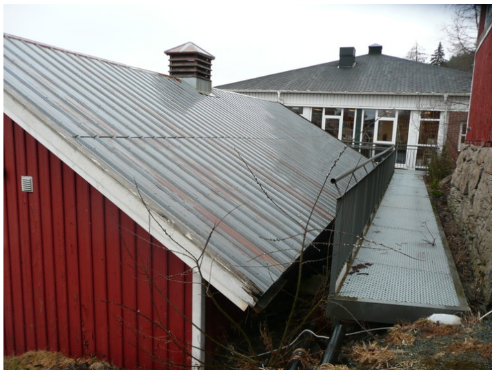
Luftpipe tilpasset fuktig innelima. Opphavsrett: Statsbygg
