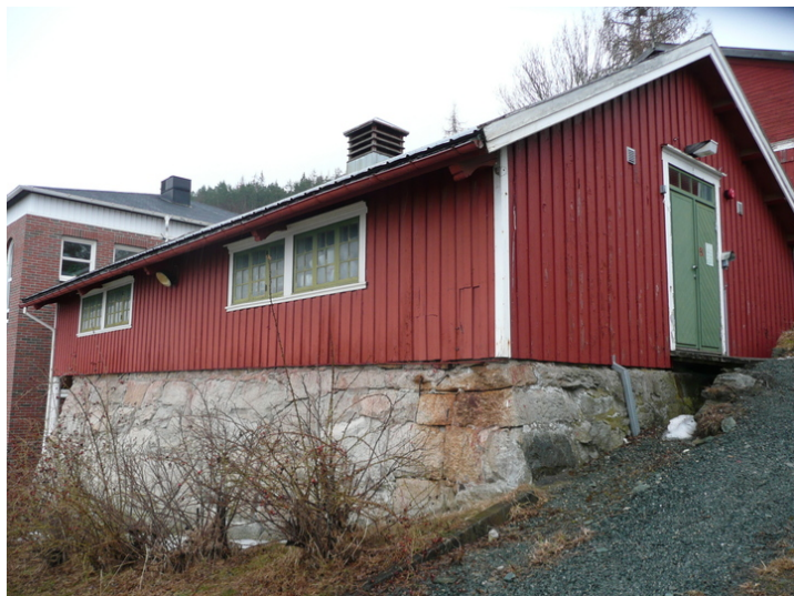
Innebasseng, sett fra nordøst. Til venstre trinn 2 av kontor/forskningsbygg. Opphavsrett: Statsbygg.
