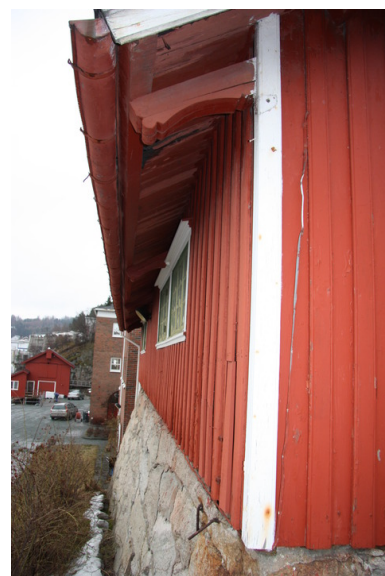
Her vises tidstypisk sveitserprofil på sperreutstikk og kledning. Opphavsrett: Statsbygg.
