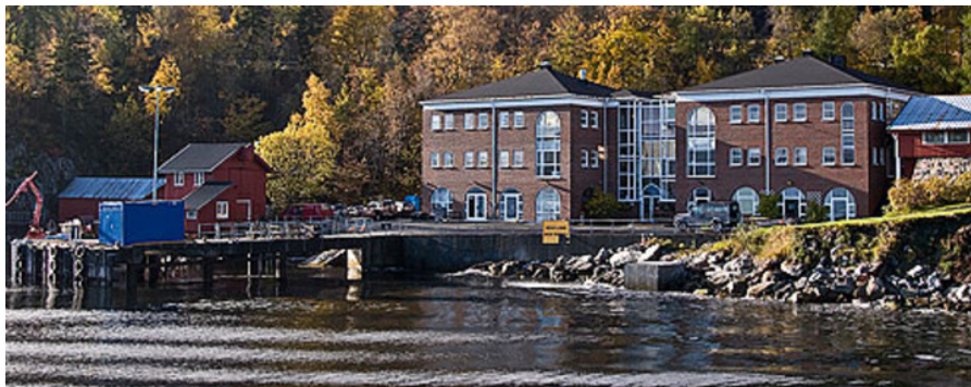
Anlegget sett fra øst. Fra venstre: ny kai, verksted, trinn 1 og 2, innebasseng. Opphavsrett: NTNU.
