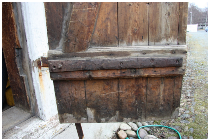
Detalj dør. Opphavsrett: Statsbygg.
