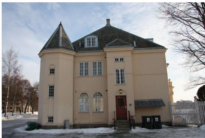
Fasade mot nordvest. Opphavsrett: Statsbygg.
