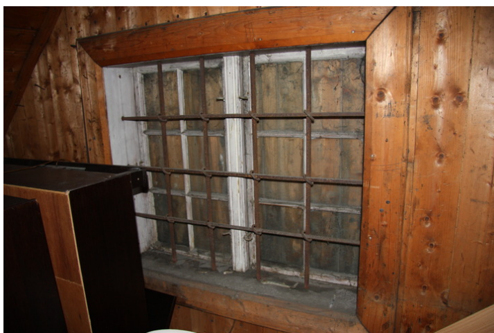
Vindu fra innsiden. Opphavsrett: Statsbygg.
