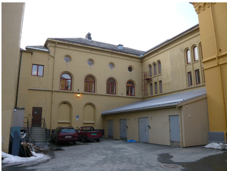
Gårdsrommet sett mot vest. Tilbygget i en etasje er av nyere dato og omfattes ikke av fredning eller vern. Opphavsrett: Statsbygg.
