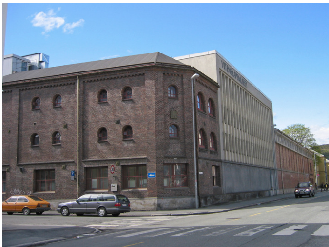
Schøningshusets eldste del er teglbygningen til venstre. Foto: Arne Rønning. Opphavsrett: NTNU.
