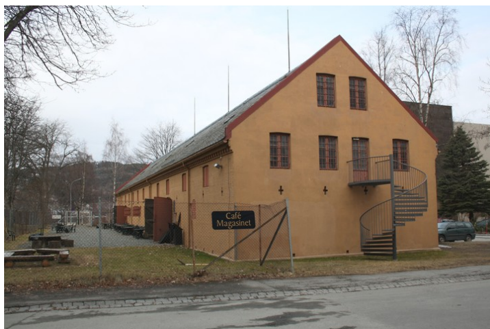
Fasade mot øst. Opphavsrett: Statsbygg.
