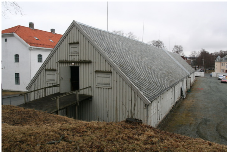
Gavl med bro til loft. Opphavsrett: Statsbygg.
