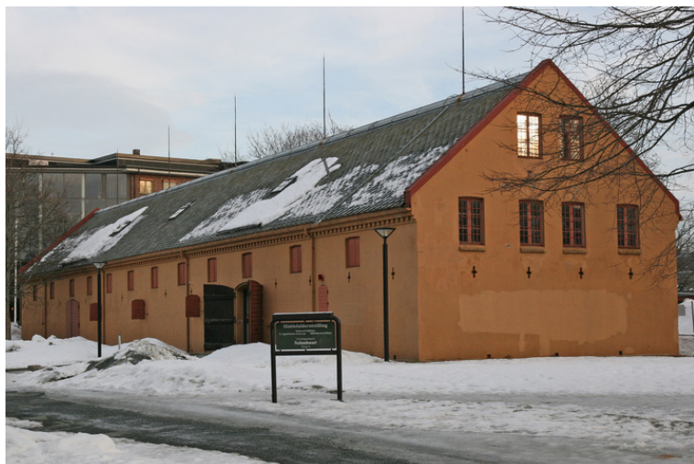
Suhmhuset, fasade mot nord med inngang samt gavlvegg mot vest. Opphavsrett: Statsbygg.
