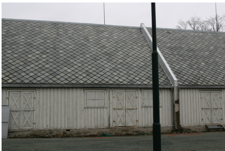
Utsnitt av langfasade mot vei. Opphavsrett: Statsbygg.
