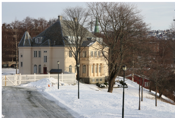
Bygningen sett fra adkomst. Opphavsrett: Statsbygg.
