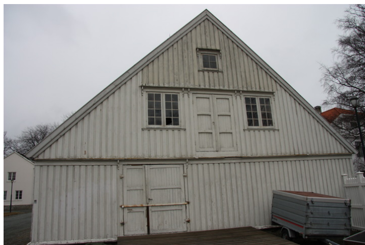
Gavl mot øst. Opphavsrett: Statsbygg.
