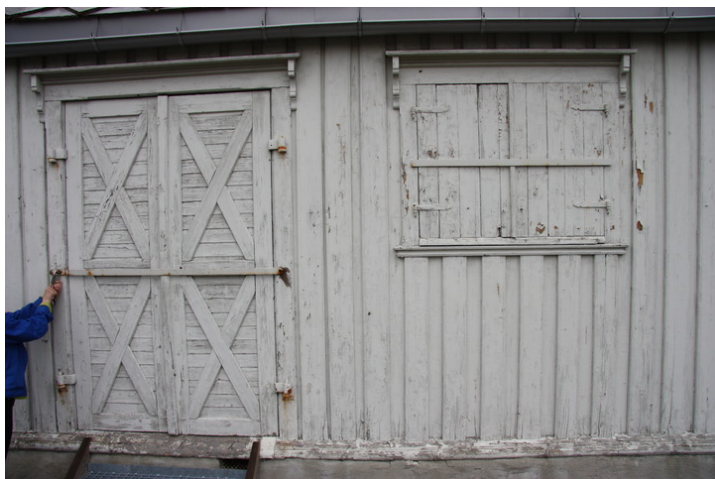
Detalj fasade, dør/vindu. Opphavsrett: Statsbygg.
