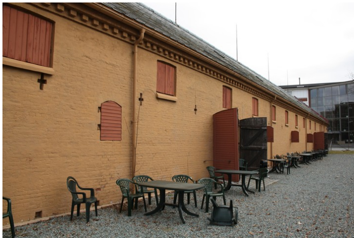
Fasade mot syd. Opphavsrett: Statsbygg.
