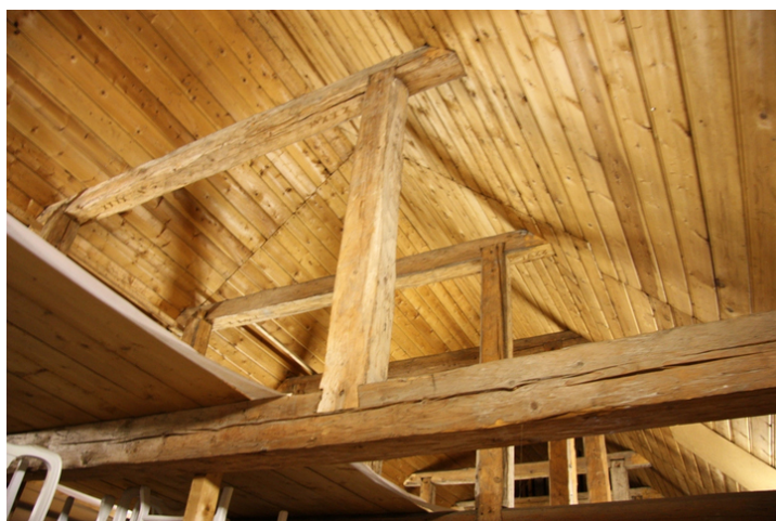
Takkonstruksjon. Opphavsrett: Statsbygg.
