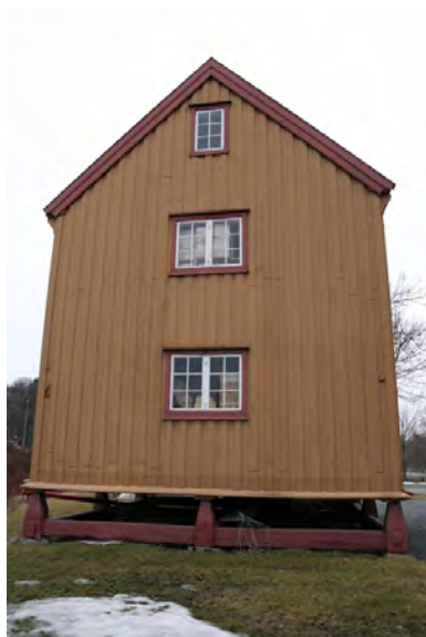
Stabburet. Fasade mot nord. Opphavsrett: Statsbygg.
