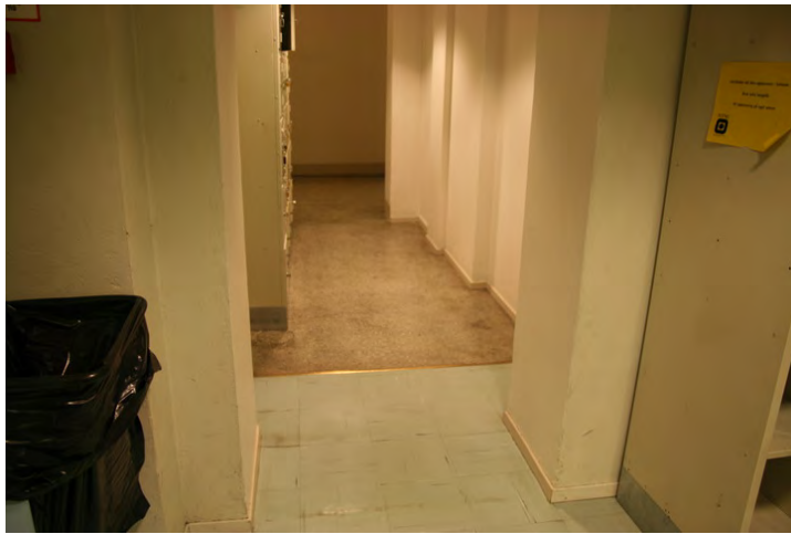
1. etasje. Skillet i gulvet markerer overgang mellom opprinnelig bygning og tilbygg. Opphavsrett: Statsbygg.
