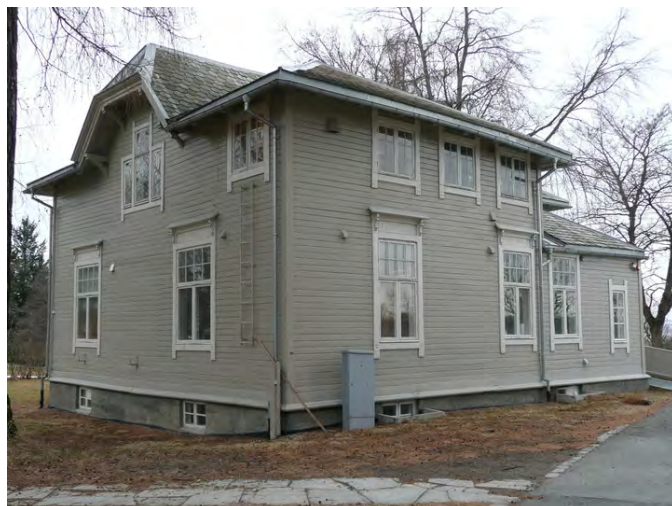
Fasader mot syd og øst. Opphavsrett: Statsbygg.
