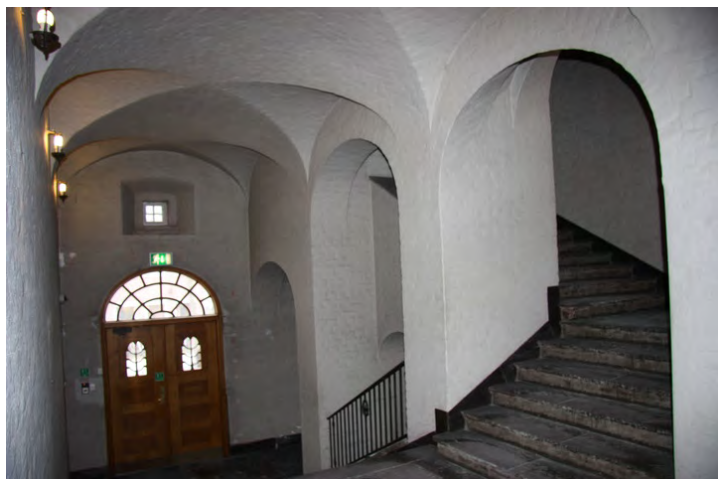
Inngangspartiet fra nordre gavlvegg. Hvitmalte teglvegger og sort skiferstein på gulv og i trapper. Opphavsrett: Statsbygg.
