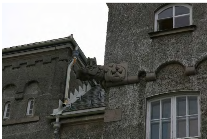
Detalj på hovedfasadens østre del. Opphavsrett: Statsbygg.
