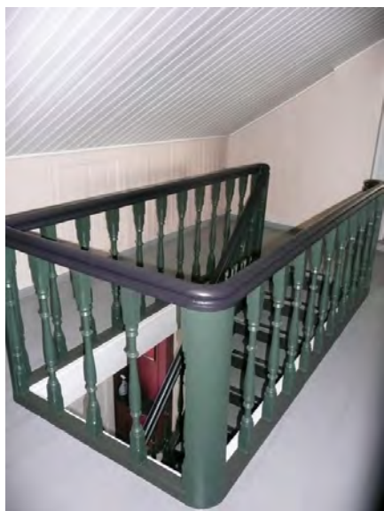
Trapp fra gangen opp til loftetasjen. Opphavsrett: Statsbygg.
