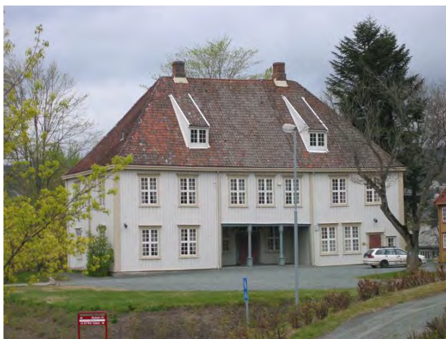
Lerkendal gård, hovedbygning Foto: Arne Rønning. Opphavsrett: NTNU.
