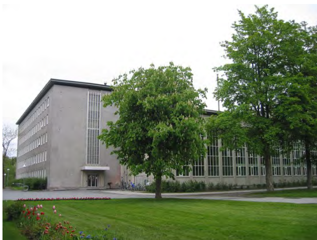
Varmeteknisk. Fasader mot nord og vest. Foto: Arne Rønning. Opphavsrett: NTNU.
