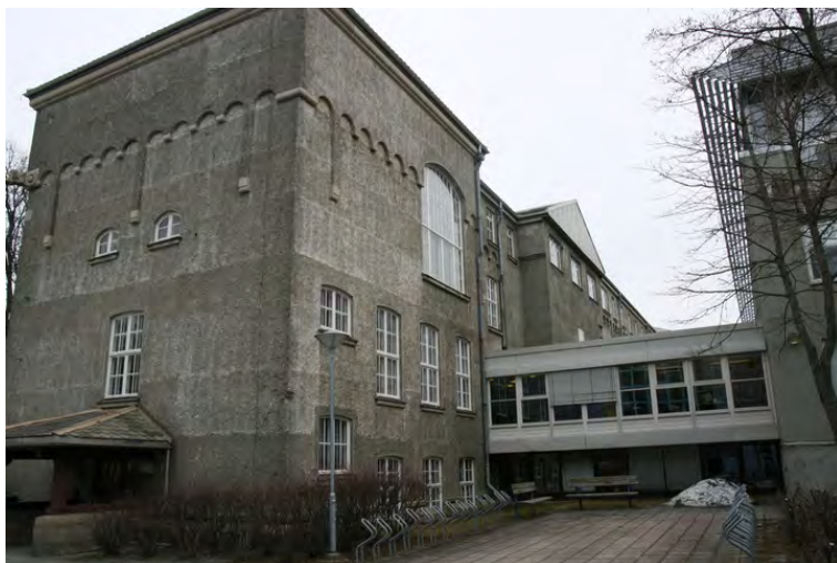
Fasade mot vest og syd. Tilkoblingen mot Senralbygg 2 er starten på "stripa". Opphavsrett: Statsbygg.
