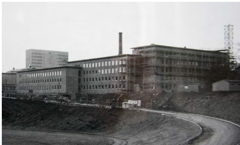
Bildet fra oppføringen av Varmeteknisk viser de opprinnelige høydene på fløyene mot Høgskoleringen. Bak ses Sentralbygg 1 som var ferdig i 1961.
