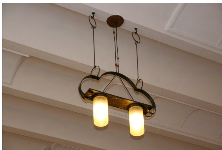
Original lysarmatur og murhimling både i 1. og 2. etasje. Opphavsrett: Statsbygg.
