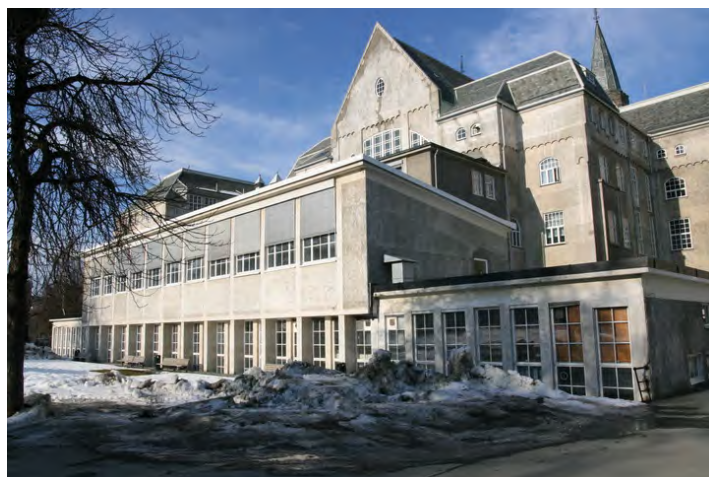
Midtfløyen. Biblioteket med kontorpåbygg, lesesal og sidefløyer. Opphavsrett: Statsbygg.
