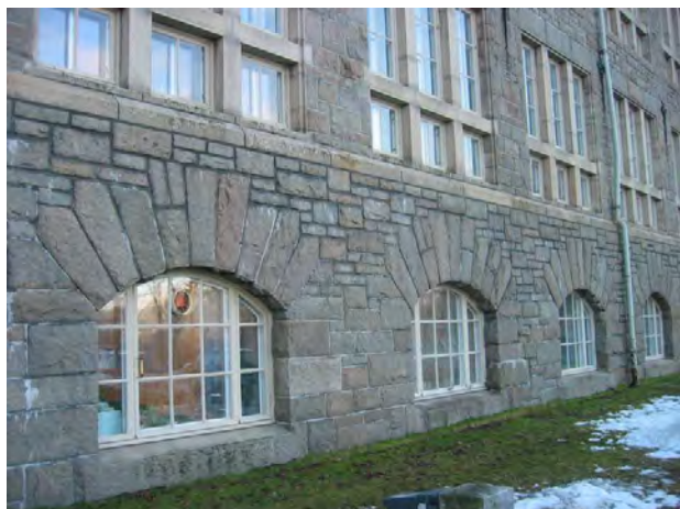
Detalj av fasaden som viser råkoppekonstruksjonen. Foto: Arne Rønning. Opphavsrett: NTNU.
