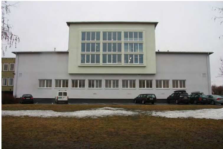
Underetasjen med vinduer inn til studenttanken. Den store modelltanken løper vinkelrett på denne i etasjen over. Opphavsrett: Statsbygg.
