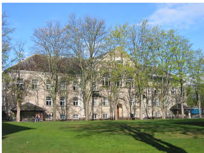
Gamle elektro ligger med fasade mot øst. Foto: Arne Rønning. Opphavsrett: NTNU.
