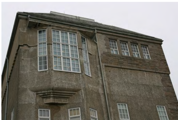
Østre sidefløy, auditoriet i 3.etasje sett fra utsiden. Opphavsrett: Statsbygg.
