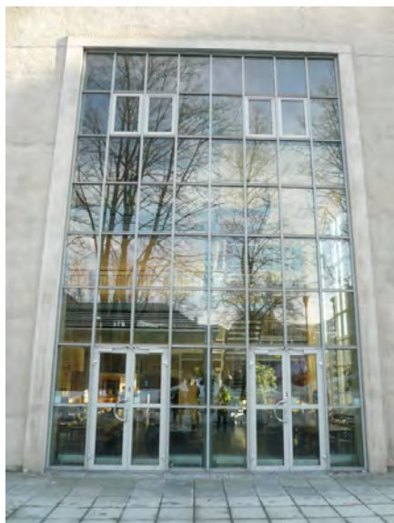
Del av kjelhusets fasade mot vest. Opphavsrett: Statsbygg.
