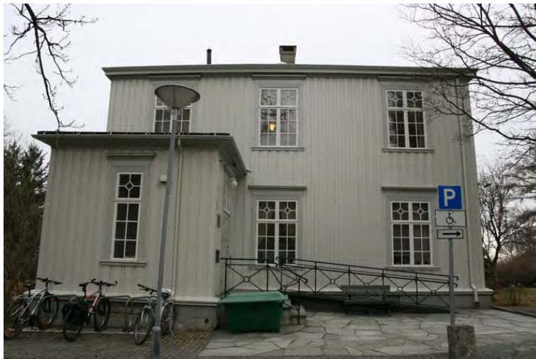
Dagens inngang ligger i et tilbygg på fasaden mot sør. Opphavsrett: Statsbygg.
