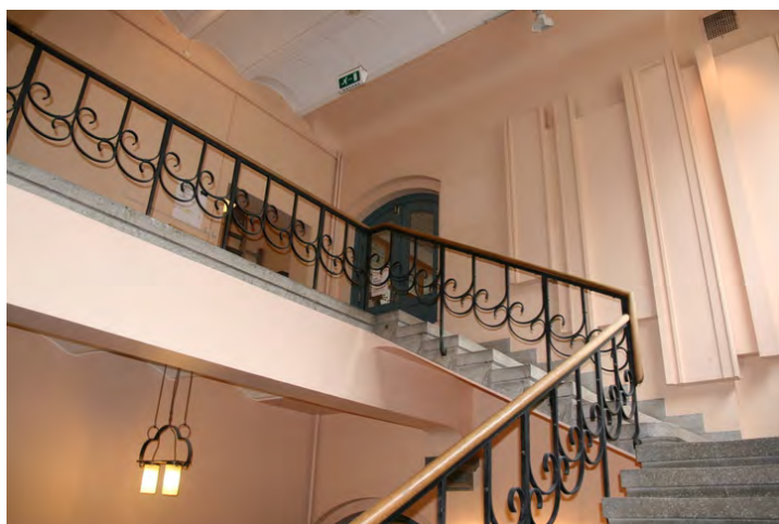
Trapperom opp til 2. etasje. Opphavsrett: Statsbygg.
