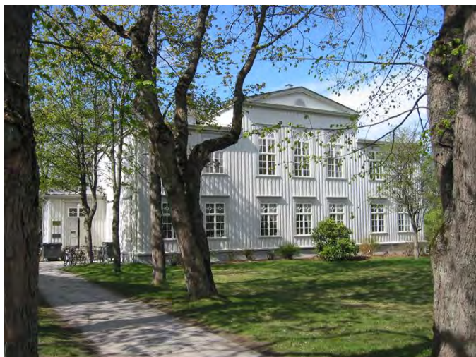
Vestre Gløshaugen. Foto: Arne Rønning. Opphavsrett: NTNU.
