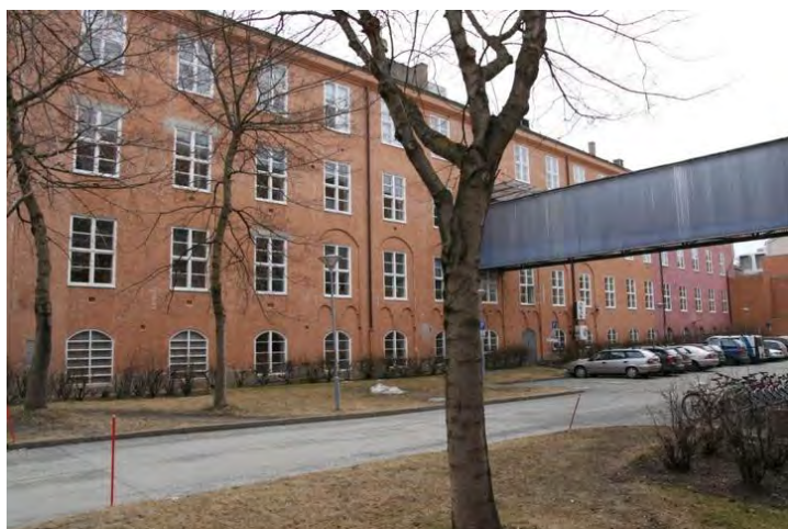
Fasade mot vest. Påbygg fra 1951 ses i annen farge til høyre i bildet. Opphavsrett: Statsbygg.
