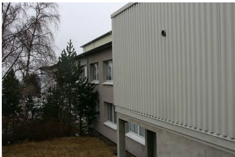
Del av langveggen mot syd. Opphavsrett: Statsbygg.
