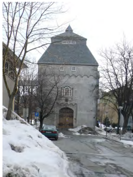
Fasade mot nord. Arkitekturen gir assosiasjoner til kraftstasjoner. Opphavsrett: Statsbygg.
