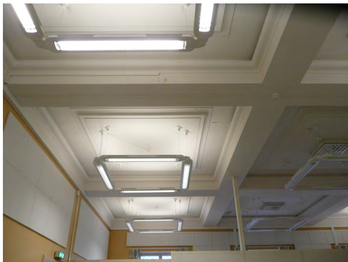
Opprinnelig tak i 3. etasje viser at det opprinnelige auditoriet gikk over hele bygningens bredde. Opphavsrett: Statsbygg.
