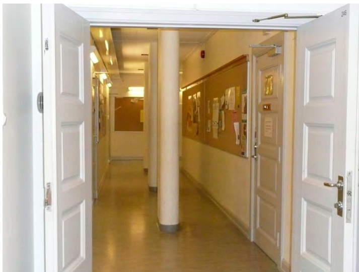
Ekstra søyler i 2. etasje støtter opp om nytt gulv der det tidligere var auditorium over to etasjer. Opphavsrett: Statsbygg.
