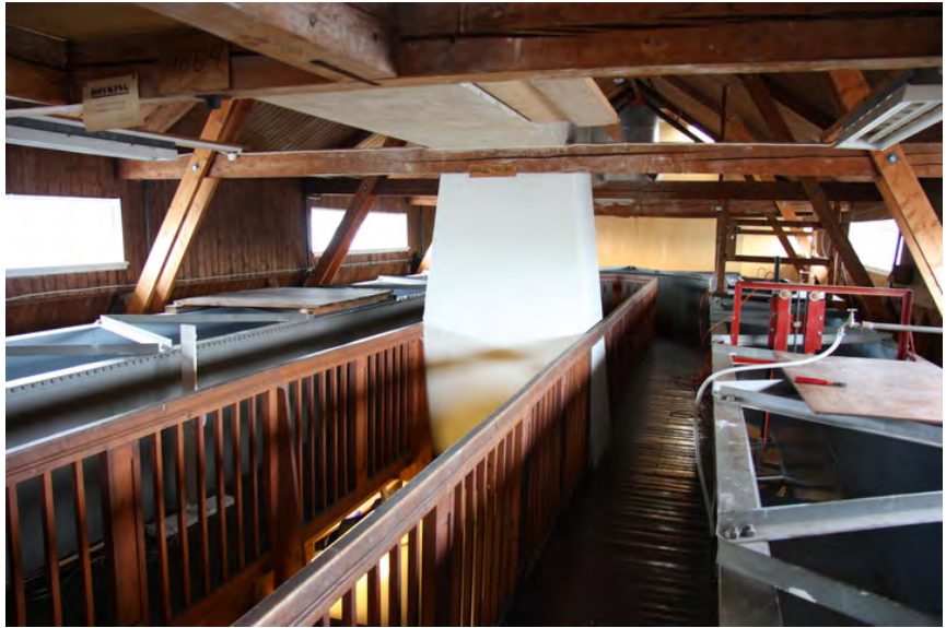
Vannrenner på loftet. Opphavsrett: Statsbygg.
