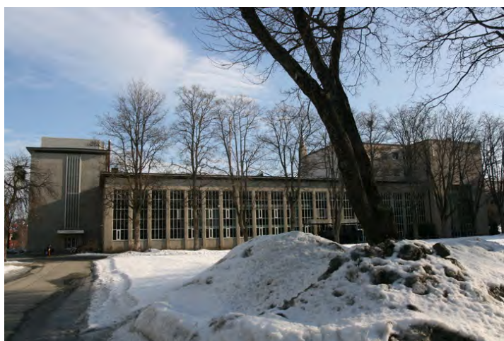
Varmeteknisk. Fasade mot vest. Opphavsrett: Statsbygg.
