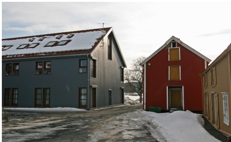
Adkomsten til tunet med nyoppbygget låve t.v. Opphavsrett: Statsbygg.
