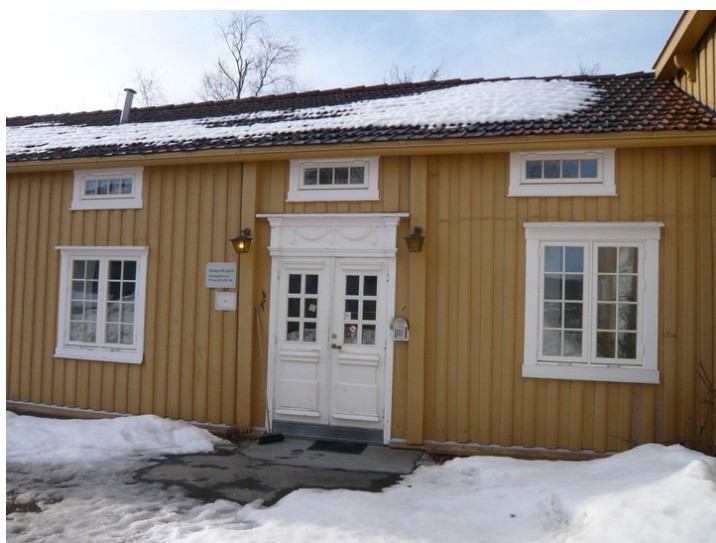
Inngang sidefløy. Opphavsrett: Statsbygg.
