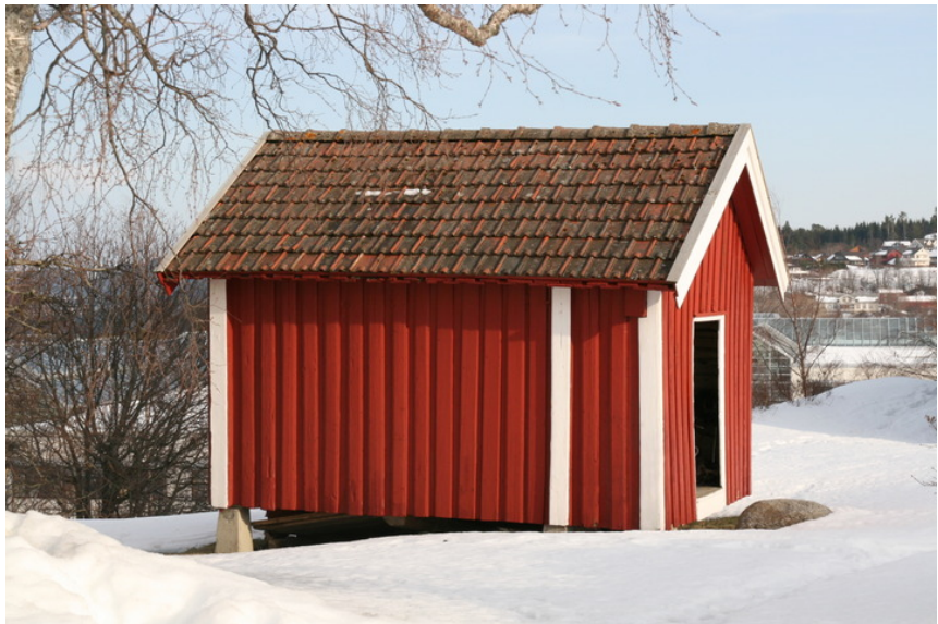
Lite stabbur (GAB-nr 182322725), ligger i tunet, nær våningshuset. Opphavsrett: Stabbur
