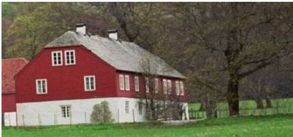
Avlsgården hovedbygning. Opphavsrett: Hordaland fylkeskommune.
