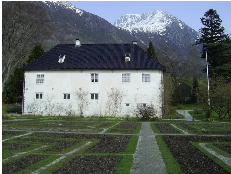
Slottet. Foto: Lena Eikeland Kutschera. Opphavsrett: Hordaland fylkeskommune.
