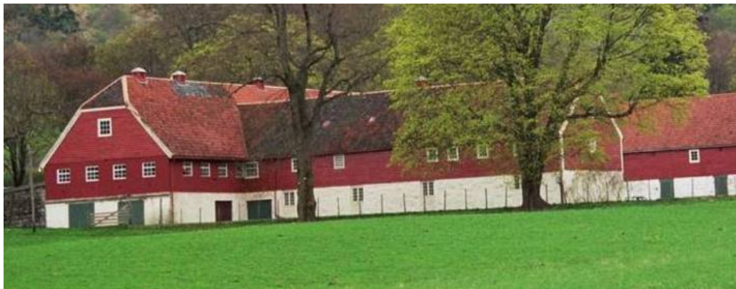
Avlsgård driftsbygningen. Opphavsrett: Hordaland fylkeskommune.
