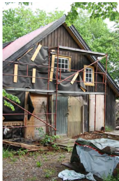
På fasaden mot øst er omfattende arbeider i gang (2010). Opphavsrett: Statsbygg.
