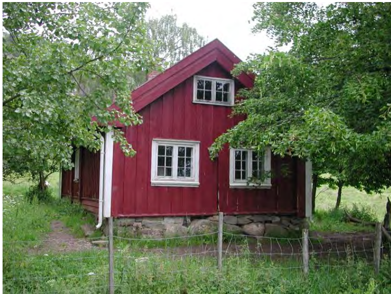
Tangen, vestgavl. Foto: Bjørn Anders Fredriksen. Opphavsrett: UMB.
