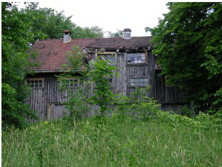
Sauefjøset før istandsetting. Foto: Bjørn Anders Fredriksen
