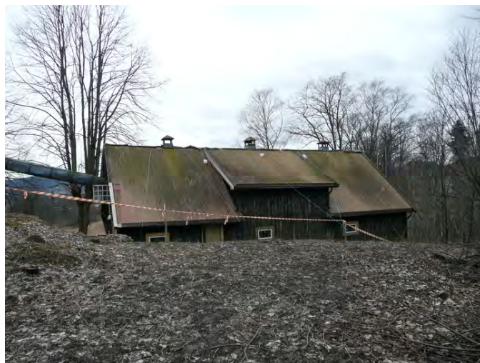
På fasdaen mot øst gjenstår rehabilitering (2010). Opphavsrett: Statsbygg.
