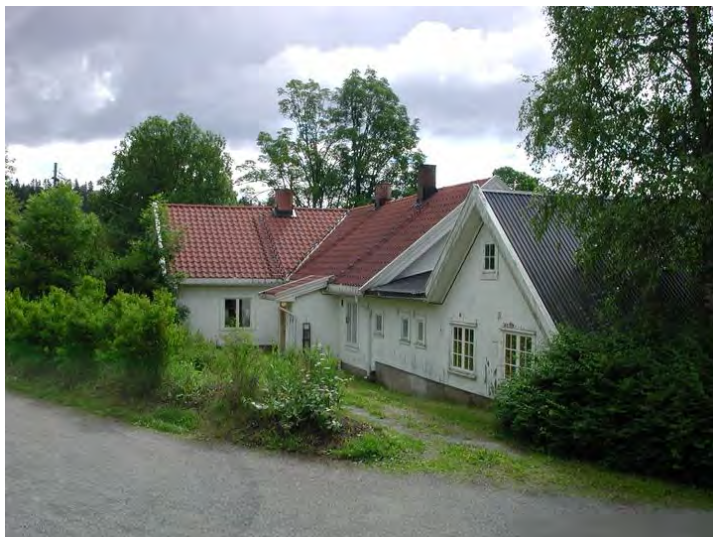
Røktboligen, nordfasade. Foto: Bjørn Anders Fredriksen. Opphavsrett: UMB.
