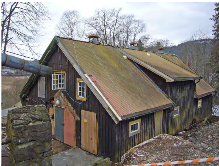
Sauefjøsset, fasader mot øst og nord. Opphavsrett: Statsbygg.
