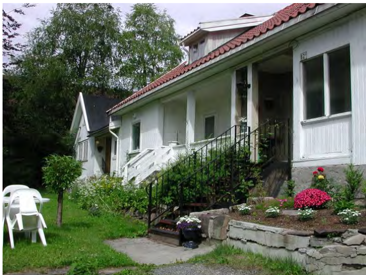
Røktboligen, sydfasade. Foto: Bjørn Anders Fredriksen. Opphavsrett: UMB.
