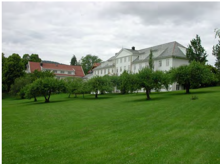
Gjestegården sett fra sørøst. Foto: Bjørn Anders Fredriksen. Opphavsrett: UMB:
