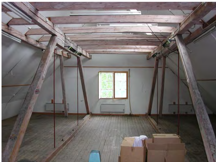
Vevstua, loft. Bildet viser hvordan dekket over 1. etasje er hengt opp i takkonstruksjonen med stålstag. Foto: Bjørn Anders Fredriksen. Opphavsrett: UMB.
