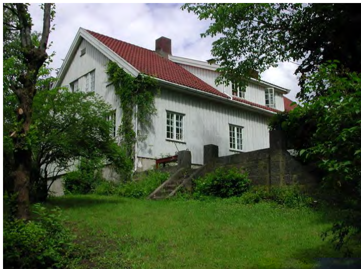
Bestyrerboligen med terrasseanlegg mot sydøst.. Foto: Bjørn Anders Fredriksen. Opphavsrett: UMB.
