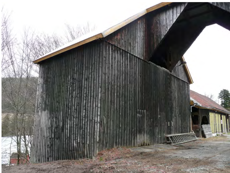
Korntørka. Fasader mot vest og sør. Opphavsrett: Statsbygg.
