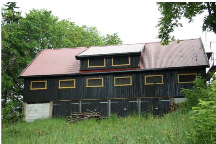
Fasade mot sør er pusset opp. Opphavsrett: Statsbygg.
