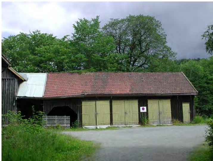
Redskapshuset, sett fra syd. Foto: Bjørn Anders Fredriksen. Opphavsrett: UMB.
