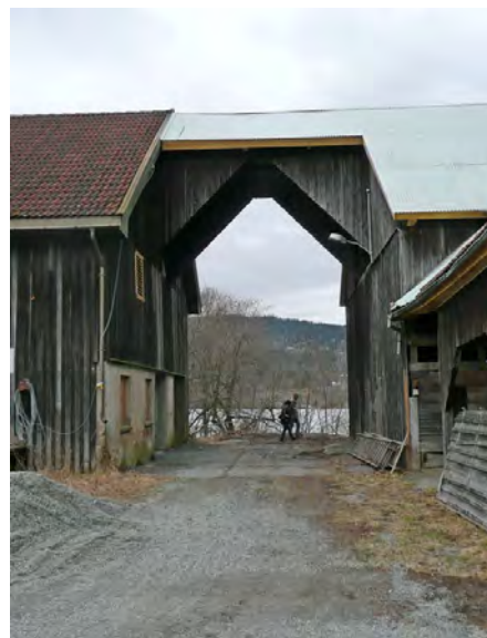
Korntørka (til høyre) er bygget sammen med låven. Opphavsrett: Statsbygg.
