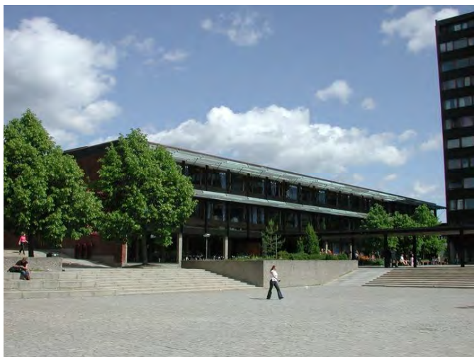
Vilhelm Bjerknes hus, fasade mot sør. Opphavsrett: UiO.
