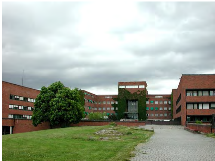
Kjemibygningen sett fra sør, på hver side av Fysikkbygningen. Opphavsrett: UiO.
