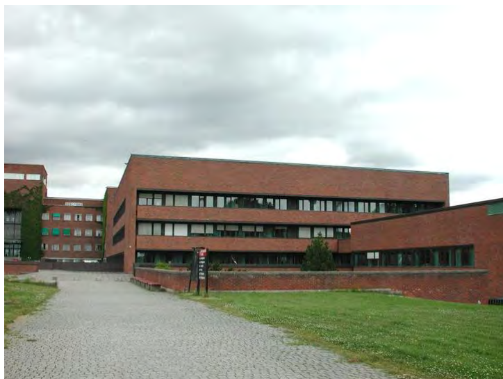
Østre kjemibygning, fasade mot sør. Opphavsrett: UiO.
