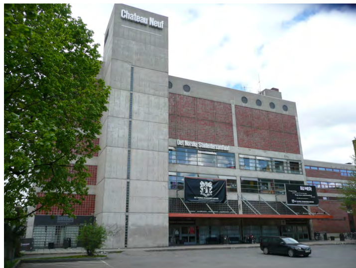
Inngangssiden. Opphavsrett: Statsbygg.
