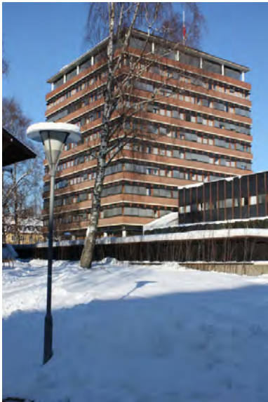
Fasade sydøst og sydvest. Opphavsrett: UiO.
