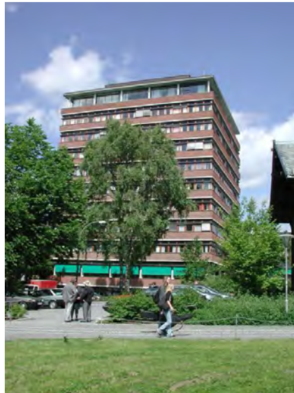
Administrasjonsbygningens sydfasade. Opphavsrett: UiO.
