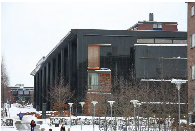
Georg Sverdrups hus - universitetsbiblioteket. Opphavsrett: Statsbygg.
