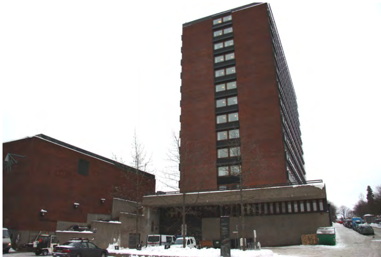
Fasade mot sørvest. Opphavsrett: Statsbygg.
