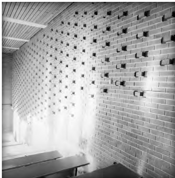
Detalj av vestveggen i auditorium 1. Opphavsrett: UiO.
