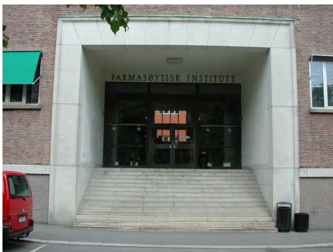
Inngangsparti. Opphavsrett: UiO.
