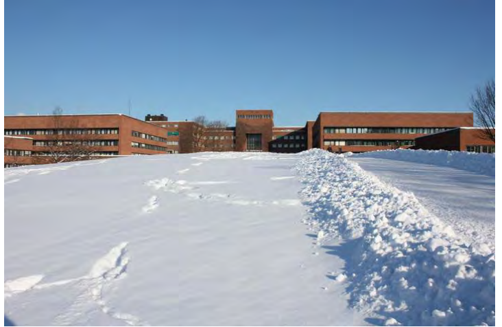
Fasader mot sør, Kjemibygningens fløyer på sidene, og den eldre fysikkbygningen ses i midten. Opphavsrett: UiO.
