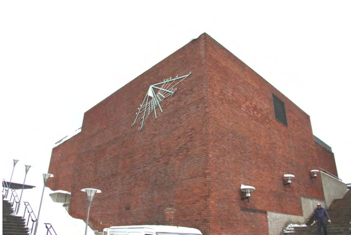
Sophus Lies auditorium. Opphavsrett: Statsbygg.
