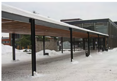
Typisk overdekning mellom bygninger på øvre Blindern. Opphavsrett: Statsbygg.
