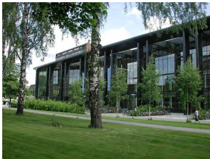
Vestfasade sett fra sørvest. Niels Henrik Abels hus skimtes i bakgrunnen. Opphavsrett: UiO.
