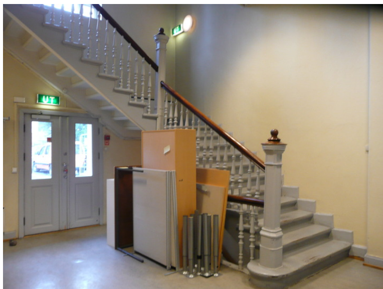
Trappeløpet sett fra 1. etasje. Rom nr. 101. Opphavsrett: UiO.
