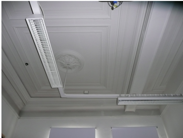
Forseggjort takflate er spor fra det opprinnelige auditoriet i 3. etasje. Opphavsrett: Statsbygg.
