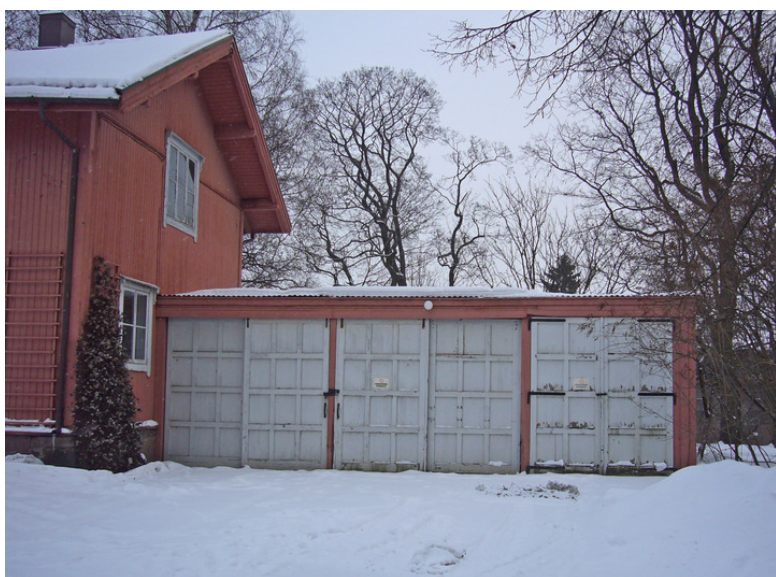
Østfløyens sørgavl. Garasjene som ble oppført ca. 1953 omfattes ikke av fredningen. Opphavsrett: Statsbygg.
