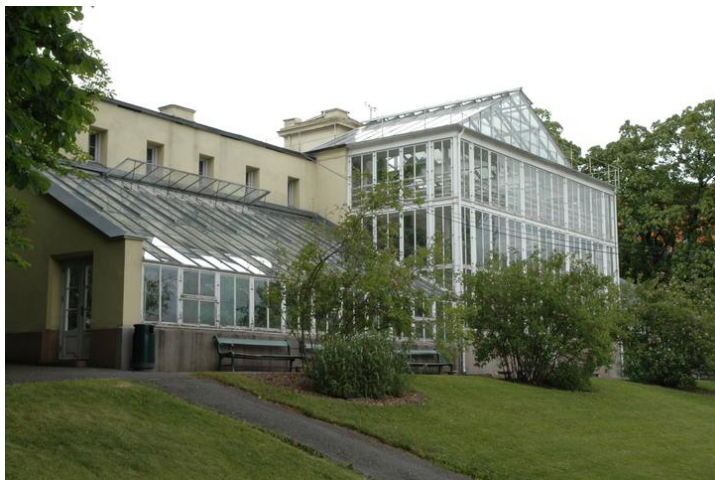
Palmehuset sett fra sørvest. Foto: Raul Da Cunha. Opphavsrett: UiO.
