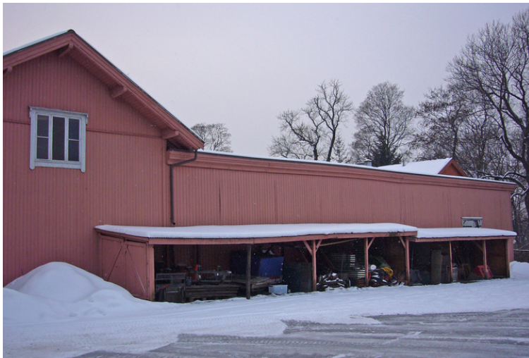
Midtfløyens nordside, med senere tilbygd skur. Opphavsrett: Statsbygg.
