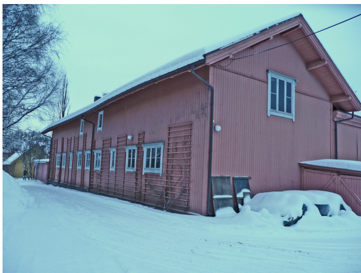
Driftsbygningens østfløy oppført ca 1891-1895. Opphavsrett: Statsbygg.
