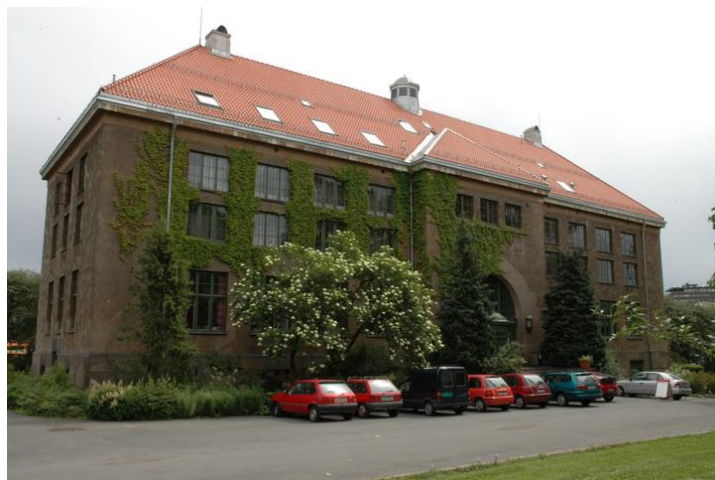
Hovedfasade mot vest. Foto: Raul Da Cunha. Opphavsrett: UiO.
