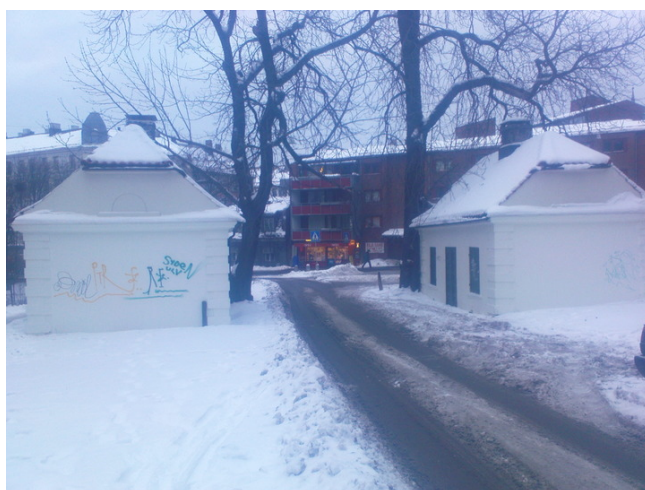
Fasader mot øst. Opphavsrett: Statsbygg.
