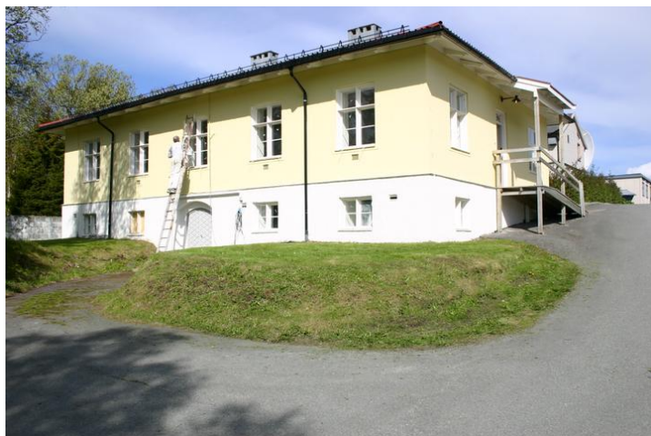
Obs.hus sett fra syd/øst. Opphavsrett: UiT.
