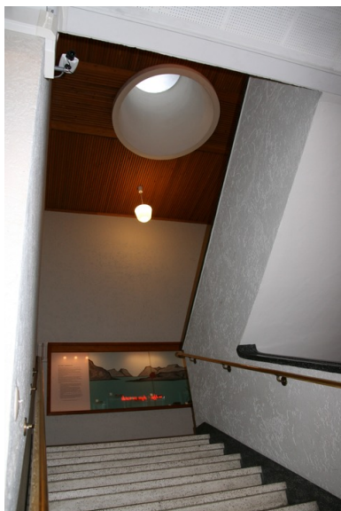
Hovedtrapp med monter i repos og overlys. Opphavsrett: Statsbygg.
