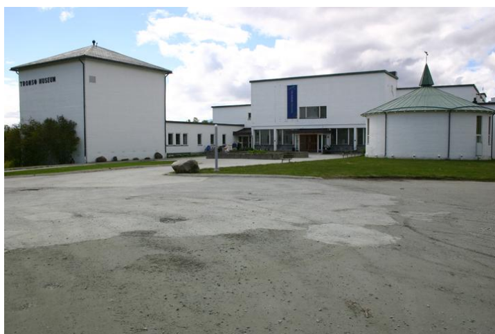
Hovedfasade med bibliotekfløy/magasintårn, hovedinngang og kantine (rotunde). Opphavsrett: UiT.
