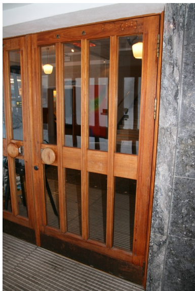
Indre dører til hovedinngangen (vindfang). Opphavsrett: Statsbygg.
