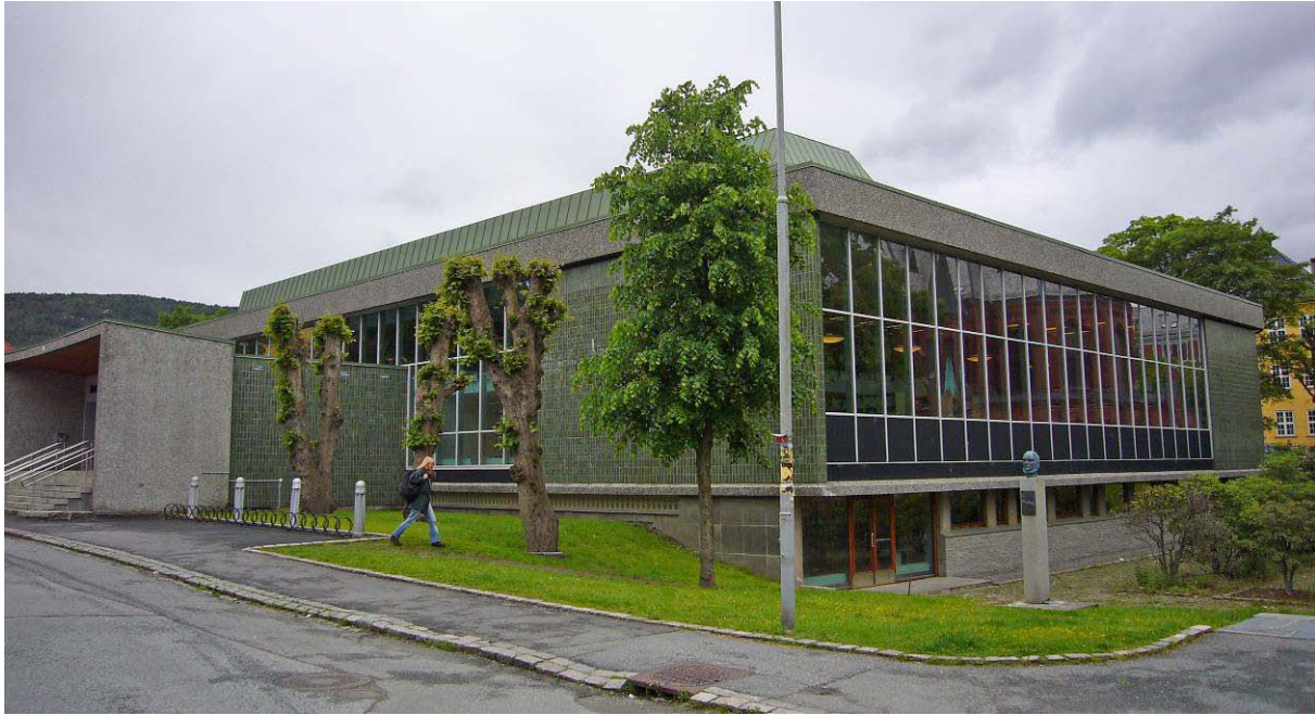
Universitetsbiblioteket i Bergen fra 1961, bygget etter Peter Helland-Hansen og Sverre Lieds tegninger. Foto: Statsbygg.
