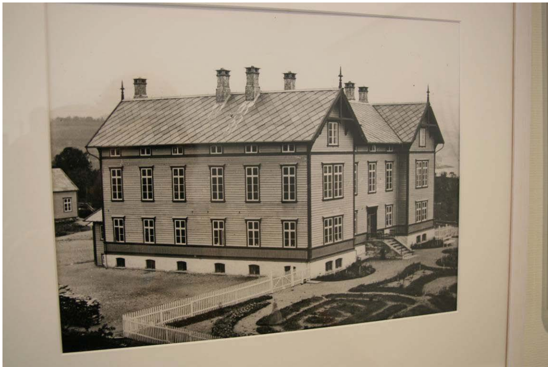
Stord seminarium. Den nye seminarbygningen fra 1866. Her ser vi også litt av den flotte seminarhagen som ble anlagt i 1870-årene. Foto: Statsbygg. © Høgskolen Stord.
