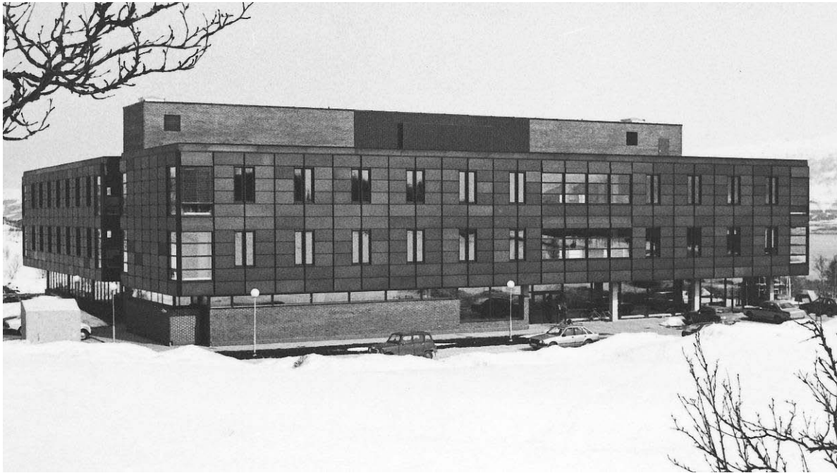
Hovedbiblioteket fra 1980 var den andre permanente bygningen (etter Realfagsbygget) som sto ferdig for UiT på universitetsområdet i Breivika. Foto: Statsbyggs arkiv.
