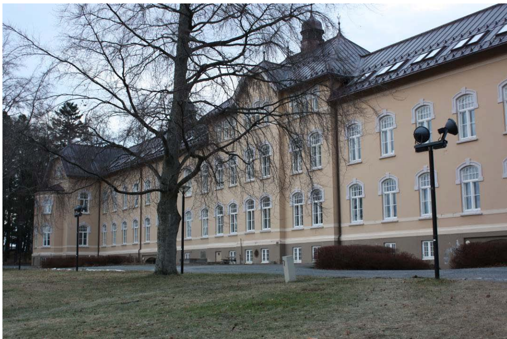
Røstad offentlige aandssvageskole. Hovedbygningen, tegnet av arkitekt Lars Solberg, Trondheim, sto klar til skolen åpnet i 1903 med 34 elever, to lærer og en bestyrer. Typisk for tiden var dette en stor monumental skole- og internatbygning som rommet de fleste funksjoner. Foto: Statsbygg.
