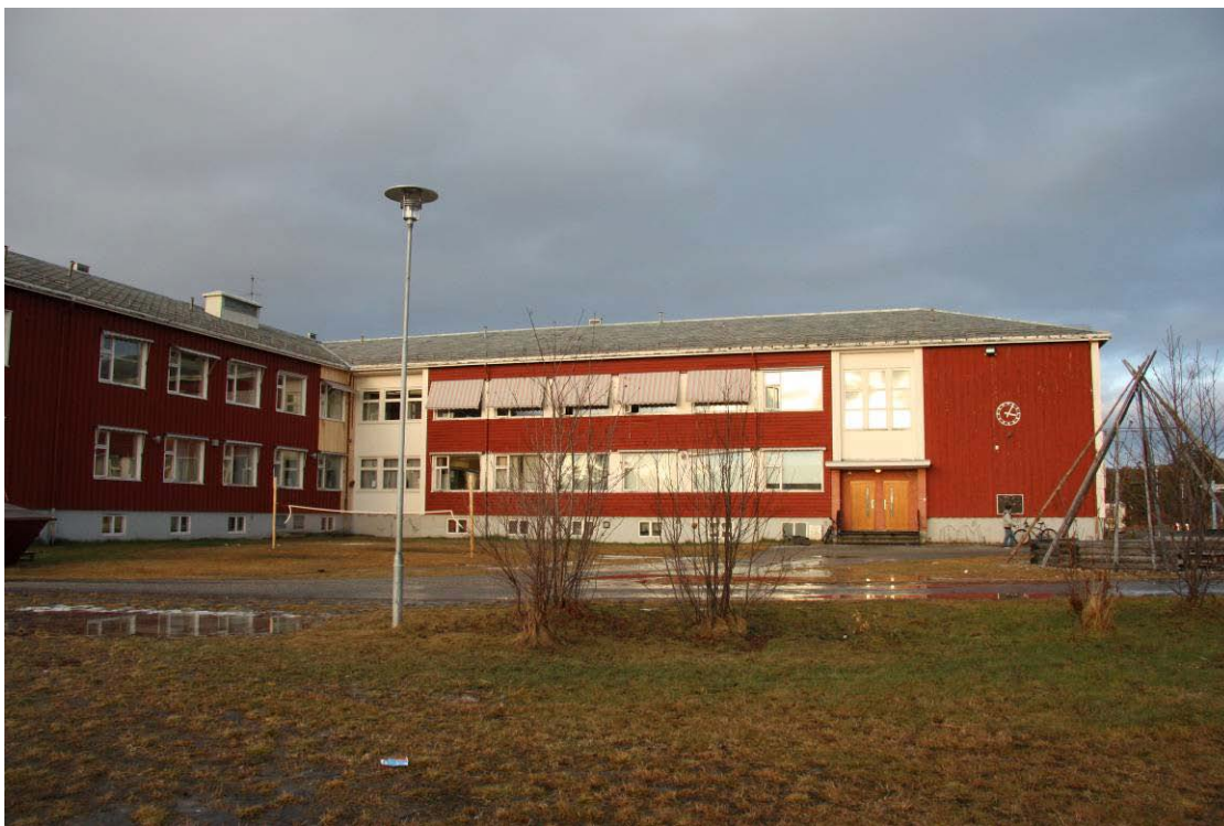
Statsinternatet i Karasjok ble gjenoppbygd allerede i 1951 etter at så godt som hele Finnmark brant i 1944. Bildet viser neste byggetrinn fra 1960, opprinnelig planlagt som eget framhaldsskolesbygg, men tatt i bruk som ungdomsskole.
