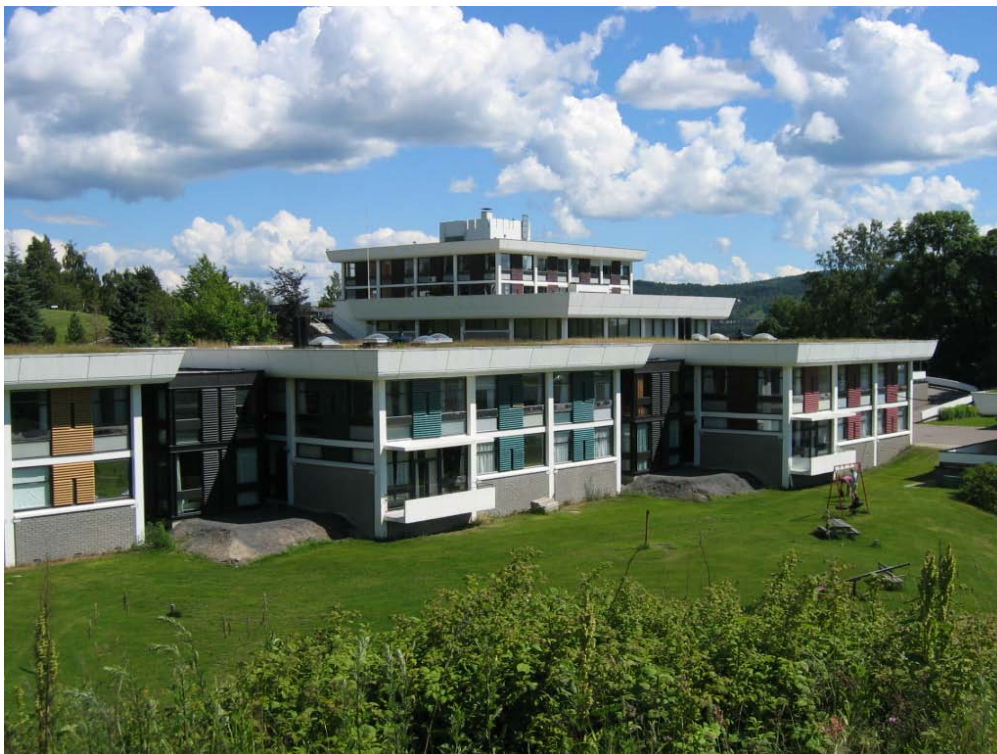
Bredtvet kompetansesenter i Oslo ble bygget som spesialskole for talehemmede. Skolen sto ferdig i 1966, etter tegninger av arkitekt P. A. M. Mellbye. Anlegget skiller seg fra tidligere spesialskoleutbygginger ved at funksjonene er fordelt i flere mindre bygninger for skape et mer "hjemlig" preg. Bildet viser felles skole- og administrasjonsbygg i bakgrunnen, og mindre, separate internater med ulike fargekoder i forgrunnen.
