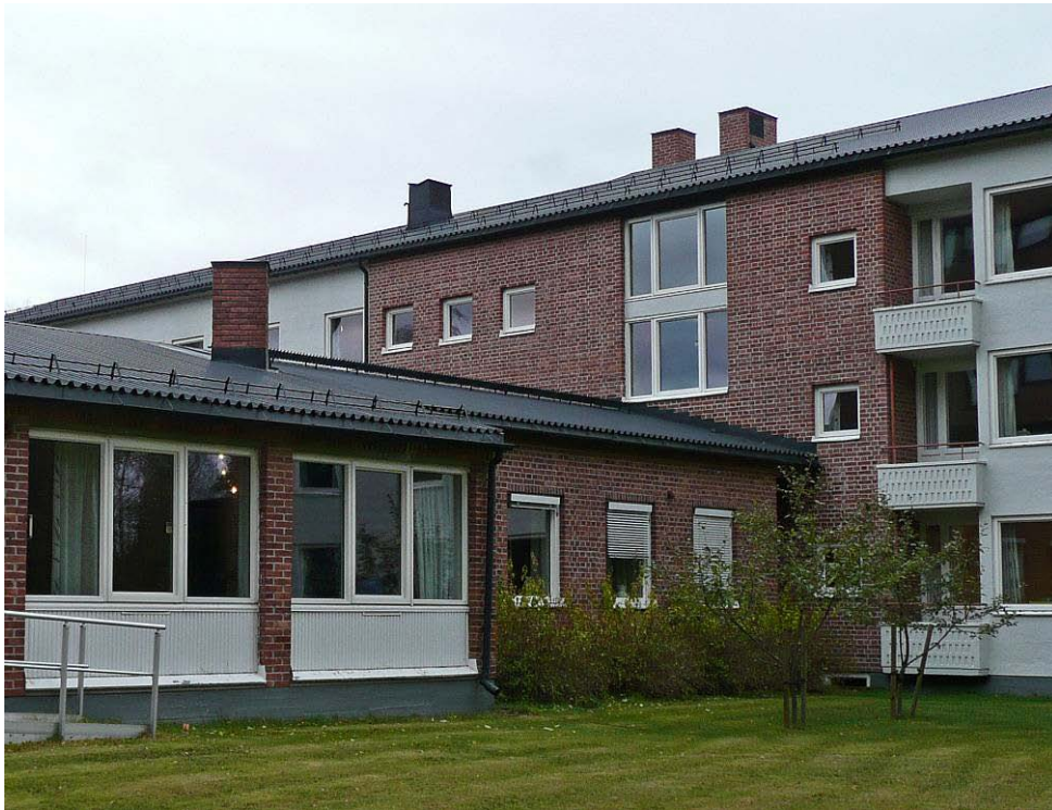
Sykepleierskolen på Elverum. Det karakteristiske 50-tallsuttrykket er godt bevart – både i eksteriøret og interiøret. Foto: Statsbygg.
