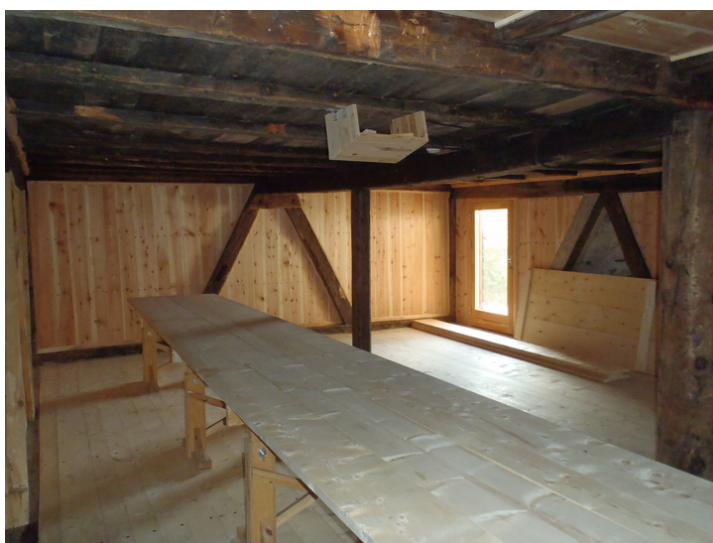
Ny innvendig panel Foto: M. Oftedal, Forsvarsbygg
