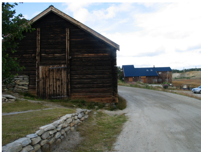
Tørkhuset mot Sørvest
