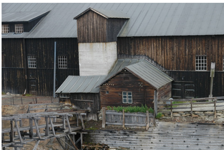
Øvre maskinhus til høyre med saltak Foto: Jon Holm Lillegjelten
