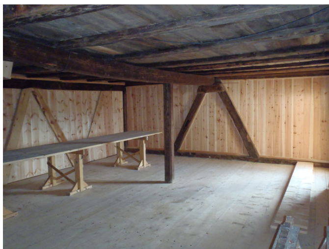
Ny innvendig panel 2011 Foto: M. Oftedal, Forsvarsbygg
