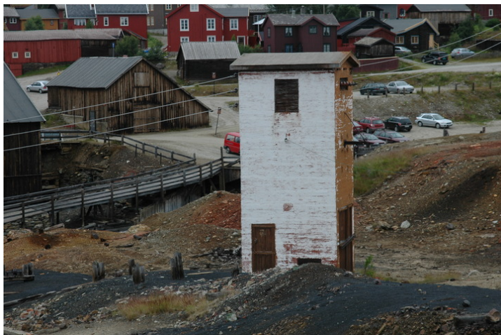
Trafokiosk på Kølplanken Foto: Jon Holm Lillegjelten
