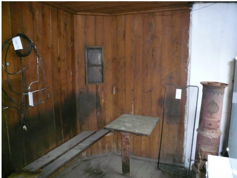
Kontor/oppholdsrom med mekanisme for regulering av spelet på turbinene. Foto: Skjetne, Andreas Skogholt
