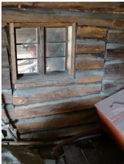
Vindu i vegg hovedhus mot tilbygg. Opprinnelig var det en døråpning her. Foto: Arnfinn Ryen Opphavsrett: Rørosmuseet
