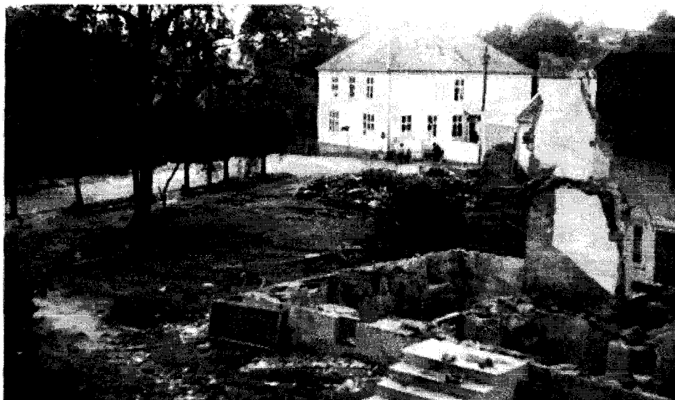
Bildet er tatt fra Østregate over hagen til Storgata 10, Lillesand Sparebank. Vi ser byggene som ble revet i forgrunnen og Middelskolen i bakgrunnen.
