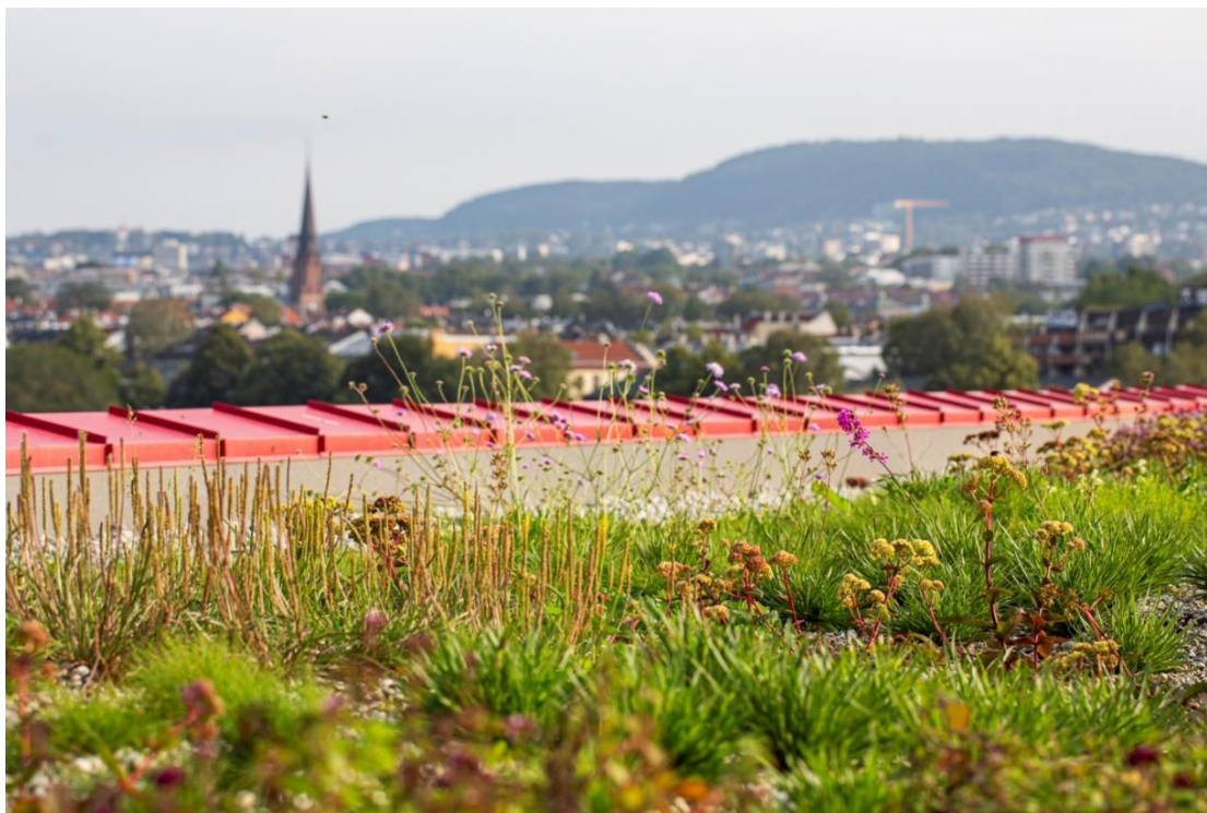
Figur 3 Taket på Vega Scene i Oslo har blitt et forskningsfelt for utvikling av unik Oslonatur i tett by.
