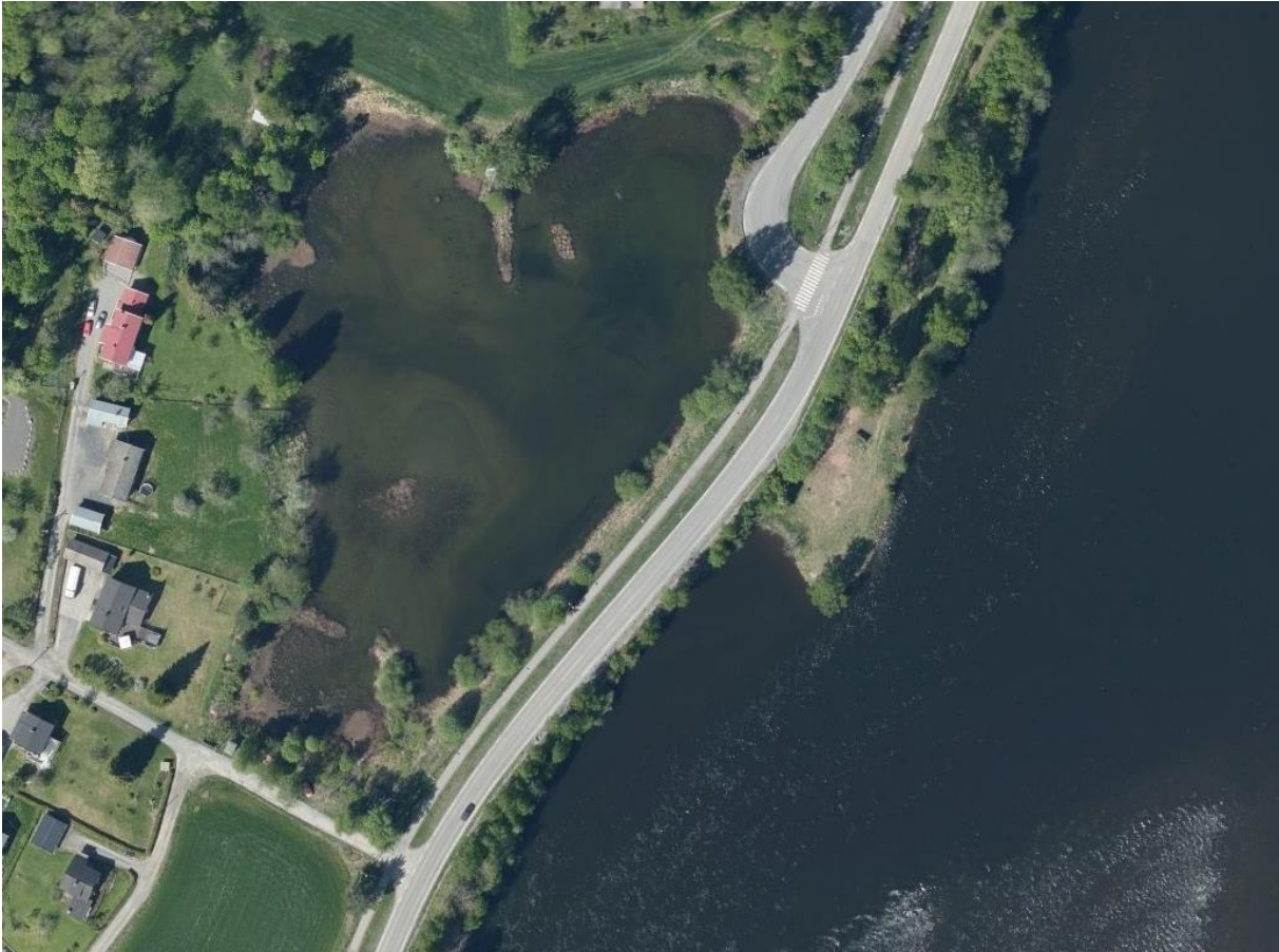
Figur 13. Rundtomevja er allerede i dag et svært viktig gyte- og oppvekstområde for en rekke fiskearter. Erstatning av dagens 50 cm rør inn i evja med noe større ville trolig gjort området ytterligere verdifullt.
