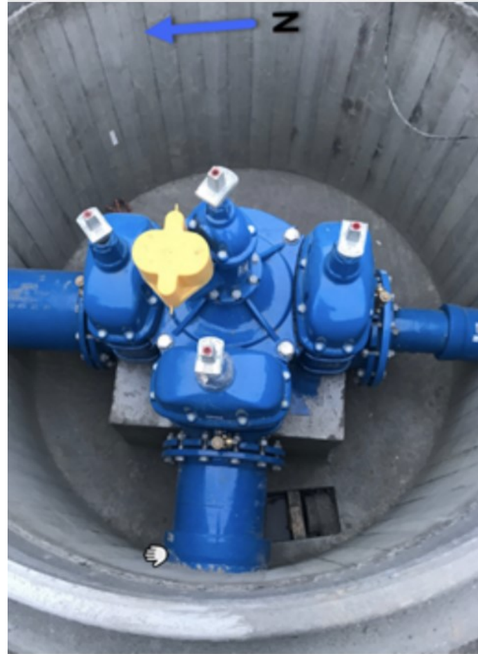
Kumbilder som viser innhold i kum før betongsøylen bygges.
