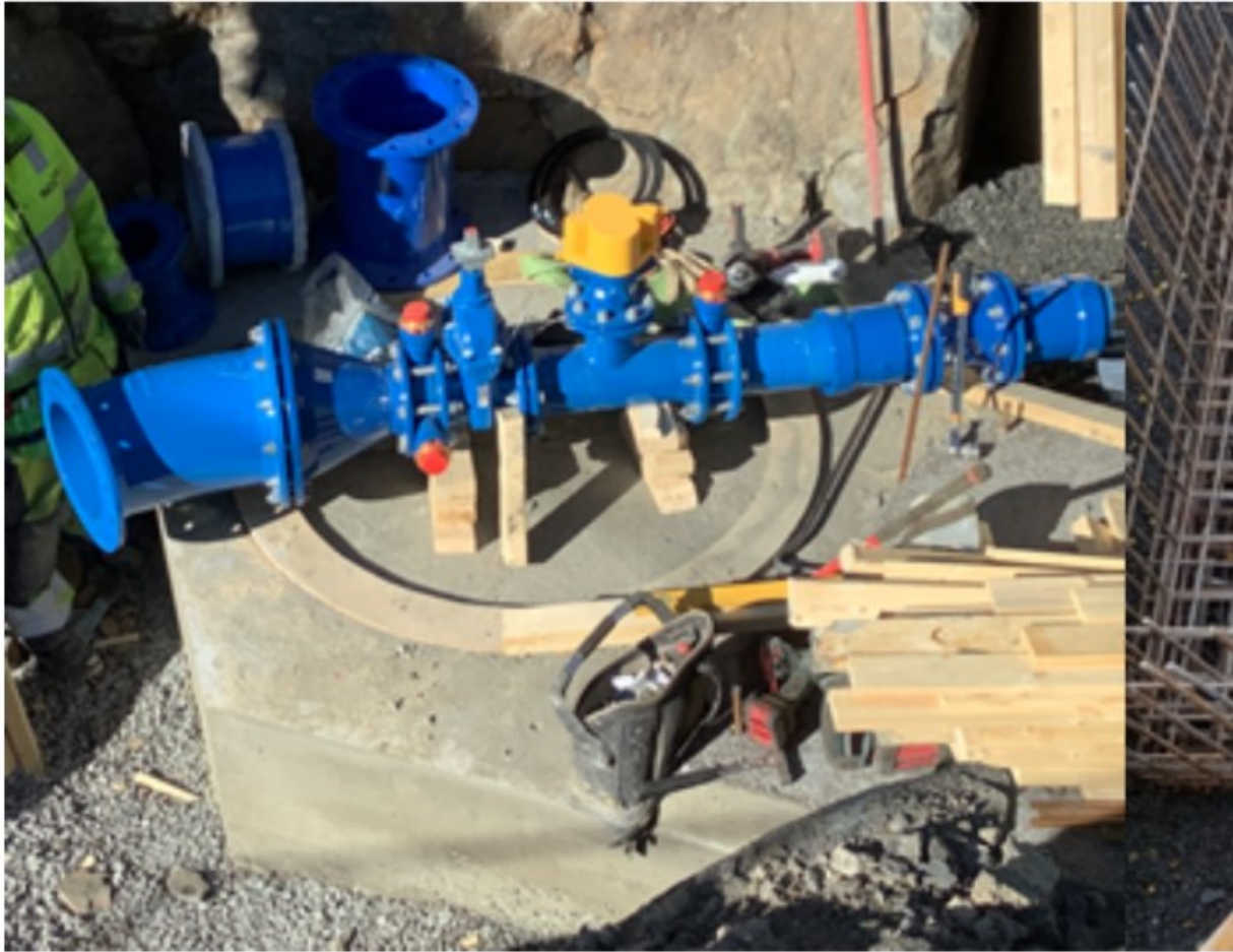
Kumbilder før støp av bunnseksjon.
