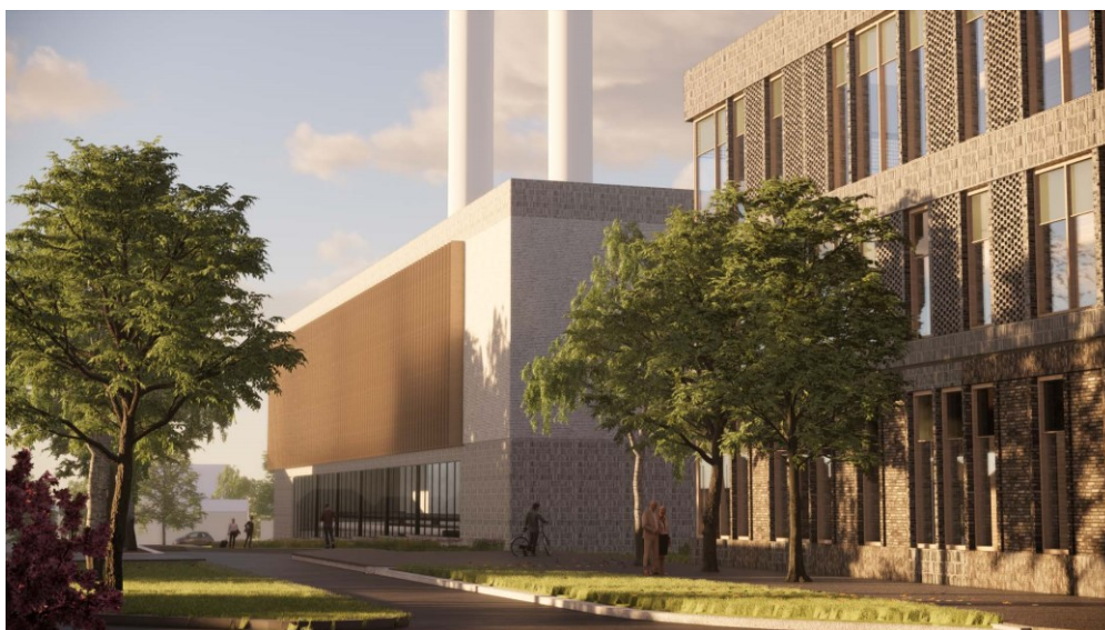
Figur 22 Teknisk sentral i tegl, glass og spiler (Team Aker, 2021)
