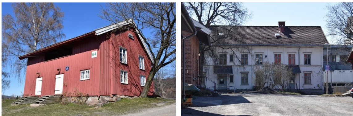
Figur 11 Tingstua fra 1755 til venstre, til høyre dagens våningshus på Tonsen. Foto: Kulturminneconsult 2019
