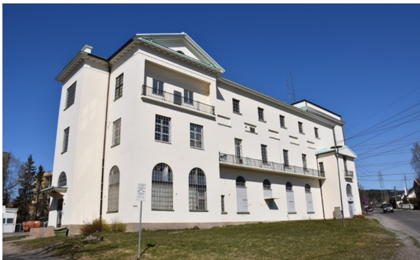
Figur 21 Transformatorstasjonen i dag. Foto: Kulturminneconsult 2019
