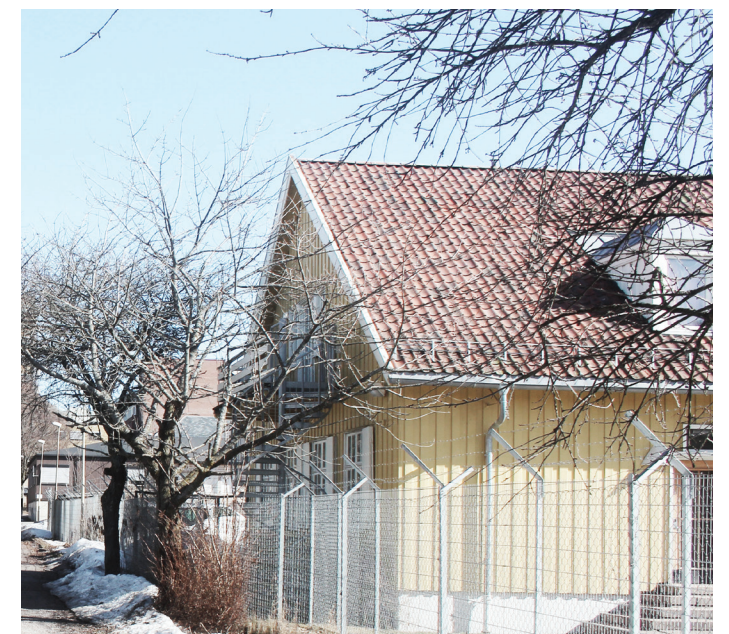
Foto av eksisterende bygninger, Refstad
