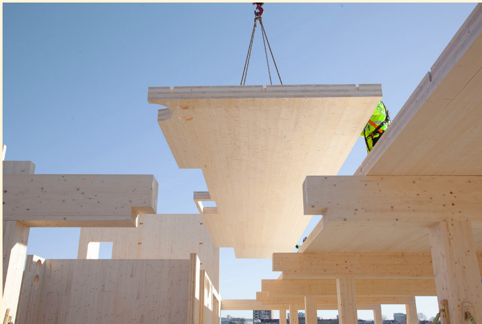
Bygging av «Redd Barna huset» med bruk av trekonstruksjon. Kilde: OsloTre (2022)
