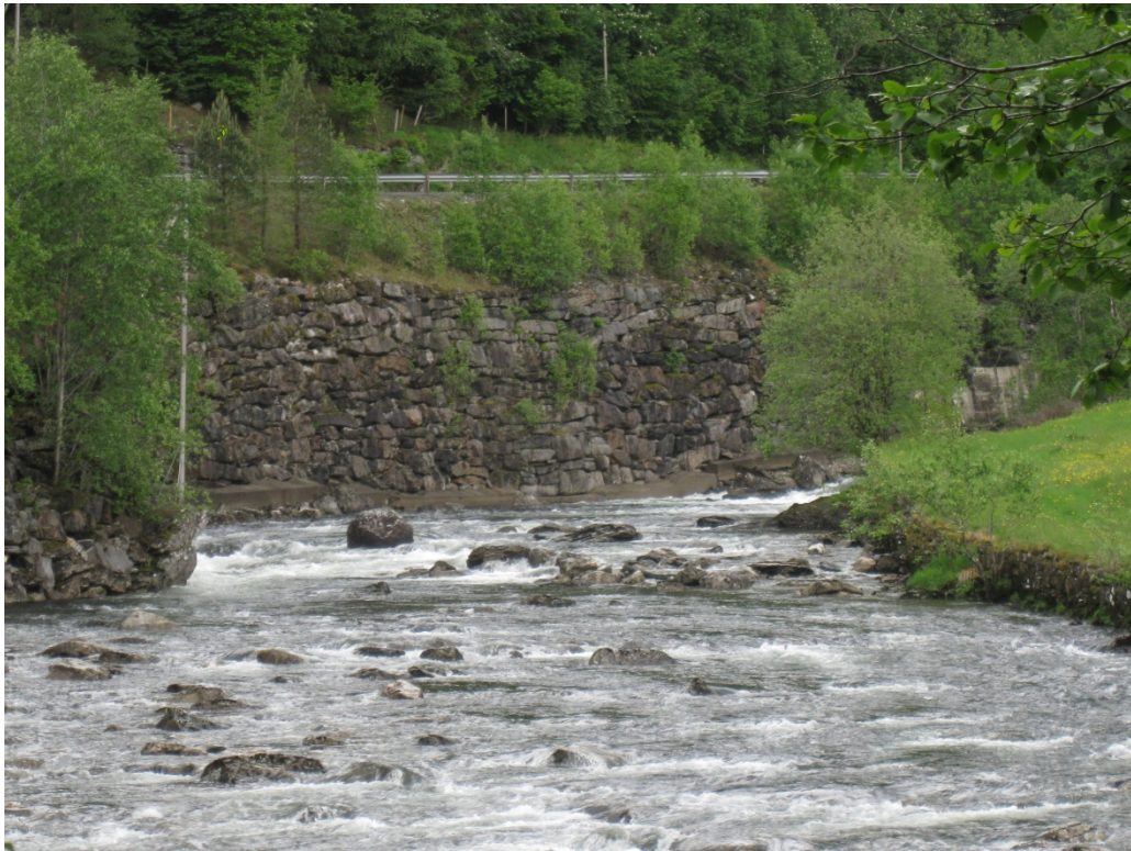
Bilete syner mur langs Rv.7 med fundamentering ut i Eikjedalselva/Frølandselva.
