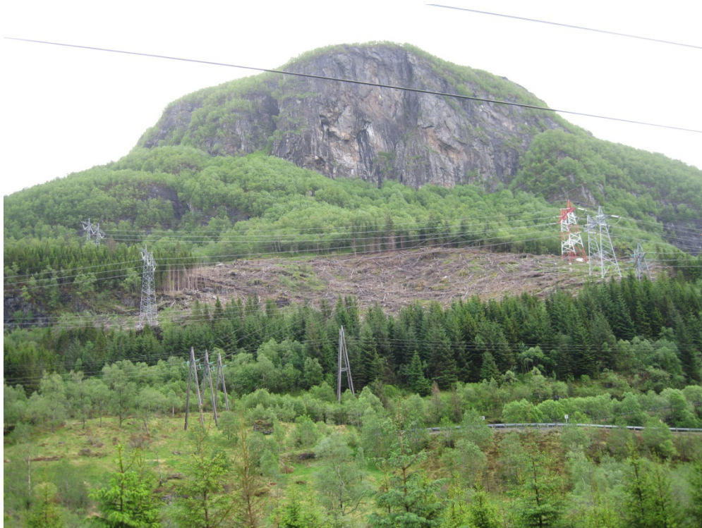
Bilete syner kraftlinjer innanfor 100 m beltet nær Børdalen trafostasjon.
