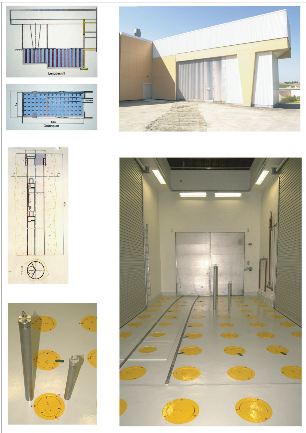
Figur 5.1 Brenselslageret i Met. Lab. II på Kjeller. Figuren viser også skjematiske illustrasjoner av størrørsbrønnene.
