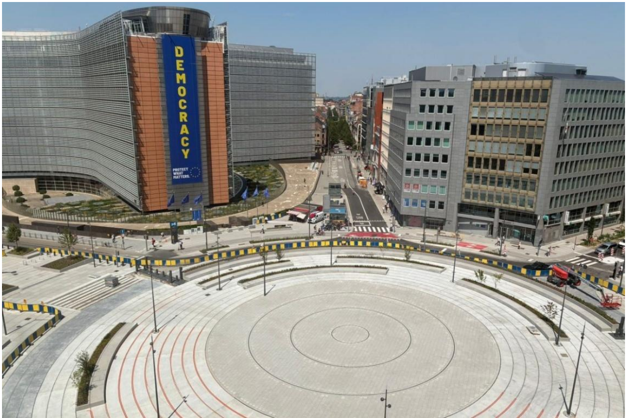
God sommer fra Brussel, der den nye rundkjøringen ved Schuman nærmer seg ferdigstillelse. Rundkjøringen har allerede fått kritikk for å være nok en betongflate i en by som fortsatt strever med å tilpasse seg et varmere og våtere klima. Foto: Eddy Wax/ Euractiv
