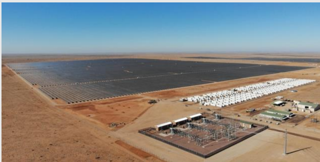
Figur 8-9 Scatecs prosjekt Kenhardt, 540 MW solkraft og 225 MW batteri i Sør-Afrika. Kilde: [25]
