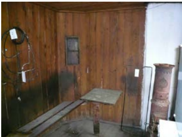
Kontor/oppholdsrom med mekanisme for regulering av spjelet på turbinene. Foto: Skjetne, Andreas Skogholt
