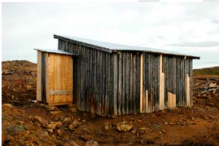
Heismaskinhus Storwartz Foto: Jon Holm Lillegjelten
