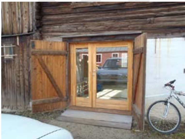
Ny dør til bygningsvernbutikk Foto: M.Oftedal, Forsvarsbygg
