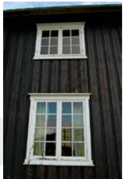
Vinduer, fasade SV. Foto: M. Oftedal, Forsvarsbygg.
