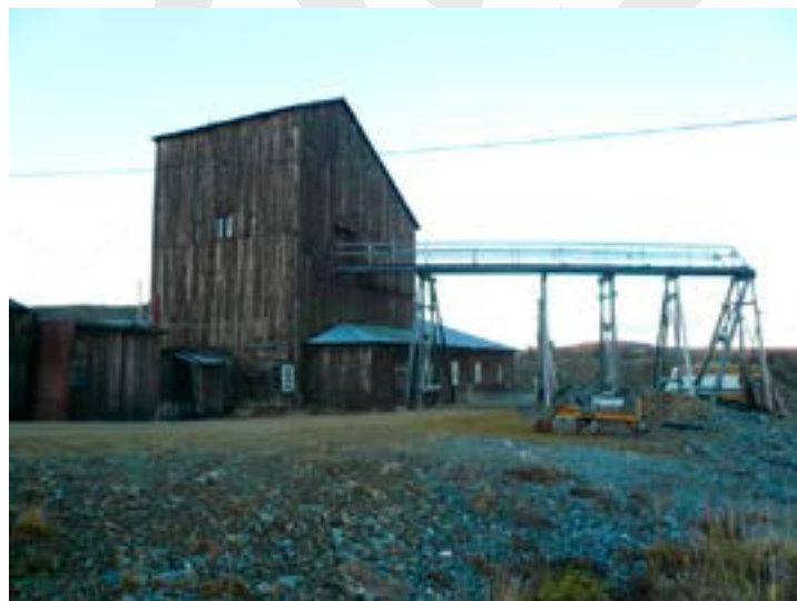
Heishuset med trallebane/rampe for transport av gråberg. Foto: Skjetne, Andreas Skogholt
