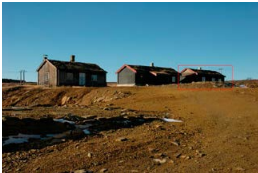
Snekkerverksted på Nedre Stortvart
