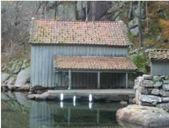
Bygget sett fra øst. Foto: Eirik T. Bøe, Miljøverndepartementet.
