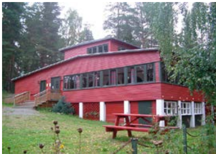
Vestfasaden Foto: Bent Ek
