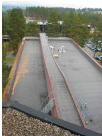
B-blokken mot nord sett fra testtårnet på B blokken Foto: Eirik T. Bøe
