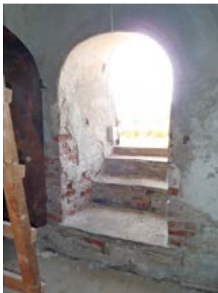
Inngangspartiet er teglmurt. Foto: M.Oftedal, Forsvarsbygg.
