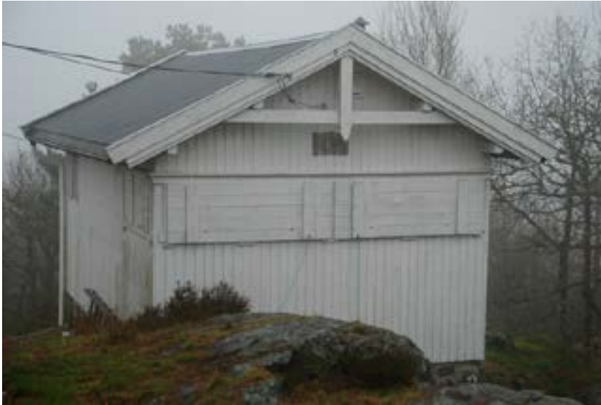
Sotåsen kystvakthytte er oppført etter typetegninger i panelt bindingsverk. Disse kystvakthytene var knyttet til den militære opprustningen før 1905, og ble plassert med vid utsikt over skipsleden Foto: Pål Alfred Larsen. Opphavsrett: Fylkesmannen i Vest-Agder.
