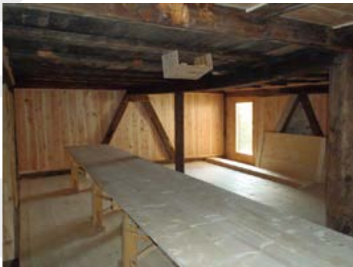
Bygningsvernbutikk, ny innvendig panel Foto: M. Oftedal, Forsvarsbygg
