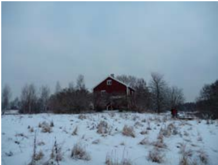
Fra sør, syrinlund til venstre for hovedbygningen. Foto: M.Oftedal, Forsvarsbygg.
