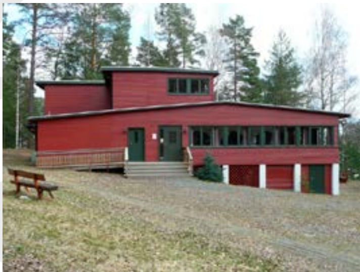
Restaurantbygning på Sundhaugen i Øvre Eiker. Foto: Åsmund Tysse. Opphavsrett: Fylkesmannen i Buskerud.
