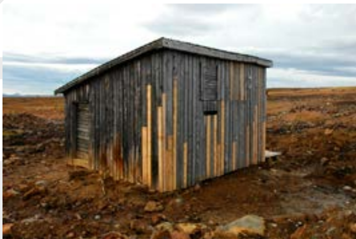
Heismaskinhus Storwartz Foto: Jon Holm Lillegjelten
