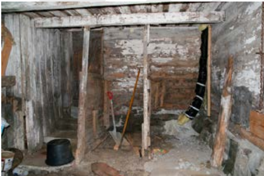
Fjøsdel med båser og inngang til våningshus Foto: Monica A. Rusten Opphavsrett: Monica A. Rusten©Riksantikvaren
