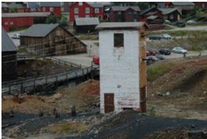
Trafokiosk på Kølplanken Foto: Jon Holm Lillegjelten
