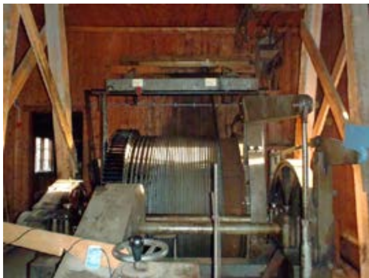
Heismaskinhuset Foto: M.Oftedal, Forsvarsbygg.
