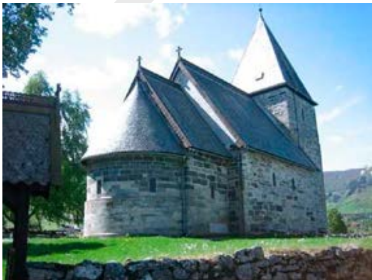
Foto: Ibenholt, Harald Opphavsrett: Harald Ibenholt © Riksantikvaren
