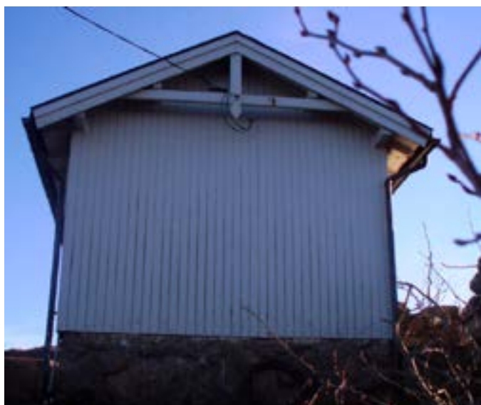
Hytta sett fra nord Foto: Svein Berge
