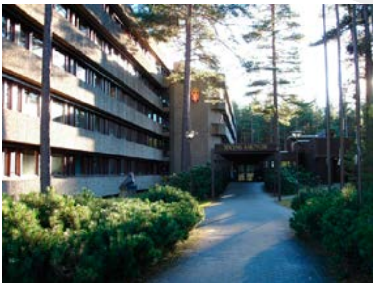
Hovedinngang, B-blokk t.v., A-blokk t.h. Foto: Eirik T. Bøe
