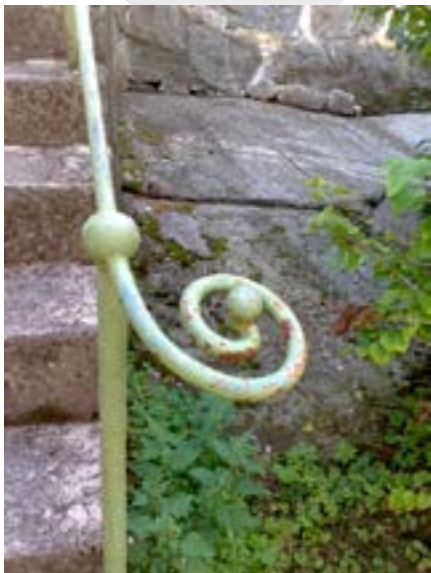
Håndløper på trapperekkerket Foto: Eirik T. Bøe Opphavsrett: Miljøverndepartementet
