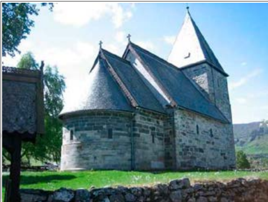
Foto: Ibenholt, Harald Opphavsrett: Harald Ibenholt © Riksantikvaren
