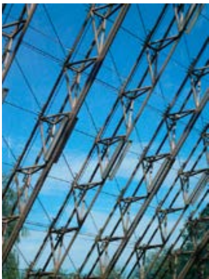
Den bærende konstruksjonen er bygget opp av sammensveiste stålrør. Foto: Ingrid Djupedal Opphavsrett: Ingrid Djupedal©Riksantikvaren
