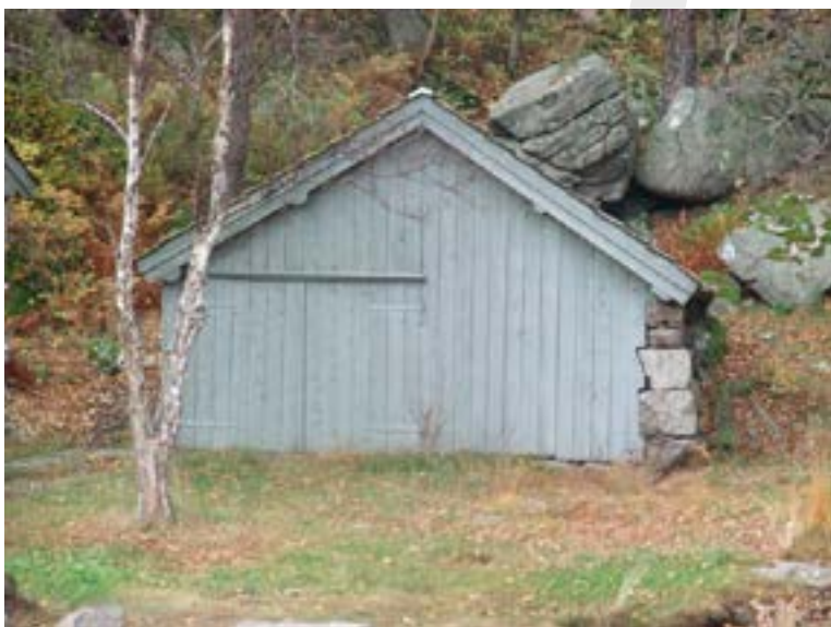
Fasade mot sør. Foto: Eirik T. Bøe, Miljøverndepartementet.
