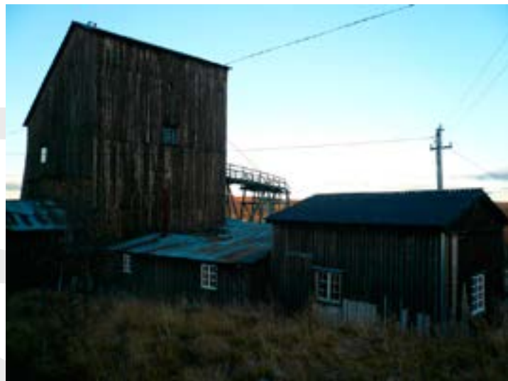
Fra v heishus, smie og heismaskinhus. Foto: Skjetne, Andreas Skogholt
