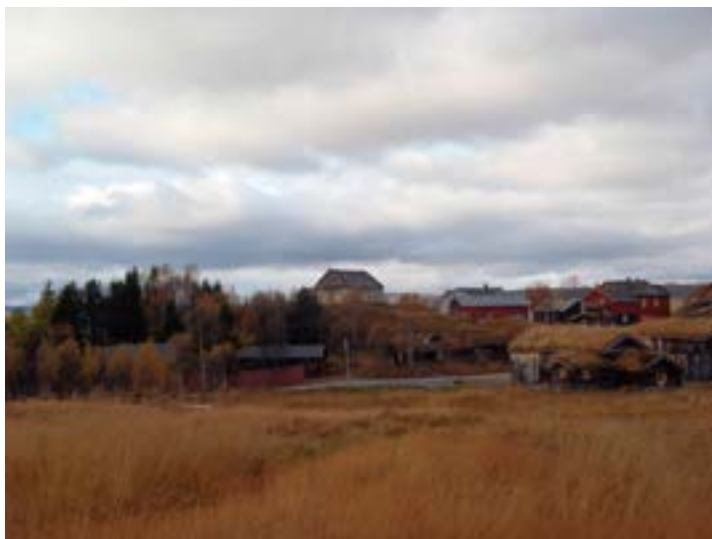
Krutthuset fra nord-øst. Foto: M.Oftedal, Forsvarsbygg.
