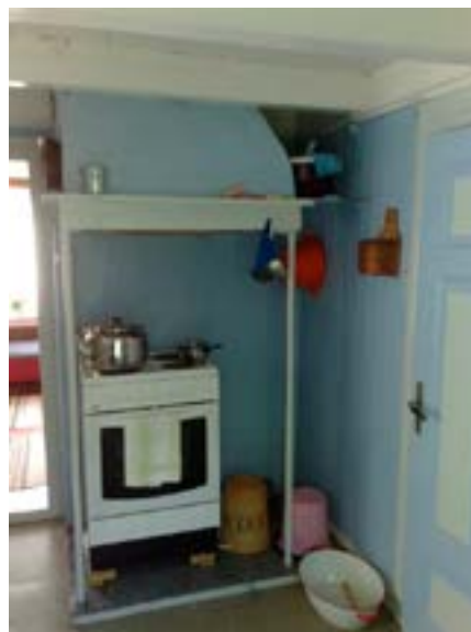
Grue på kjøkken Foto: Eirik T. Bøe
