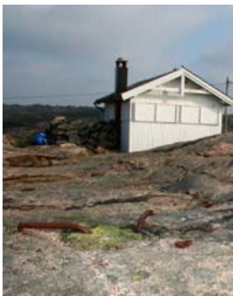
Hytta sett fra sør med festebolter for signalmasten Foto: Svein Berge
