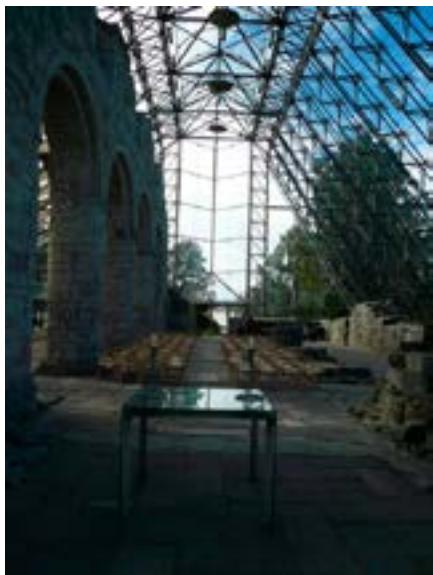
Vernebygget er en teknisk konstruksjon, som samtidig danner et sakralt rom Foto: Ingrid Djupedal Opphavsrett: Ingrid Djupedal©Riksantikvaren
