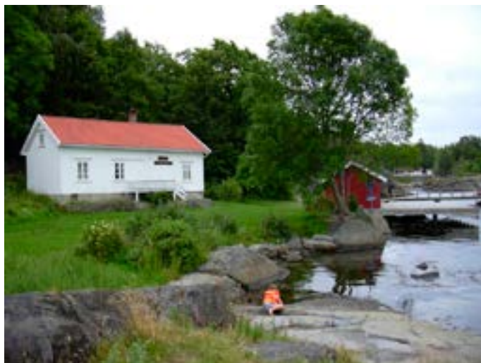
Hovedhuset sett fra nordvest, sjøbua i bakgrunnen. Foto: Fylkesmannen i Telemark.
