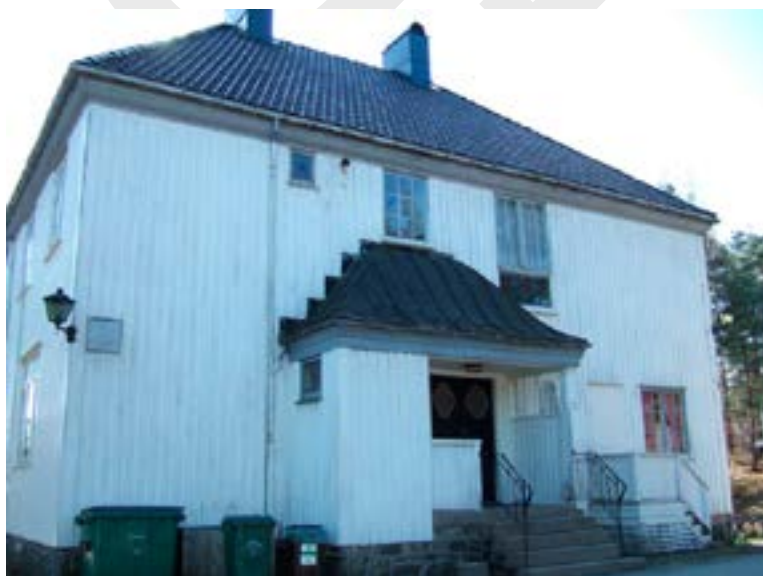
Direktørboligen sett fra nord, inngangspartiet Foto: Gunnar Ogwyn Lindaas. Opphavsrett: Fylkesmannen i Aust-Agder.
