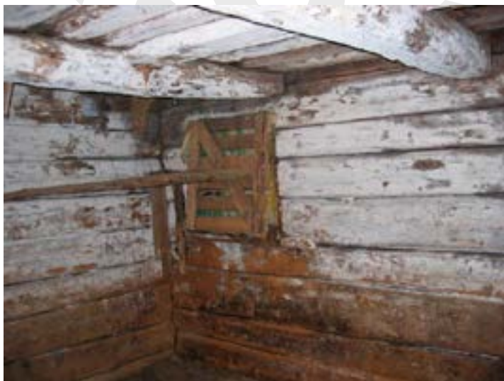
Hvitkalkede vegger og himling i stall som sist har blitt brukt som sauefjøs. Foto: Einar Engen Opphavsrett: Statsbygg
