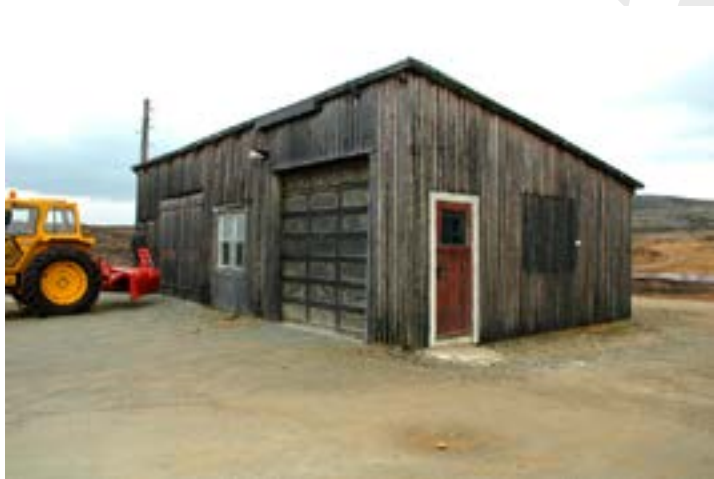
Verkstedbygg med traktorgarasje Foto: Jon Holm Lillegjellen
