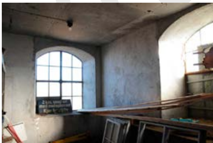
Interior rom mot øst.
