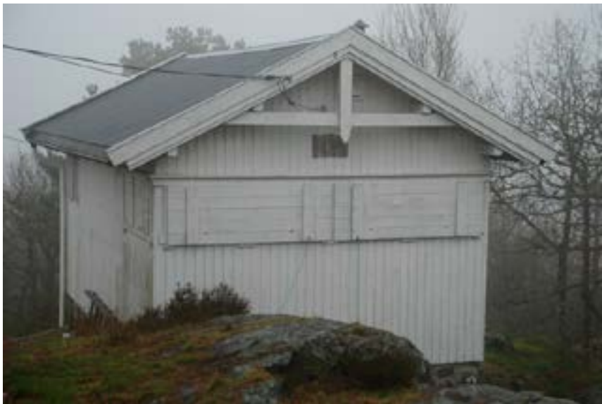
Sotåsen kystvakthytte er oppført etter typetegninger i panelt bindingsverk. Disse kystvakthyttene var knyttet til den militære opprustningen før 1905, og ble plassert med vid utsikt over skipsleden Foto: Pål Alfred Larsen. Opphavsrett: Fylkesmannen i Vest-Agder.
