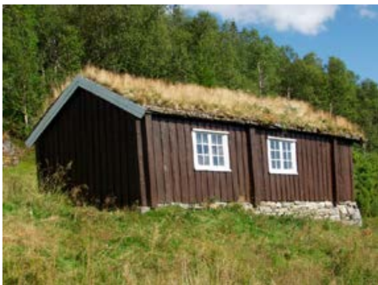
Masstuggu sett fra nordvest. Foto: Einar Engen Opphavsrett: Statsbygg
