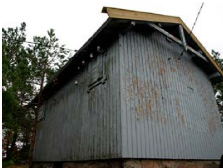
Hytta har innlagt strøm. Sett fra det nordligste hjørnet. Foto: Kenneth Harbak/ Søgne kommune
