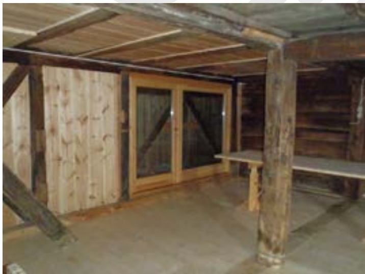
Bygningsvernbutikk, nytt dørfelt mot vest Foto: M.Oftedal, Forsvarsbygg
