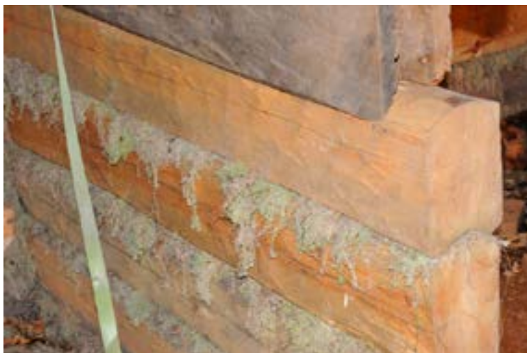
Ny tømmervegg med innlagt husmose.
