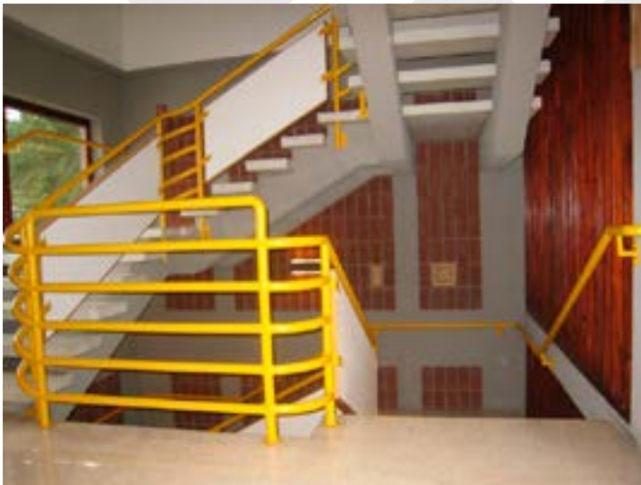
Sett mot nordveggen Foto: Eirik T. Bøe
