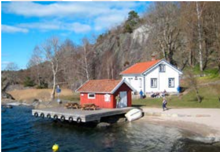
Hovedbygning og naust/sjøbu Foto: Kjell Ivar Brynsrud
