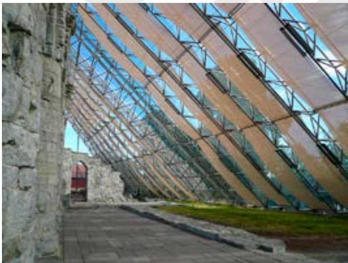
Solskjerming ved automatiserte solduker, samt strålevarmeovner montert i stålkonstruksjonen og rettet ned mot ruin og bakke. Foto: Ingrid Djupedal Opphavsrett: Ingrid Djupedal©Riksantikvaren
