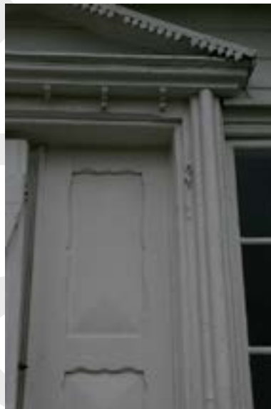
Detalj inngang sørvest Foto: Monica A. Rusten Opphavsrett: Monica A. Rusten©Riksantikvaren
