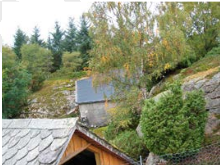
låven og betong cisternen Foto: Eirik T. Bøe Opphavsrett: Miljøverndepartementet
