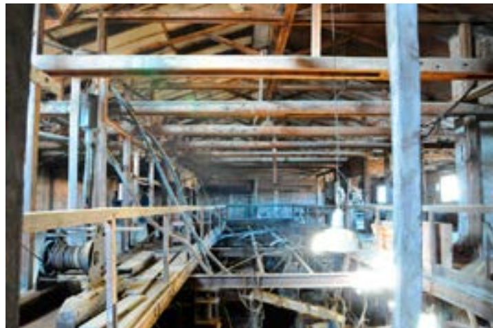
Flotasjonen, 2. etg, ser ned på flotasjonskarene.
