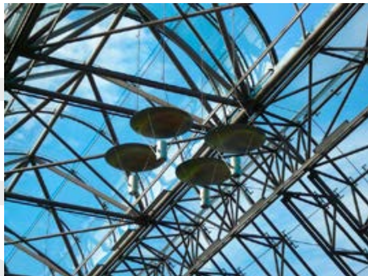
I byggets sentrale akse henger ti pendelarmaturer ned fra den sentrale mønestrageren. Foto: Ingrid Djupedal Opphavsrett: Ingrid Djupedal©Riksantikvaren
