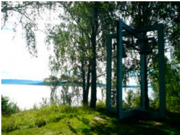
Støpul utført i galvanisert stål Foto: Ingrid Djupedal Opphavsrett: Ingrid Djupedal©Riksantikvaren
