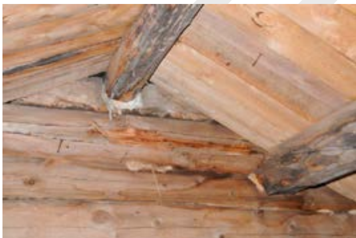
Tømmervegg og ny taktro.
