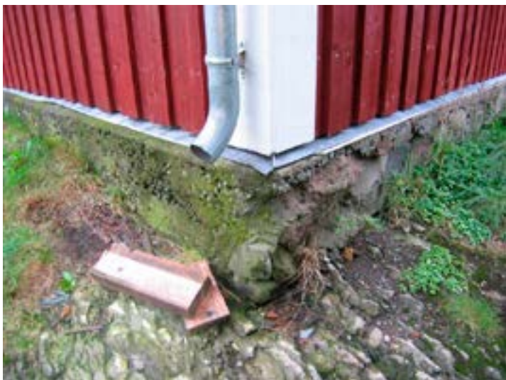
Detaljfoto av fundament som viser blanding av betong og naturstein. Foto: Erik Ruud Opphavsrett: Statsbygg
