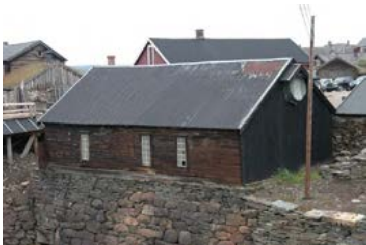
Nedre maskinhus sett fra Kølplanken Foto: Jon Holm Lillegjelten
