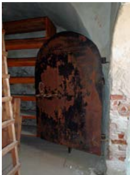
Innvendig jerndør. Foto: M.Oftedal, Forsvarsbygg.
