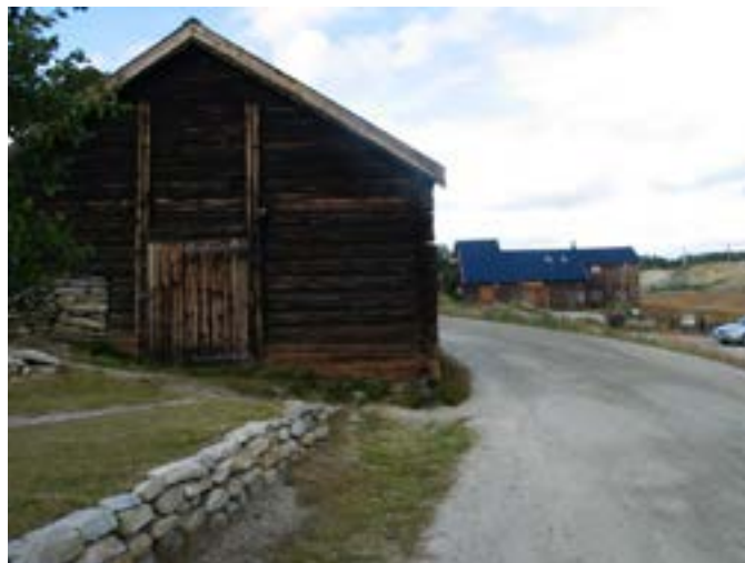
Tørkhuset mot Sørvest
