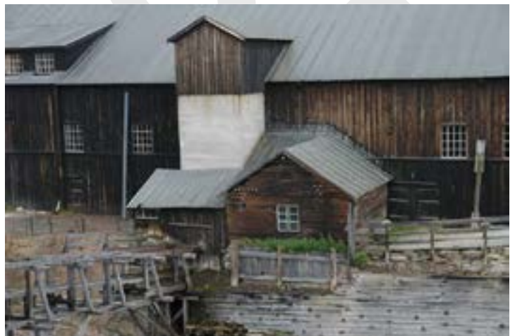
Øvre maskinhus til høyre med saltak Foto: Jon Holm Lillegjelten
