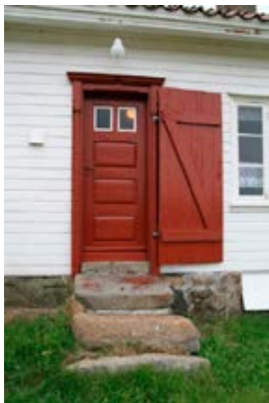
Våningshus inngang fra nordøst Foto: Monica A. Rusten Opphavsrett: Monica A. Rusten©Riksantikvaren
