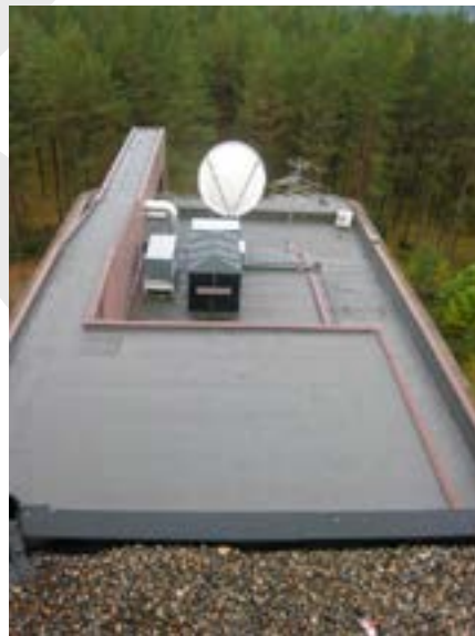
B-blokken mot syd sett fra testtårnet på B blokken Foto: Eirik T. Bøe
