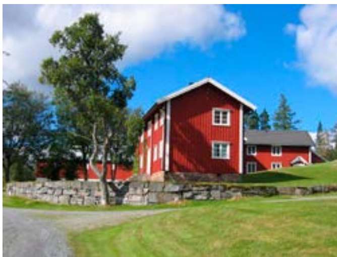
Nilsstuggu i forgrunnen med tilbygget til Pærstuggu til høyre og driftsbyggingen til venstre. Foto: Einar Engen Opphavsrett: Statsbygg
