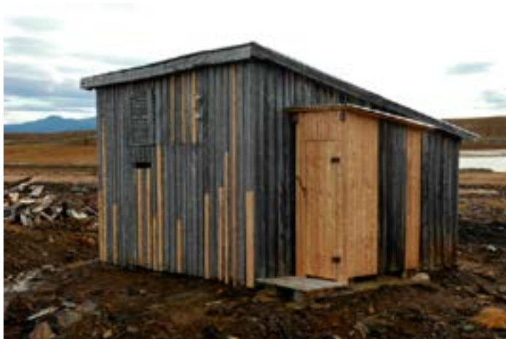
Heismaskinhus Storwartz Foto: Jon Holm Lillegjelten
