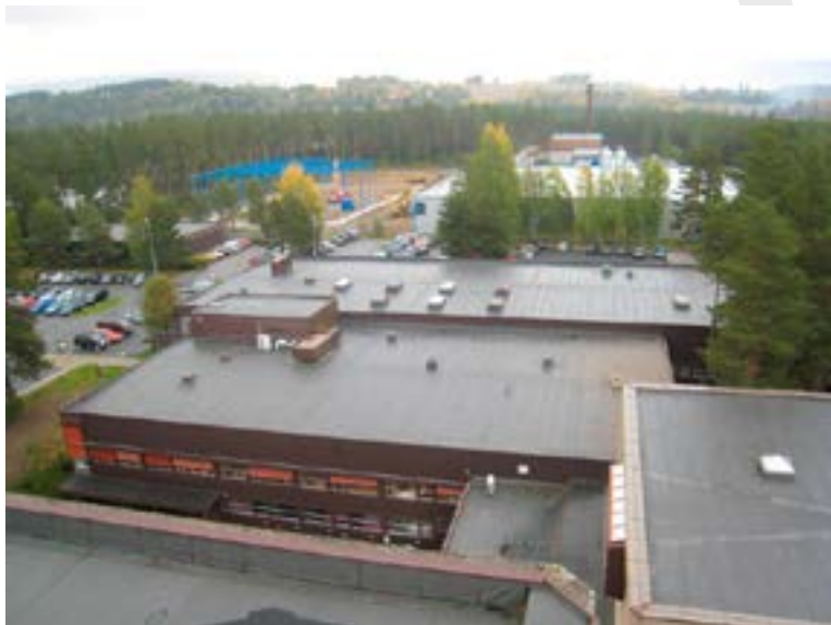
C og deler av E blokkene sett fra testtårnet på B blokken Foto: Eirik T. Bøe
