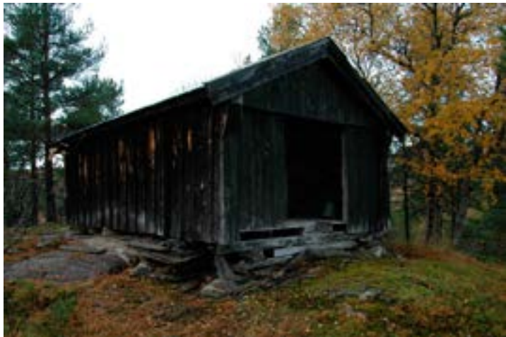
Langlidalshytta fra inngangssiden. Foto: M. Oftedal, Forsvarsbygg.
