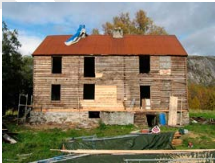
Fra restaureringen høsten 2009 Foto: Odd Svein Hjørtø Opphavsrett: Steigen kommune
