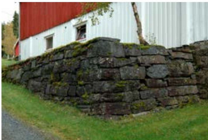
Mur på vestsiden av driftsbygningen. Foto: M. Oftedal, Forsvarsbygg.
