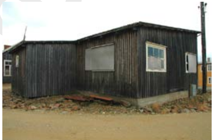
Verkstedbygg med traktorgarasje Foto: Jon Holm Lillegjellen
