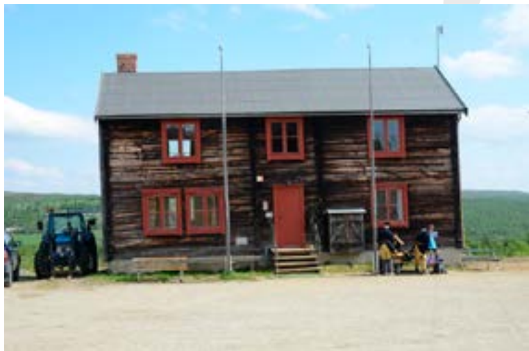
Kafeybygningen på Olavsgruva Foto: Jon Holm Lillegjelten
