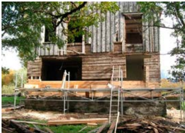
Fra restaureringen høsten 2009 Foto: Odd Svein Hjertø Opphavsrett: Steigen kommune
