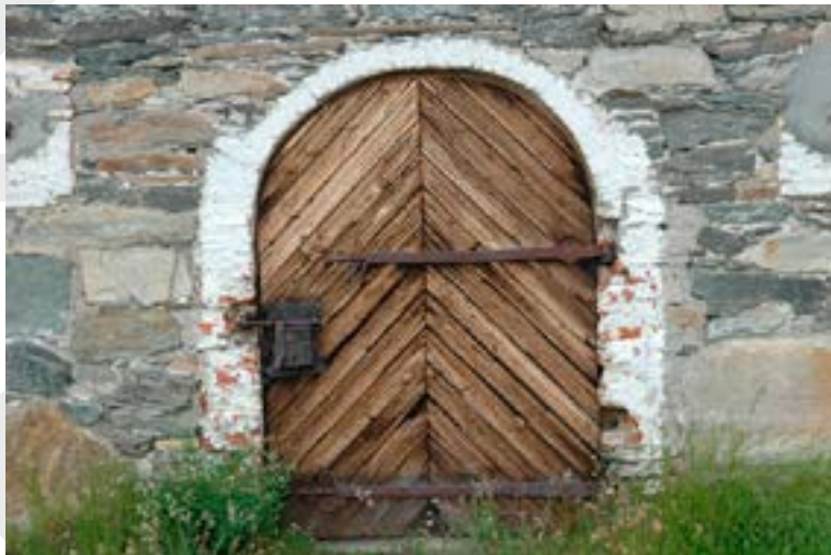
Inngangsdør på Krutthuset, teglmurte partier rundt åpningen. Foto: Jon Holm Lillegjellen
