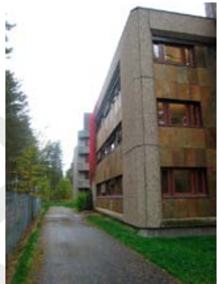
E-blokk, sydfasaden Foto: Eirik T. Bøe
