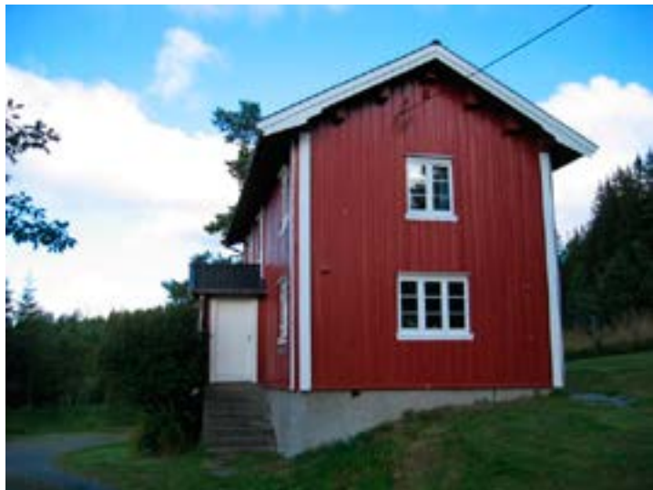
Østre fasade og inngangsparti på langvegg mot syd. Foto: Einar Engen Opphavsrett: Statsbygg
