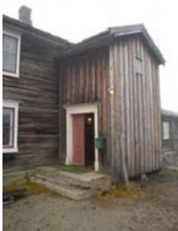
Kontorbygningen Foto: Skjetne, Andreas Skogholt Opphavsrett: Andreas Skogholt Skjetne &#169; Riksantikvaren
