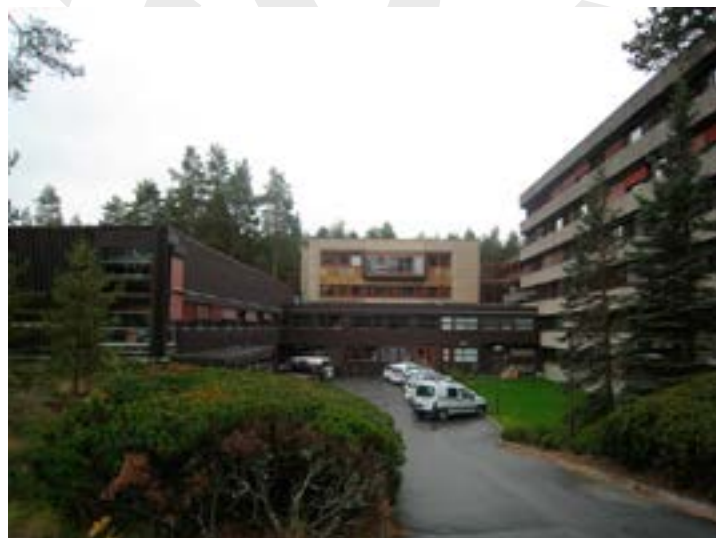
Nordfasaden mellom C- og B-blokk
