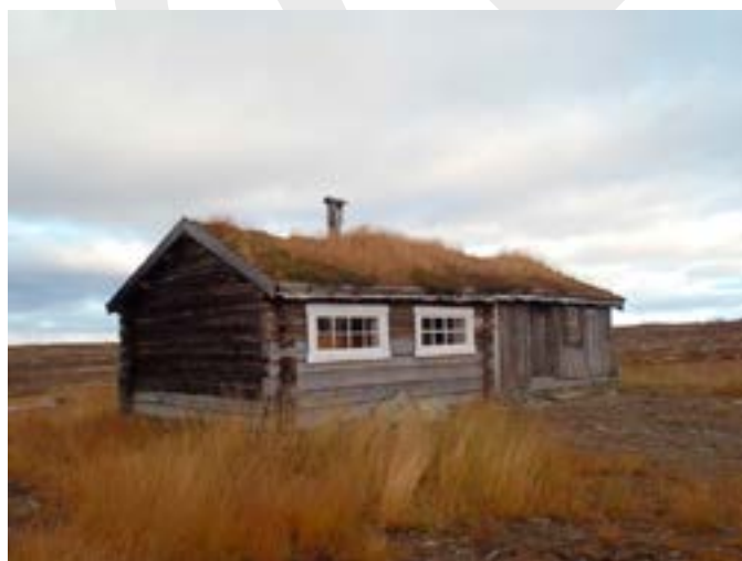
Bygningen etter restaurering, 2012. Vinduer er restaurert og omramming kopiert/tilbakeført (2011). Foto: M.Oftedal, Forsvarsbygg.
