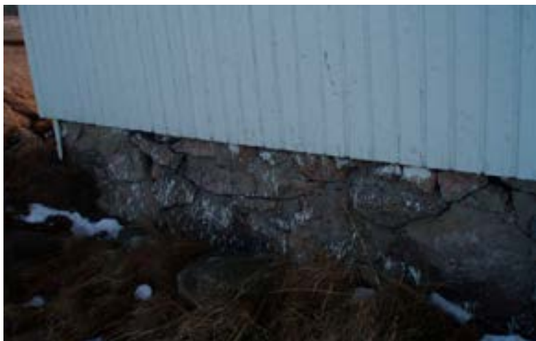
Kledning på sørsiden Foto: Svein Berge
