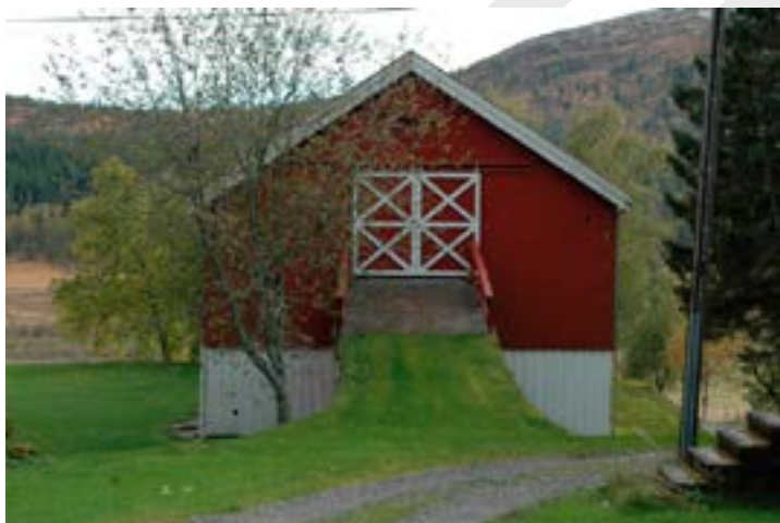
Fasade N. Foto: M. Oftedal, Forsvarsbygg.
