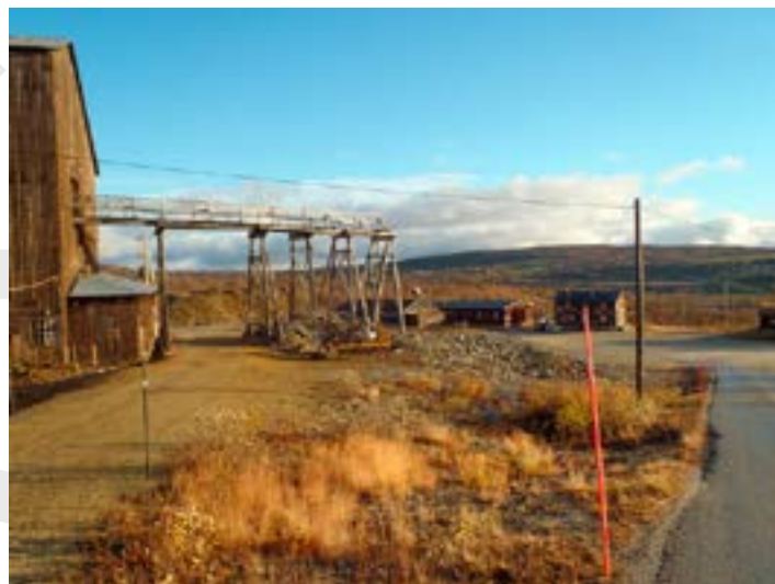
Olavsgruva, Heishuset til venstre. Foto: M.Oftedal, Forsvarsbygg.
