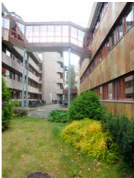
Korridor i luften mellom B- og E-blokk Foto: Eirik T. Bøe
