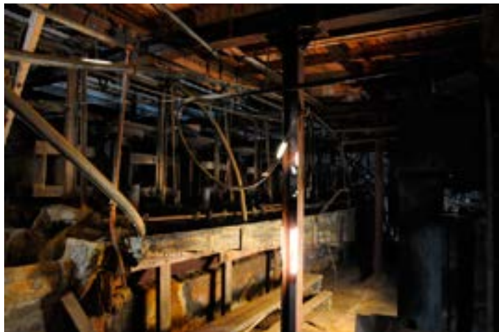
Flotasjonsrenne, 1. etg i flotasjonen.
