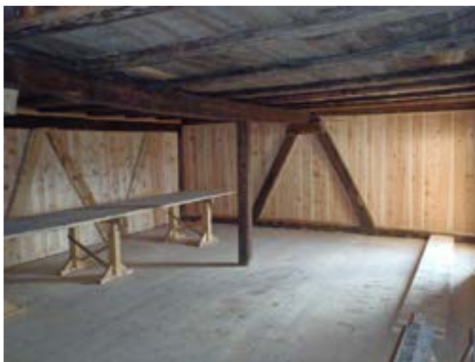
Bygningsvernbutikk, ny innvendig panel 2011 Foto: M. Oftedal, Forsvarsbygg
