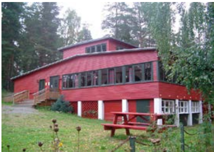
Vestfasaden Foto: Bent Ek
