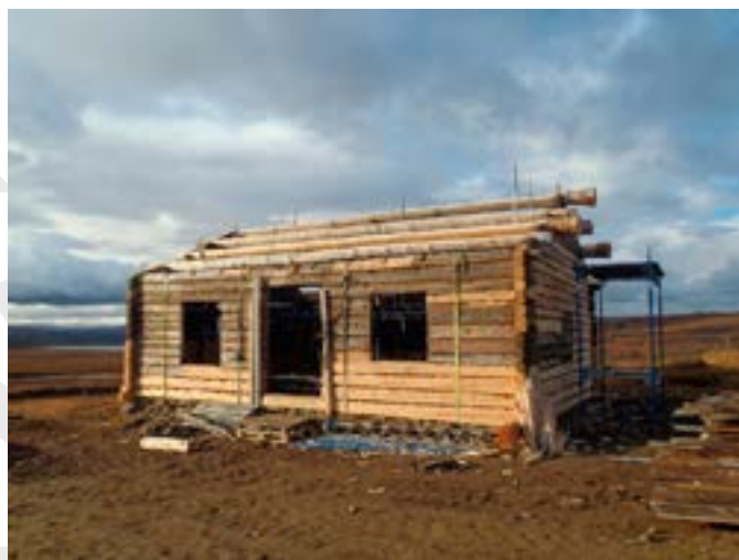
BYgningen under restaurering oktober 2012. Foto: M.Oftedal, Forsvarsbygg.
