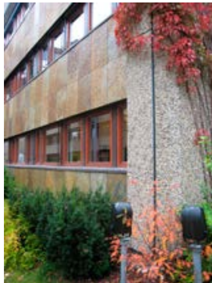
E-blokk, hjørnet mot sydvest Foto: Eirik T. Bøe
