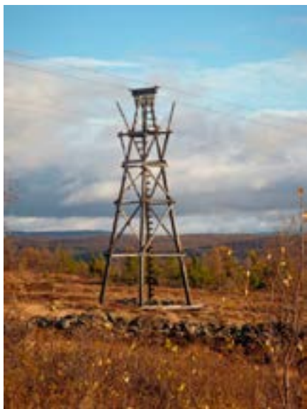
Taubanebukk Foto: M.Oftedal, Forsvarsbygg.
