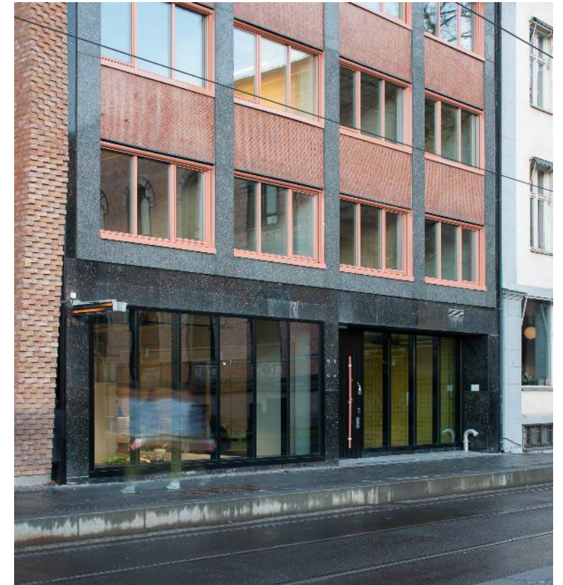
Glassfasade i 1.etg mot Kristians August gate
