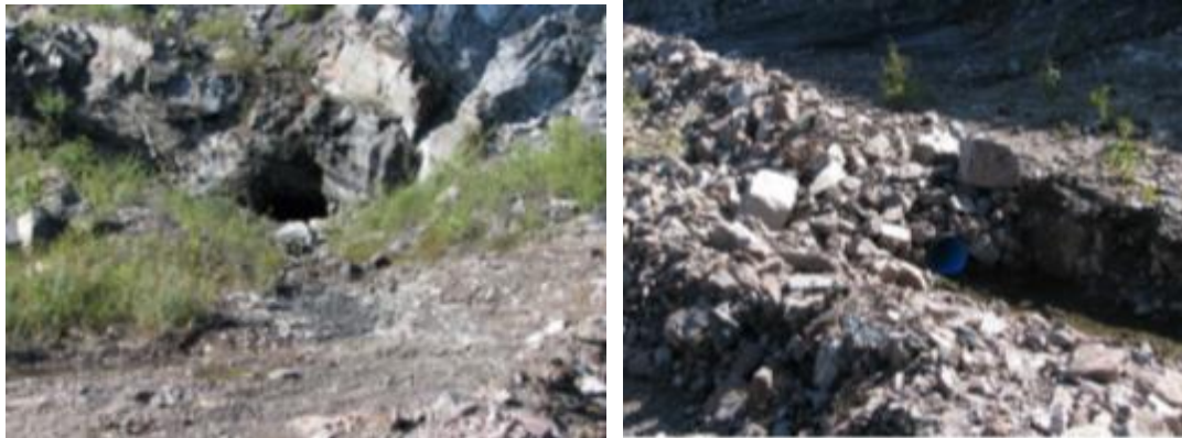
Figur: Avskåret oppstrøms drenering Deponi 2 (midlertidig tiltak). August 2009.
