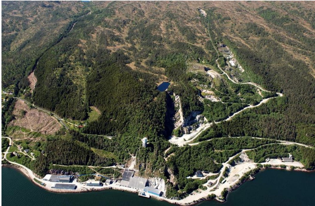
Figur: Eksisterende område ved Raudsand. Aktuell situasjon. Legg merke til lavinen midt på fotografiet, denne har sin årsak i sammenrasning av deler av den gamle gruven.
