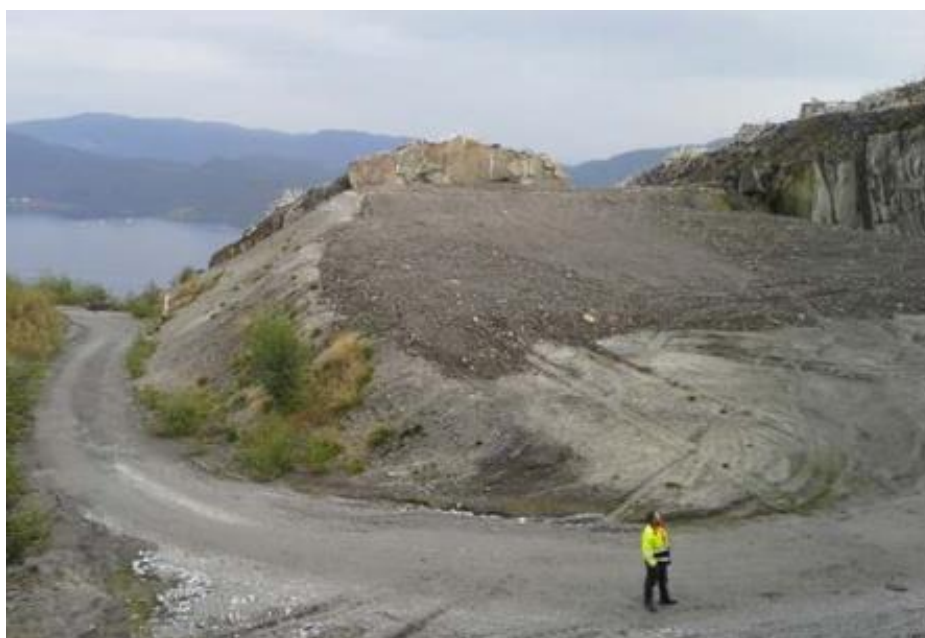
Figur: Oversiktsbilde av deponi 1 tatt 23. september 2014. På det tidspunktet bildet ble tatt, ble masser fra overflaten lagt til som en del av stengetiltaket.
