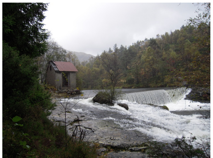
Demning sett fra ca. nv. Pumpehus t.v. Foto: Ole Hovland.
