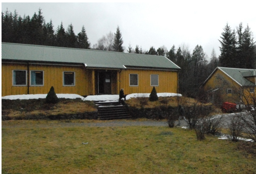
Badebrakka, bygg 11, t.v. sett fra NØ med bygg 7 t.h. Foto: Leif Anker.
