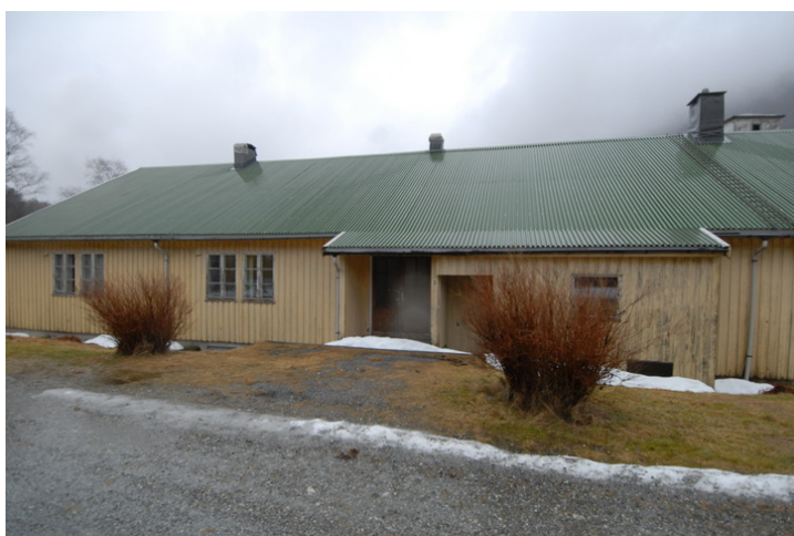
Inngangsparti i sør. Foto: Leif Anker, Forsvarsbygg.
