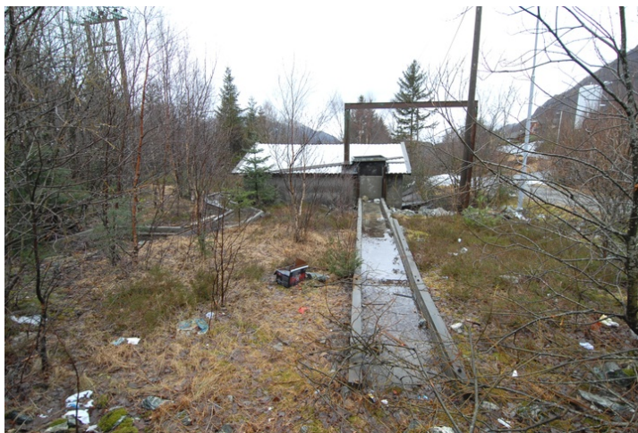
Øvingsbane med skur sett mot nord. Foto: Leif Anker.
