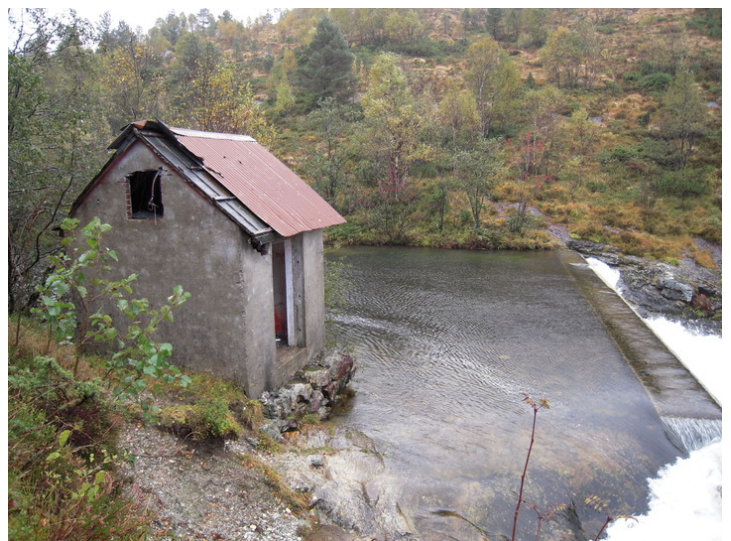
Pumpehus og demning sett ca. mot sør. Foto: Ole Hovland.
