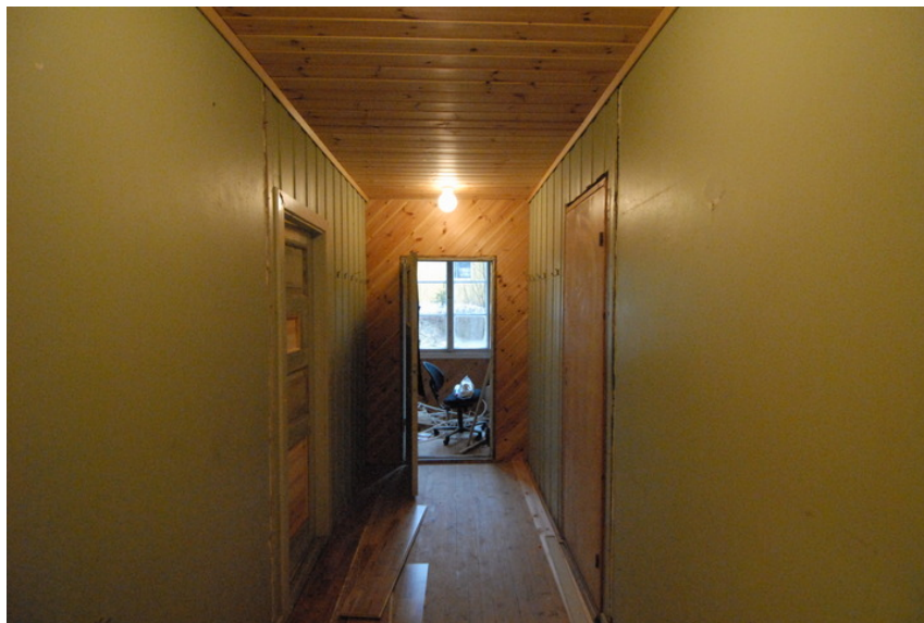
Midtkorridor mot sør. Foto: Leif Anker, Forsvarsbygg.
