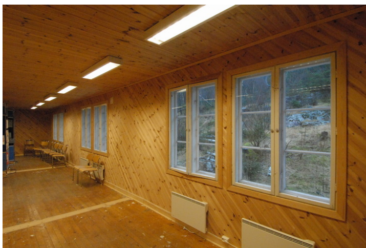
Utstillingsrom vest vindusrekke. Foto: Leif Anker, Forsvarsbygg.
