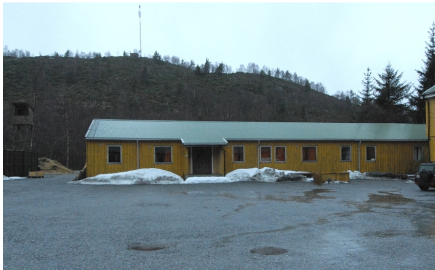
Bygg 2, forlegningsbrakke I, sett mot vest. Foto: Leif Anker.
