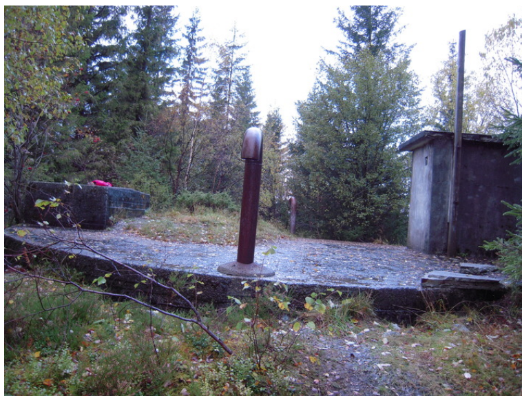
Pumpestasjon t.h. på vanntank sett fra ca. sø. Foto: Ole Hovland.
