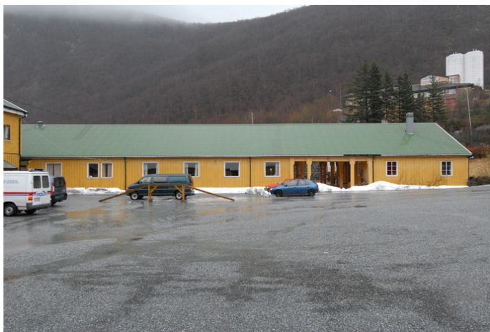
Bygg 5, adm.bygg, sett fra vest. Foto: Leif Anker.
