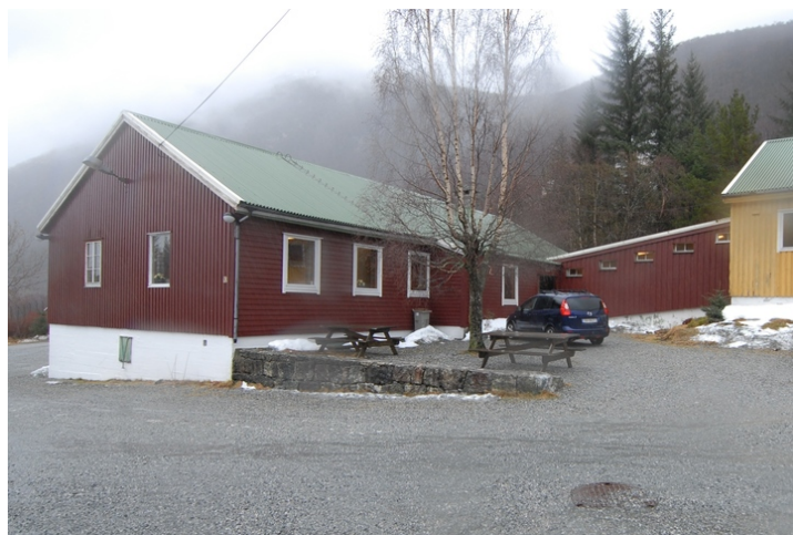
Bygg 10, kjøkken og befalsmesse, sett fra SV. Foto: Leif Anker.
