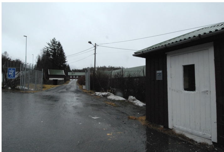
Hovedport med vaktbu sett fra nord. Foto: Leif Anker.
