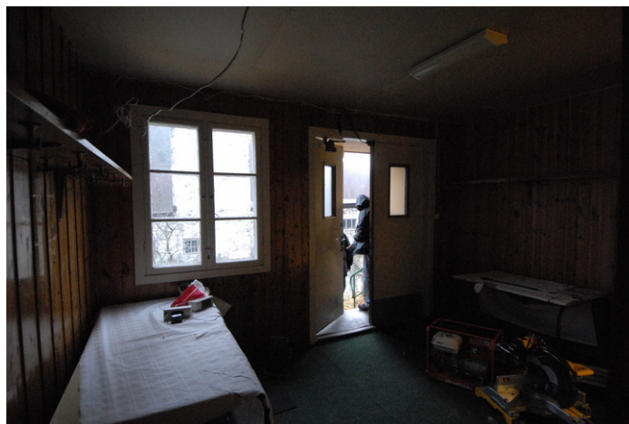
Vindfang mot ytterdør. Foto: Leif Anker, Forsvarsbygg.
