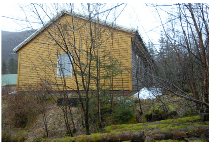
Fasade mot vest og sør, supanel. Foto: Leif Anker, Forsvarsbygg
