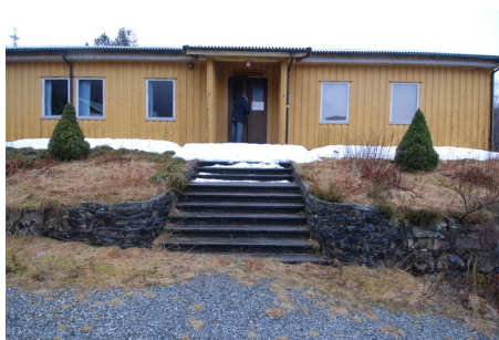
Trapp og mur til inngangsparti. Foto: Leif Anker.
