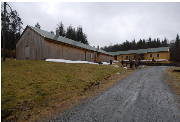
"Lenkebrakka" sett fra nordøst. Foto: Leif Anker, Forsvarsbygg.
