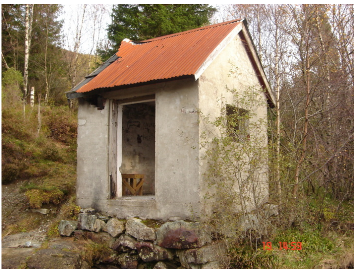
Pumpehuset sett fra ca. sørvest. Foto: Ole Hovland.
