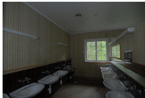
De sannsynligvis opprinnelige servant-veggene er intakte. Foto: Leif Anker, Forsvarsbygg.
