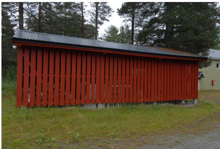
Skjulet sett fra nord. I bakgrunnen skimtes magasin/undervisningsbygget. Foto: Leif Anker, Forsvarsbygg.
