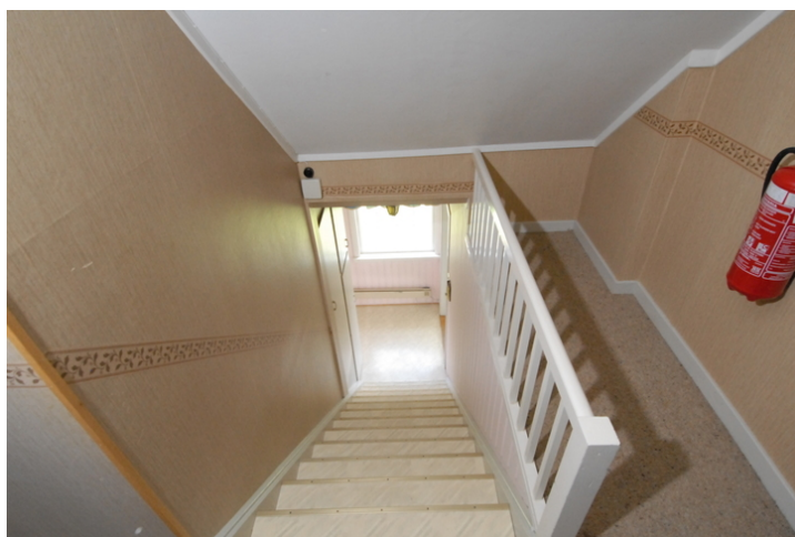
Trappeløp. Foto: Leif Anker, Forsvarsbygg.
