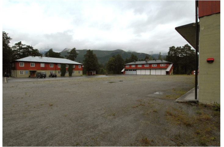
Plassen sett fra sør. Foto: Leif Anker, Forsvarsbygg.
