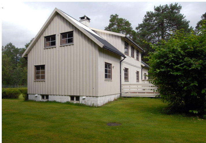
Boligen sett fra nord. Foto: Leif Anker, Forsvarsbygg.
