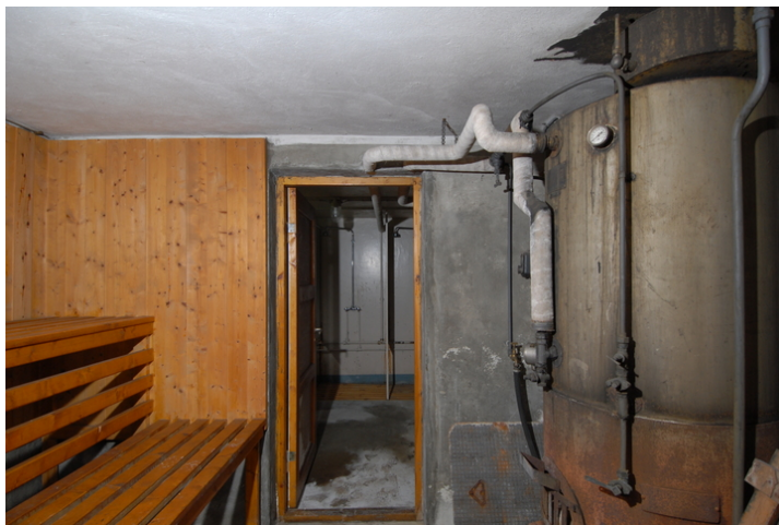
Badstu kjeller. Foto: Leif Anker, Forsvarsbygg.
