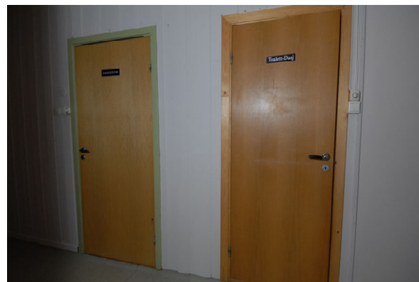
Dører mot våtrom. Foto: Leif Anker, Forsvarsbygg.
