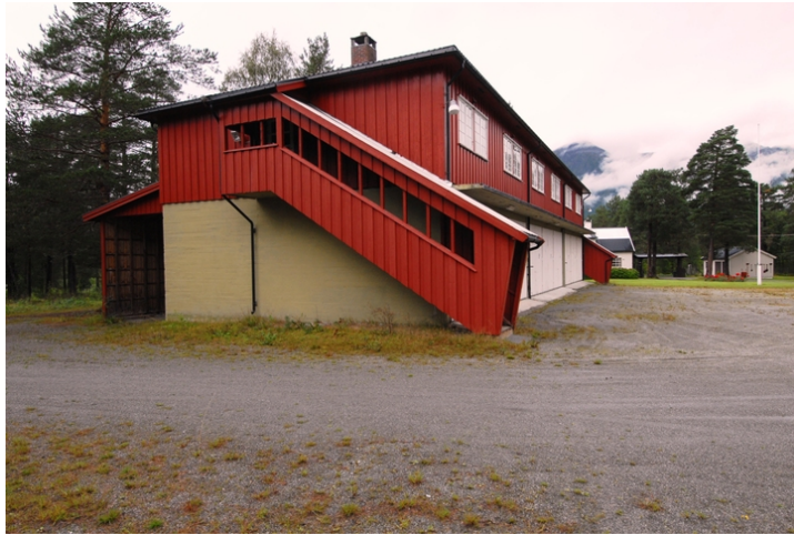
Brakke 1 sett fra sørøst. Foto: Leif Anker, Forsvarsbygg.
