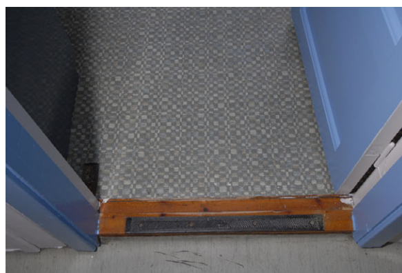
Opprinnelig gulvbelegg på forlegningsrommene. Foto: Leif Anker, Forsvarsbygg.
