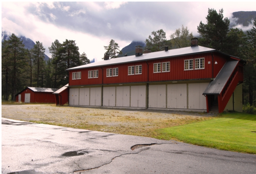
Brakke 1 sett fra nordøst. Foto: Leif Anker, Forsvarsbygg.
