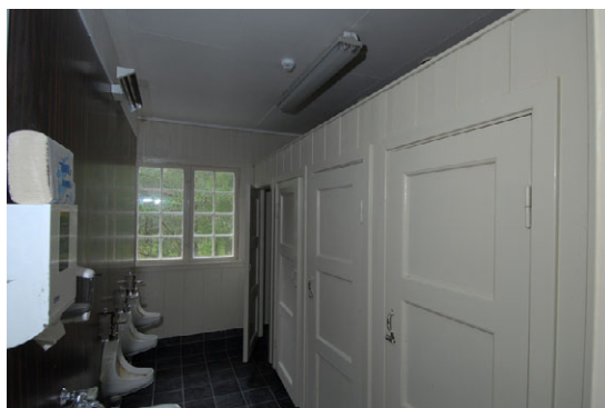
Herretoalett m opprinnelige avlukker. Foto: Leif Anker, Forsvarsbygg.
