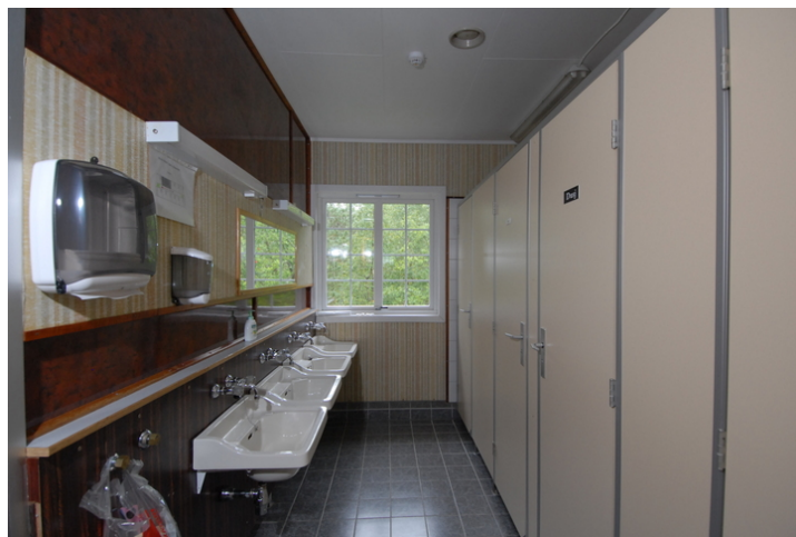
Bad/toalett. Foto: Leif Anker, Forsvarsbygg.
