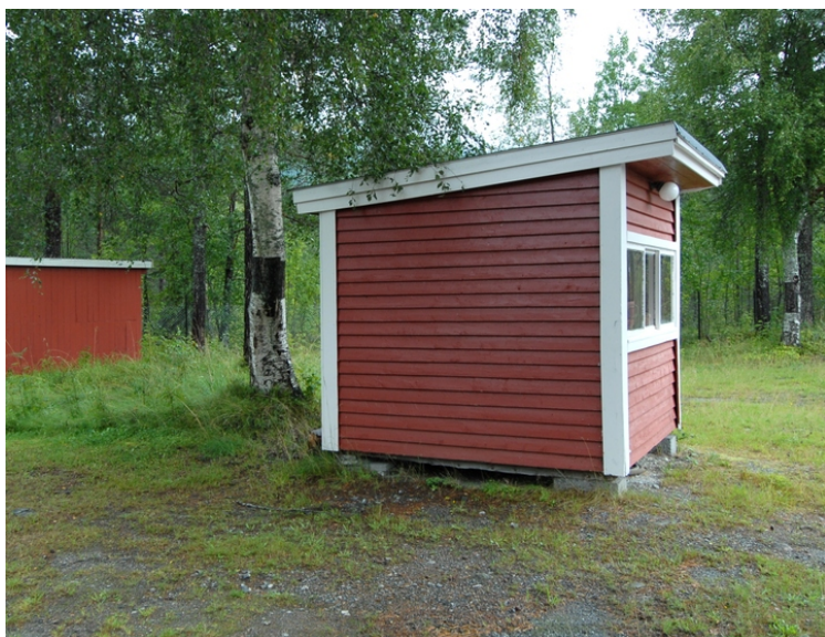
Kiosken er flyttbar, og står i 2009 mellom Adm.bygg og Brakke 3. Foto: Leif Anker, Forsvarsbygg.
