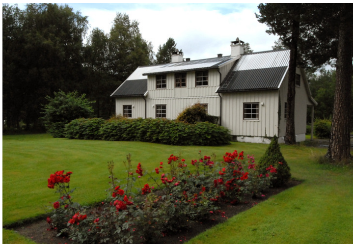
Boligen sett fra sørøst. Foto: Leif Anker, Forsvarsbygg.
