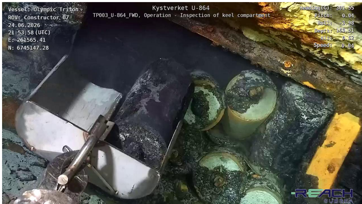
Figur 17 Uttak av kvikksølvbeholder fra kjølkassen
