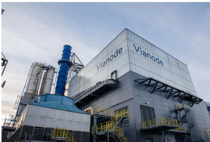
Figur 36 - Vianode fabrikk Via ONE på Herøya Industripark (Foto: Vianode)
