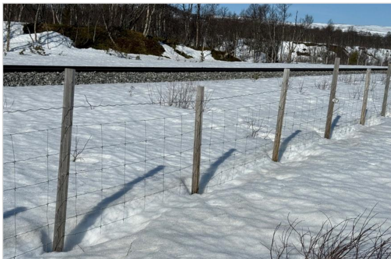
Figur 7-2. Eksempel på relativt nylig etablert sperregjerde for rein som følger jernbanen ved Galåen. Dette gjerdet er ca. 125 cm høyt.
