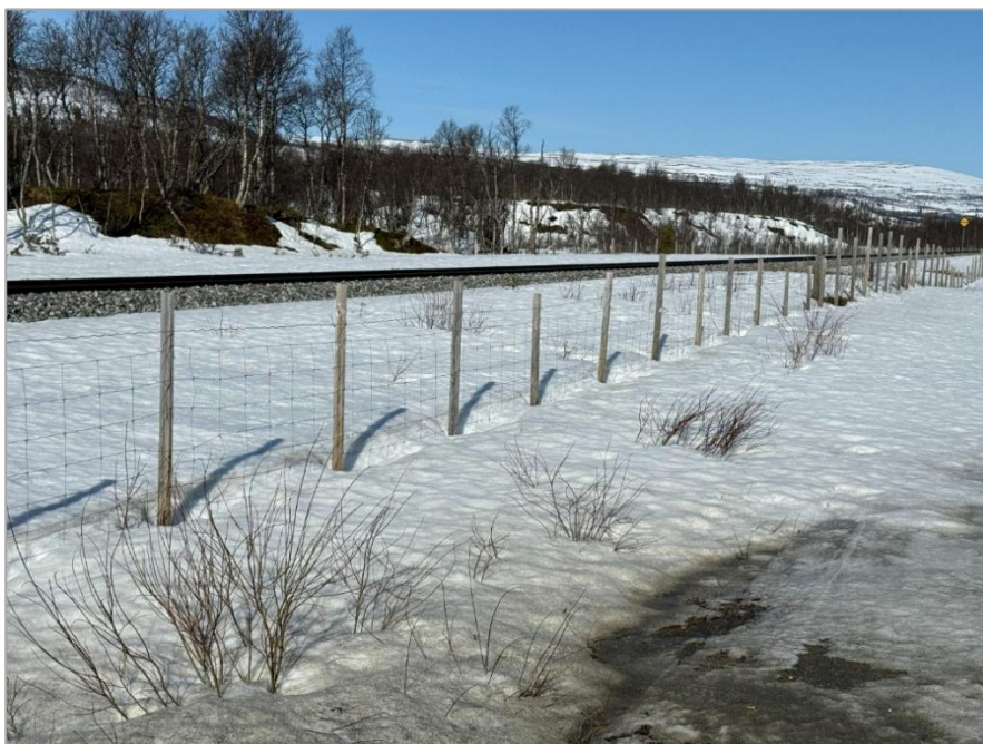
Figur 9-2. Eksempel på sperregjerde for rein etablert langs jernbanen ved Glåmos. Foto: Torgeir Isdahl.
