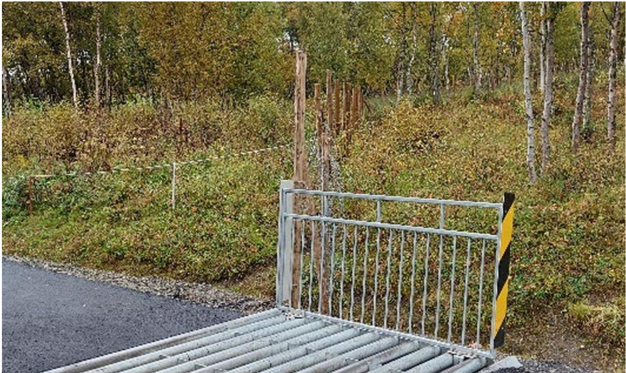
Figur 10-16 Eksempel på aktuelt sperregjerde inn mot ferist (Foto: I. Hansen). Foto hentet fra NIBIO-rapporten «Vurdering av gjerdeløsninger for rein» (NIBIO, 2023)
